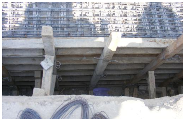
Figura 4.39. Colocación de puntales.
