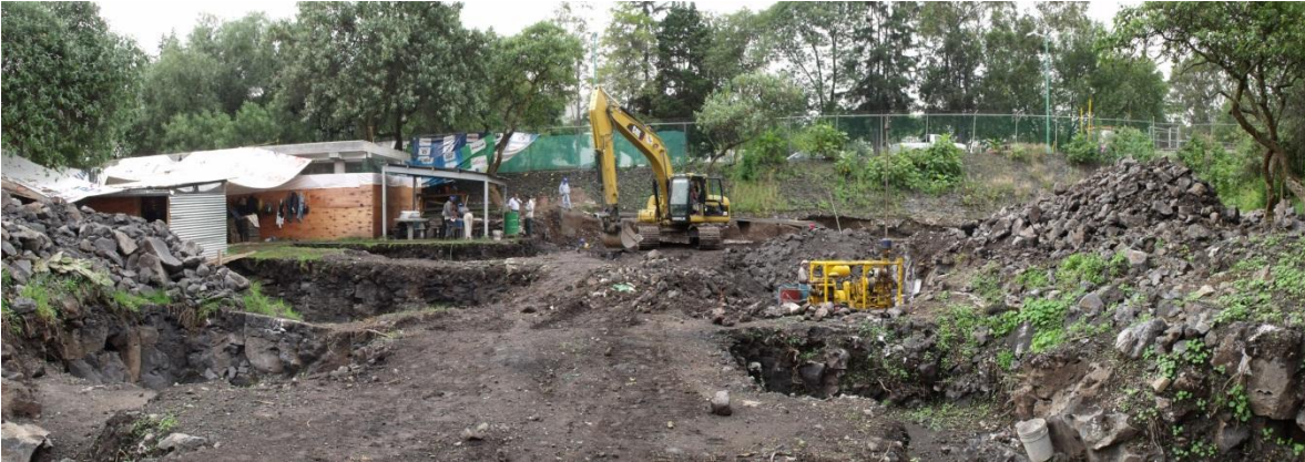
Figura 3.12. Exploración mediante técnicas de sondeo con equipo rotatorio.
