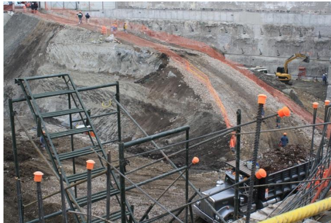
Figura 4.4. Seguridad en el acceso.
