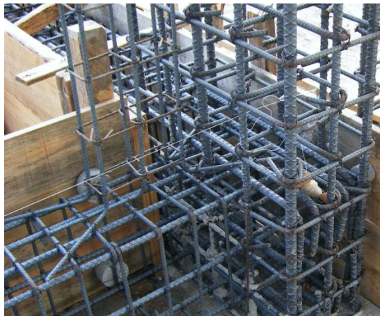
Figura 4.38. Intercepción del acero y cimbrado en muros.
