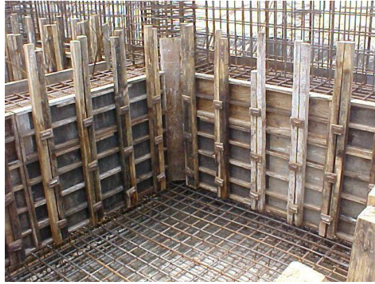
Figura 4.37. Colocación de cimbra en los muros de cimentación
