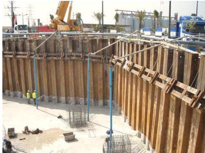
Figura 3.30. Tablestacas arriostradas con anclajes.
