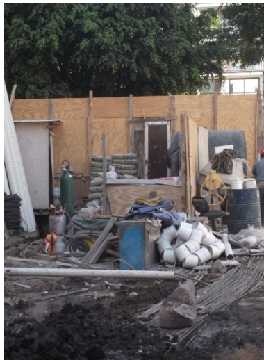
Figura 4.24. Errores comunes en el almacenamiento del acero (exposición directa a los factores ambientales).
