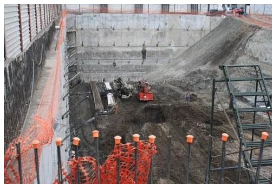
Figura 4.14. Uso de anclas en excavaciones profundas.
