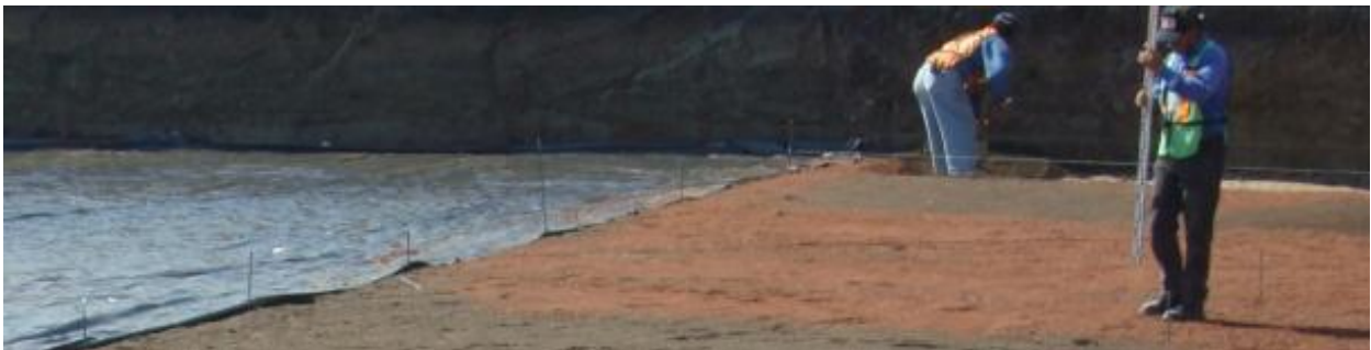
Figura 4.47. Colocación de la membrana impermeable.
