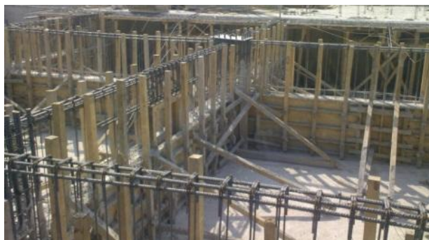
Figura 4.36. Muro de cimentación.
