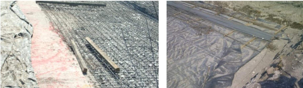
Figura 4.49. Membrana impermeable y habilitación del acero.
