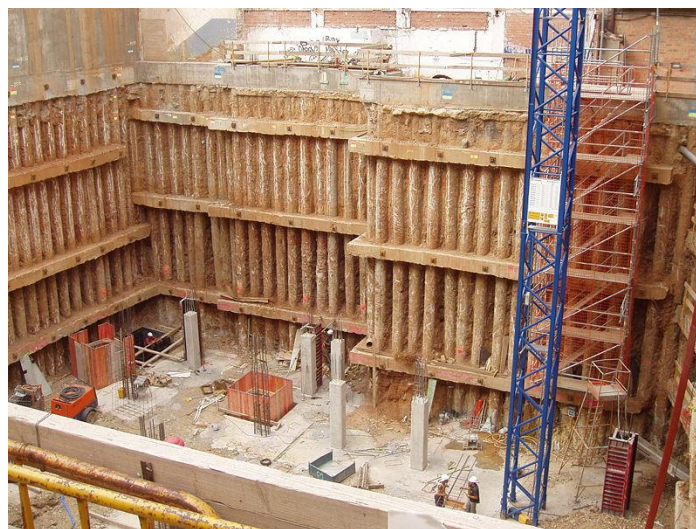
Figura 3.32. Pilas secantes.
