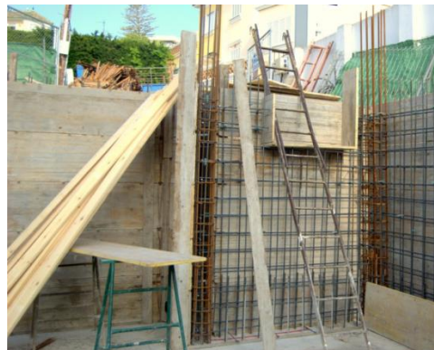
Figura 4.8. Colocación de madera como estructura provisional.
