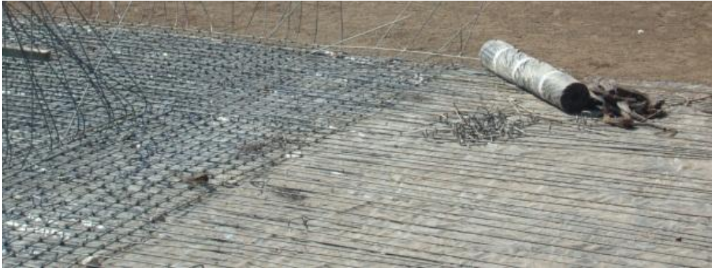
Figura 4.48. Membrana impermeable y acero.
