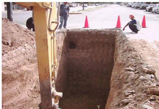
Figura 4.2. Excavación en etapas.
