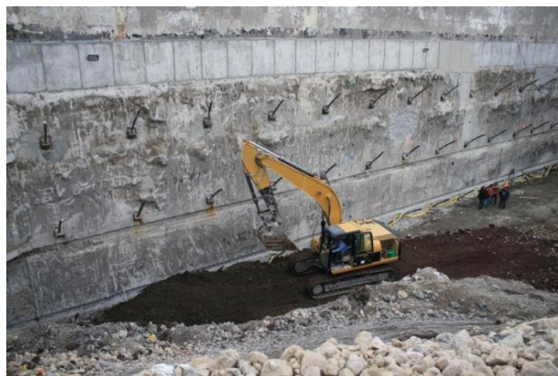
Figura 4.6. Excavación conforme al avance en la colocación de la estructura de contención.
