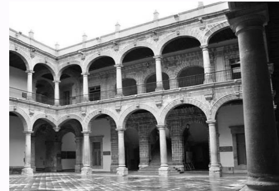
5. Patio central con columnas de cantera en el Palacio de Medicina
