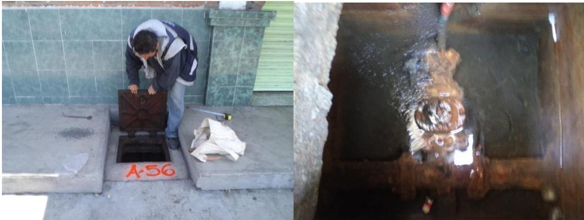
**FIGURA A. 18 LA CAJA DE VÁLVULAS A-56 SE ENCUENTRA INUNDADA CON GRASA CON UN TIRANTE DE 0.55 M**
