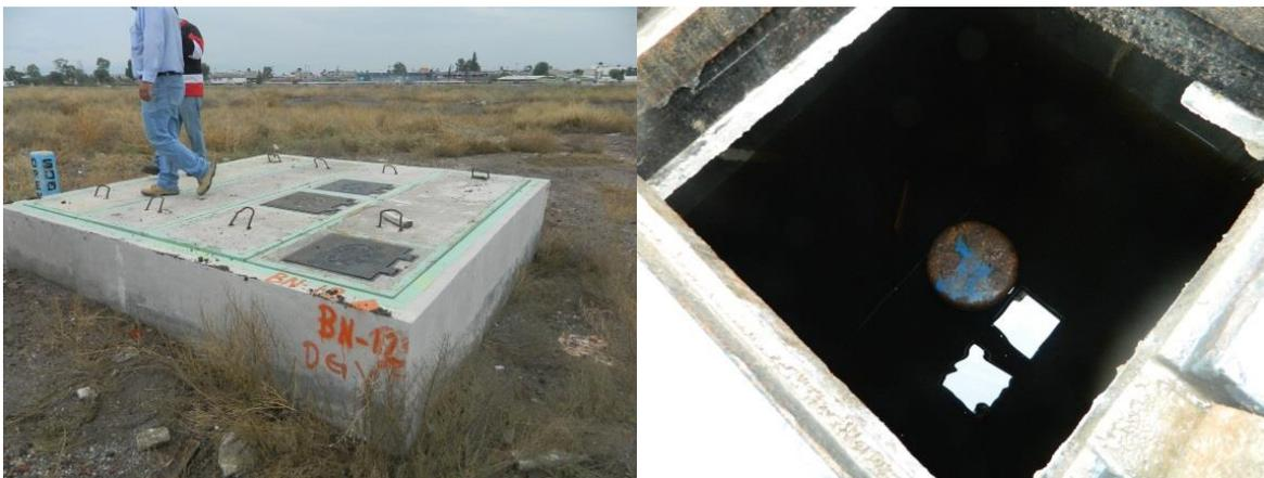
FIGURA A. 5 CAJA DE VÁLVULAS CON UNA VÁLVULA DE ADMISIÓN Y EXPULSIÓN DE AIRE INUNDADA CON UN TIRANTE DESDE EL FONDO DE LA CAJA DE 1.95 M. EL AGUA ES PRODUCTO DE LA EXPULSIÓN DE AGUA DE LA VÁLVULA Y DADO QUE NO TIENE COMO DRENARSE, SE HA INUNDADO
