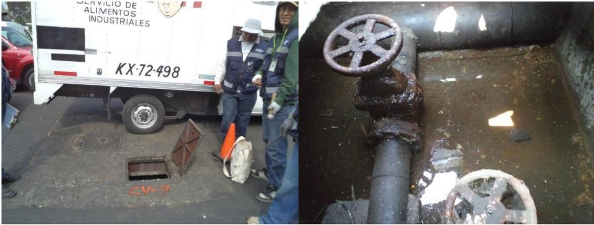
**FIGURA A. 8 LA CAJA DE VÁLVULAS CV-7 SE ENCUENTRA LLENA DE LÍQUIDOS EN ESTADO DESCOMPOSICIÓN**
