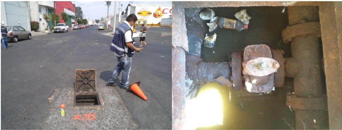
**FIGURA A. 12 LA CAJA DE VÁLVULAS A-35 SE ENCUENTRA INUNDADA CON UN TIRANTE DE 0.60 M**
