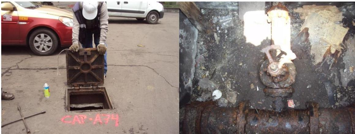
**FIGURA A. 7 LA CAJA DE VÁLVULAS CAP-A74 SE ENCUENTRA LLENA DE MATERIA ORGÁNICA EN ESTADO DESCOMPOSICIÓN**
