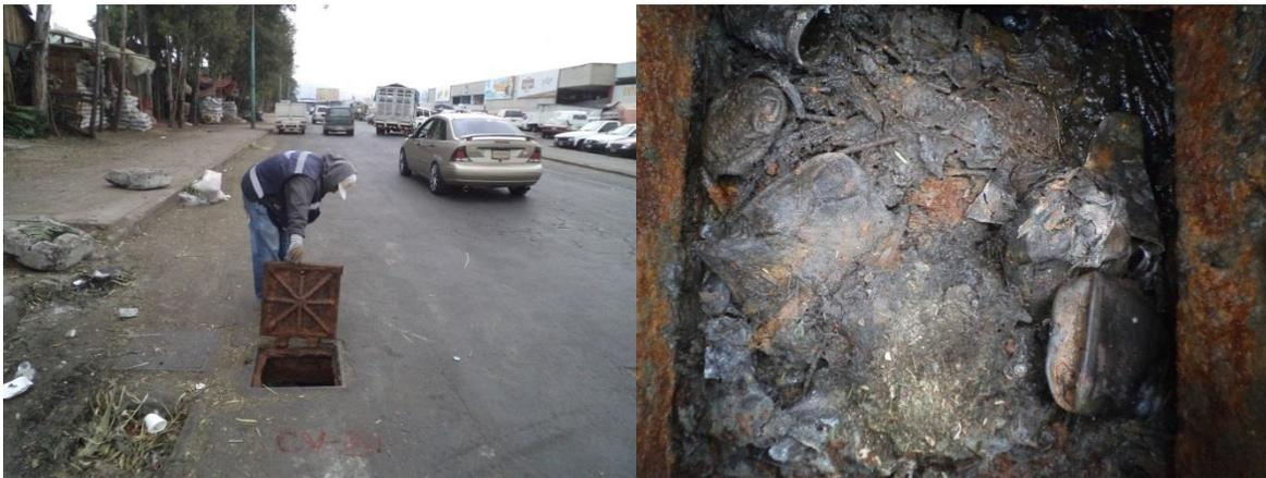
**FIGURA A. 16 LA CAJA DE VÁLVULAS CV-21 SE ENCUENTRA TOTALMENTE AZOLVADA Y CON DESECHOS HUMANOS**
