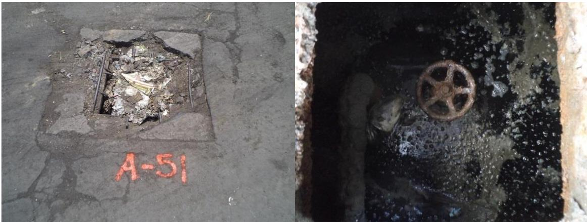
**FIGURA A. 13 LA CAJA DE VÁLVULAS A-51 SE ENCUENTRA INUNDADA CON UN TIRANTE DE 0.80 M**
