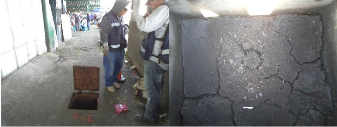
**FIGURA A. 11 LA CAJA DE VÁLVULAS A-12 SE ENCUENTRA AZOLVADA EN UNA MATRIZ DE SUELO CONTAMINADO**
