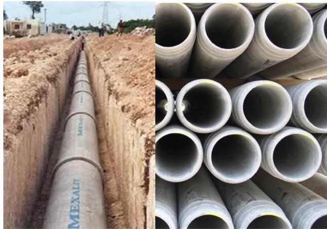
FIGURA 1. 5 TUBERÍA DE FIBROCEMENTO
