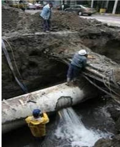
FIGURA 4. 5 RUPTURA EN LÍNEA DE CONDUCCIÓN DE AGUA POTABLE CON DESCARGA EN LA MATRIZ DEL SUELO.
