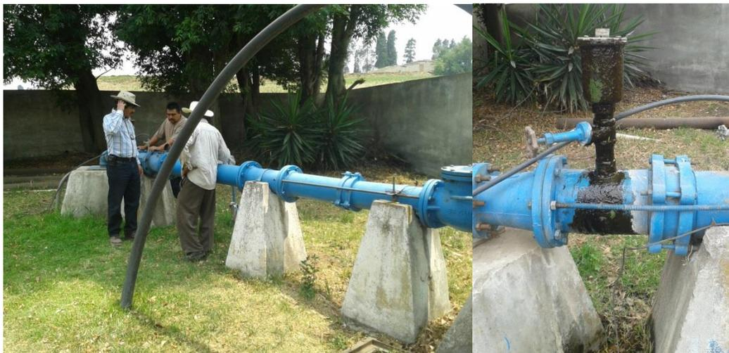
FIGURA A. 1 OBRA DE TOMA DE POZO DE BOMBEO CON VÁLVULA DE ADMISIÓN Y EXPULSIÓN DE AIRE CON FUGAS Y LLENA DE HONGOS
