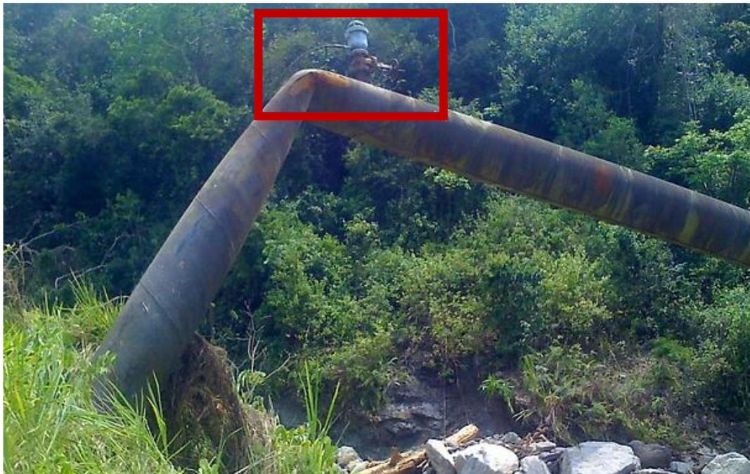
FIGURA 3. 2 FALLA DE TUBERÍA DE ACERO HELICOIDAL PRÓXIMA A LA UBICACIÓN DE UNA VÁLVULA DE EXPULSIÓN DE AIRE
