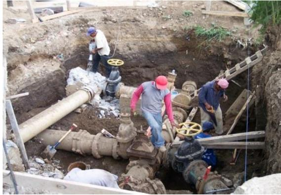
FIGURA 1. 15 CRUCERO DE TUBERÍA DE AGUA POTABLE
