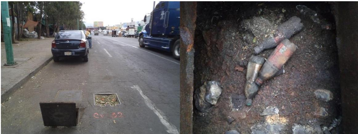
**FIGURA A. 15 LA CAJA DE VÁLVULAS CV-32 SE ENCUENTRA TOTALMENTE AZOLVADA Y CON DESECHOS HUMANOS**
