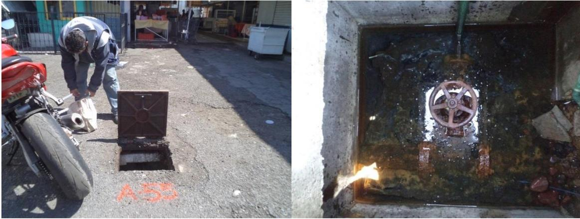
**FIGURA A. 17 LA CAJA DE VÁLVULAS A-53 SE ENCUENTRA INUNDADA CON GRASA CON UN TIRANTE DE 0.65 M**
