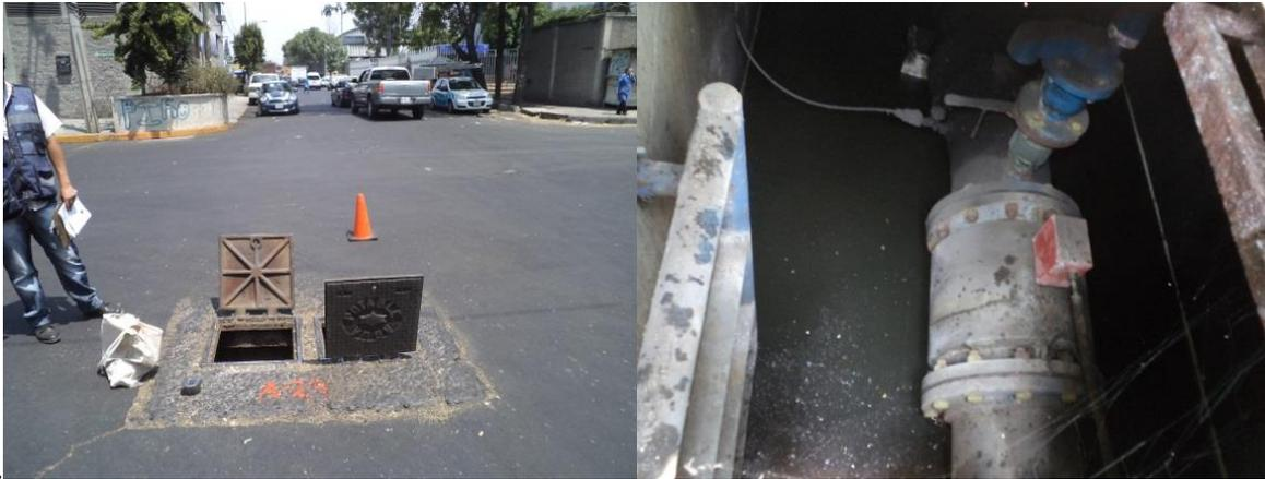
**FIGURA A. 9 LA CAJA DE VÁLVULAS A-27 SE ENCUENTRA INUNDADA CON UN TIRANTE DE 0.70 M, SE ENCUENTRA UNA VÁLVULA ANTIRETORNO DE SOLENOIDE Y UNA VÁLVULA DE ADMISIÓN Y EXPULSIÓN DE AIRE. LA CAJA REGULARMENTE SE SATURA Y DESBORDA**
