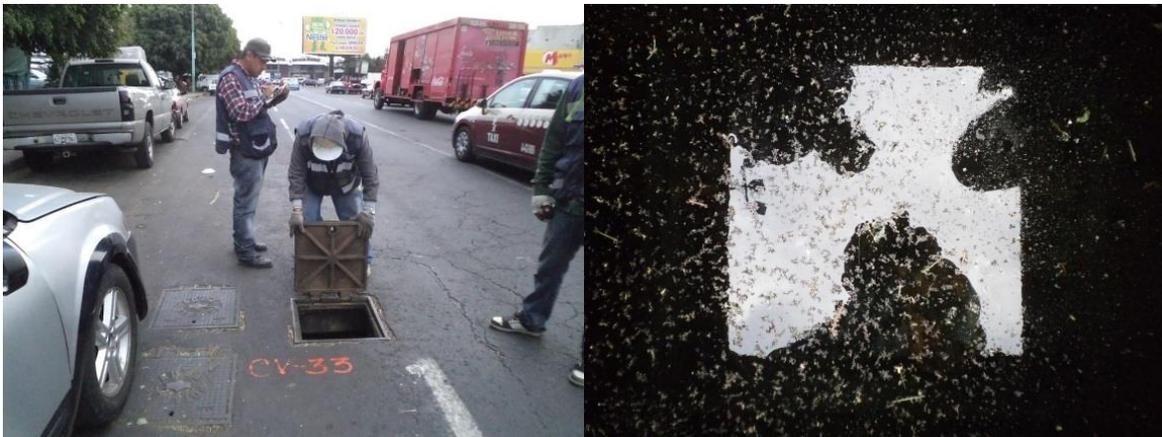
**FIGURA A. 10 LA CAJA DE VÁLVULAS CV-33 SE ENCUENTRA COMPLETAMENTE INUNDADA CON PROFUNDIDAD APROXIMADA DE 1.5 M**
