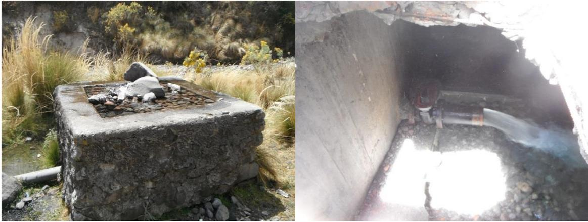
FIGURA A. 3 CAJA DE VÁLVULAS LLENA DE AGUA A TAL GRADO QUE LEVANTA LA TAPA; LA POBLACIÓN COLOCA PIEDRAS ENCIMA DE LA TAPA PARA EVITAR QUE SE DESPLACE. LLEGADA DE LA LÍNEA DE CONDUCCIÓN AL TANQUE DE ALMACENAMIENTO
