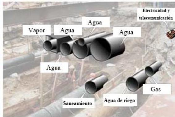
FIGURA 4. 3 DISPOSICIÓN COMÚN DE TUBERÍAS EN UNA ZONA URBANA
