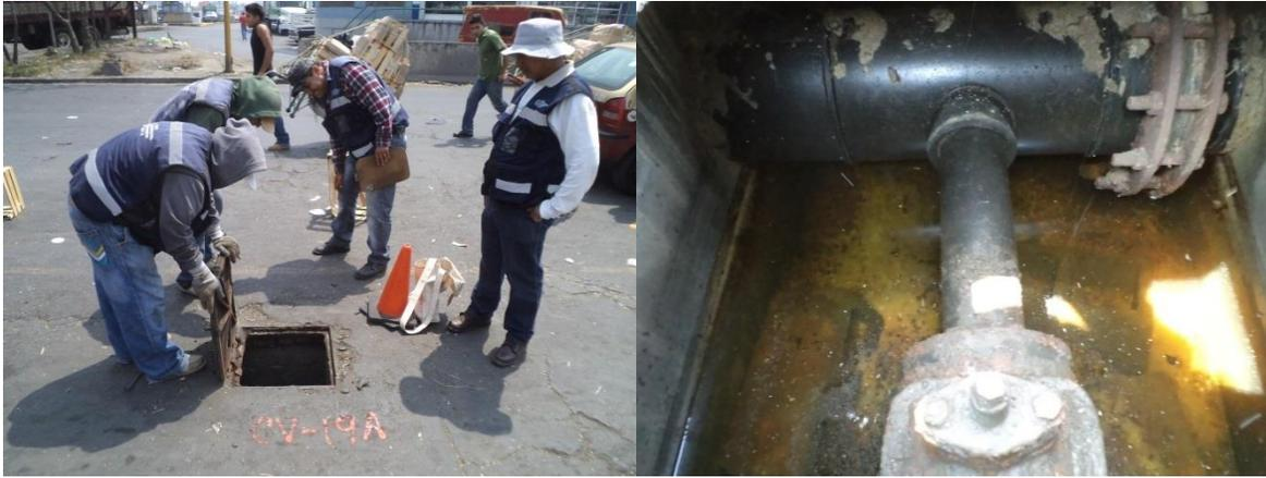
**FIGURA A. 14 LA CAJA DE VÁLVULAS CV-19A SE ENCUENTRA INUNDADA CON GRASA CON UN TIRANTE DE 0.25 M**
