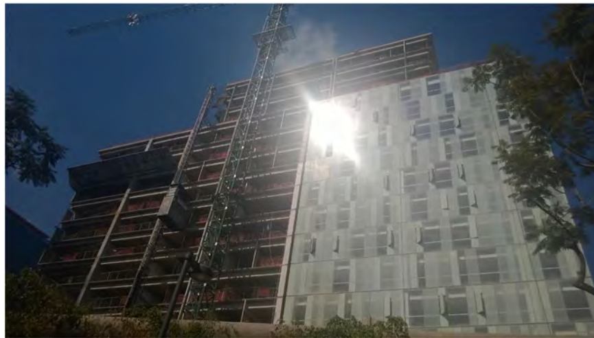
Figura 2.3 -Estado actual del edificio
