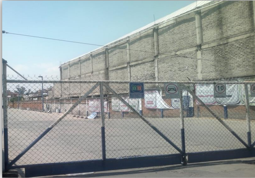
FOTOGRAFÍA 4. COLINDANCIA ORIENTE NAVE TRIPLE ALTURA Y ESTRUCTURAS DE UN NIVEL.
