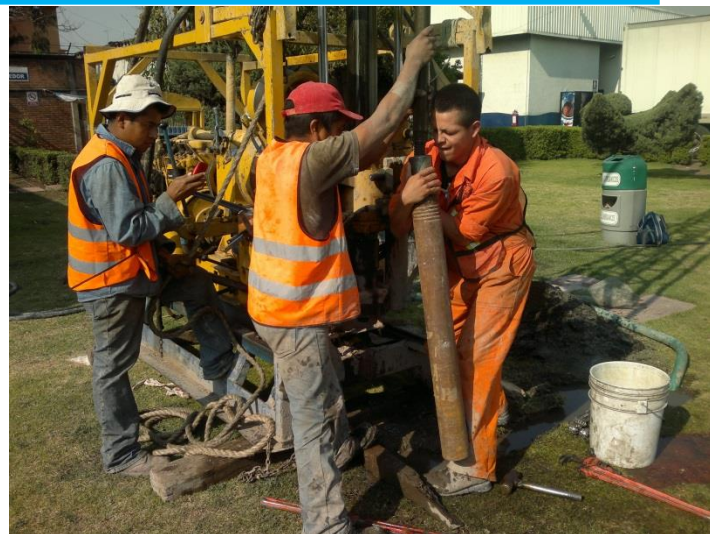
COLOCACIÓN DEL TUBO DE PARED DELGADA (TUBO SHELBY)
