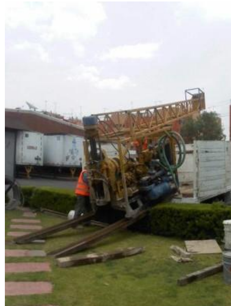
COLOCACIÓN DE LA MAQUINA LONG YEAR 34
