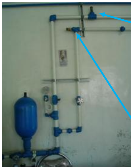
Válvulas de relevo hidrostático
