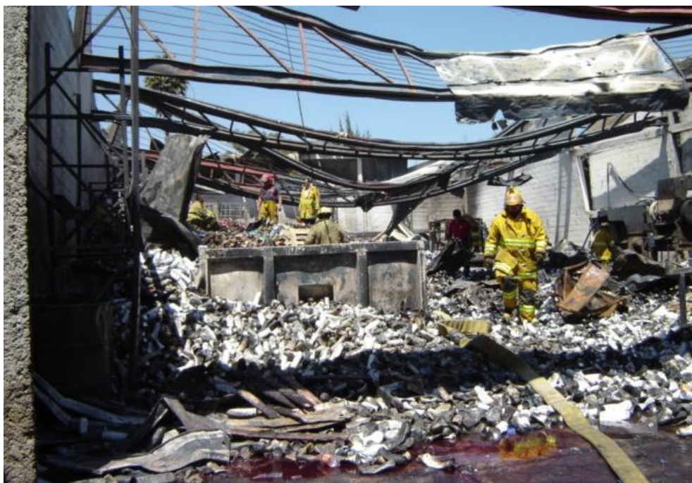
Incendio de una Planta destructora de aerosoles defectuosos.
