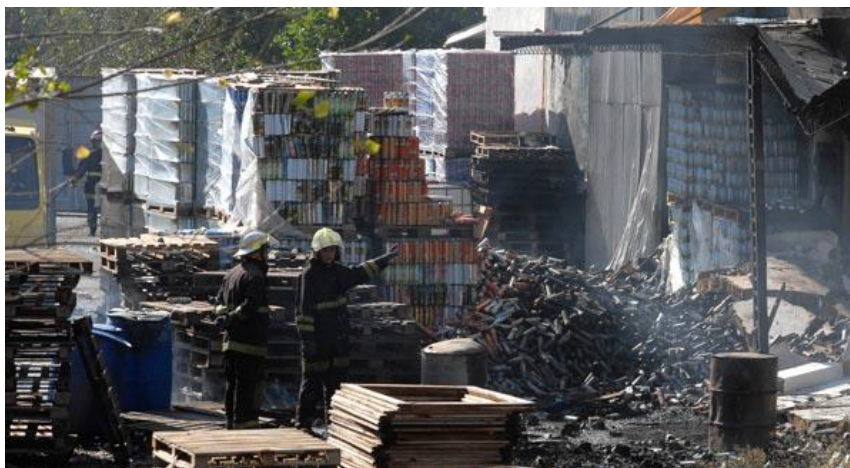
Incendio de una bodega con instalaciones eléctricas no clasificadas.
