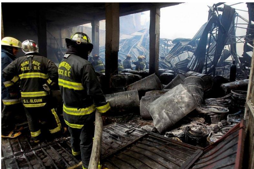
Destrucción de una Planta Llenadora de aerosoles por incendio de solventes.
