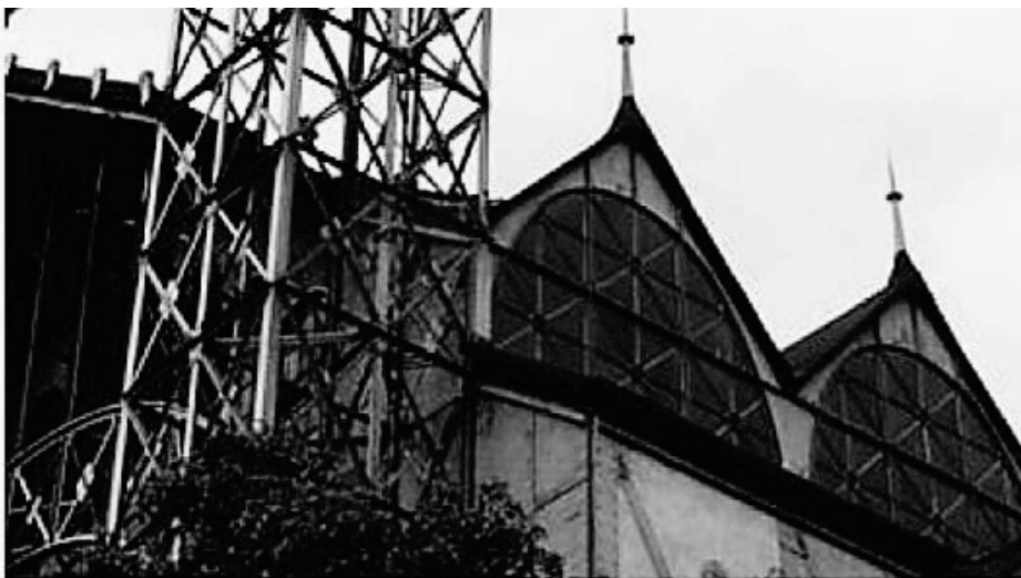
Figura 2.- Detalle armadura de hierro Museo del Chopo (1909-1910). Foto: G. Boils, 2006.
