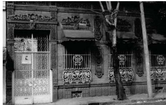
Figura No. 7.- Casa con buen estado de conservación. Foto: A. Contreras, 2005.
