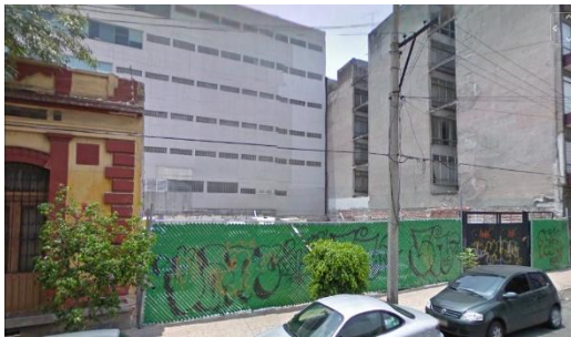
3. Fotografía tomada desde la Calle de Ciencias.
