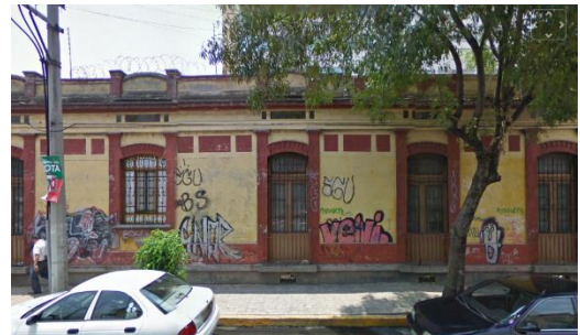
4. Fotografía tomada desde la Calle de Ciencias.
