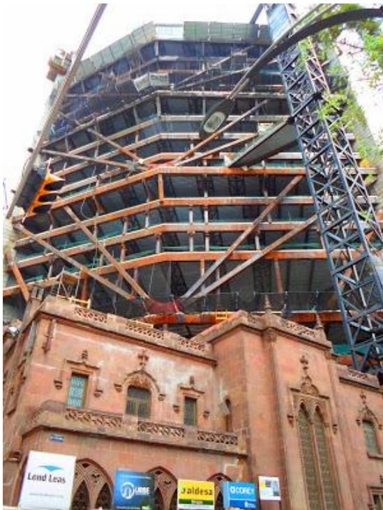
Fotografía de la construcción.
