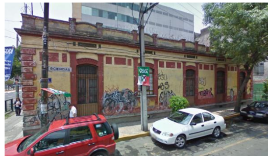
2. Fotografía tomada desde la Calle de Ciencias.
