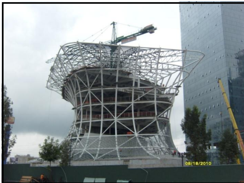
Foto 4.1.- Estructura de acero del Museo Soumaya, Ciudad de Mexico
