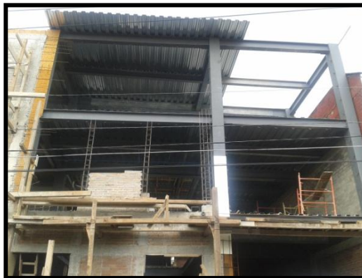
Foto 6.1.- Fachada de la edificación.
