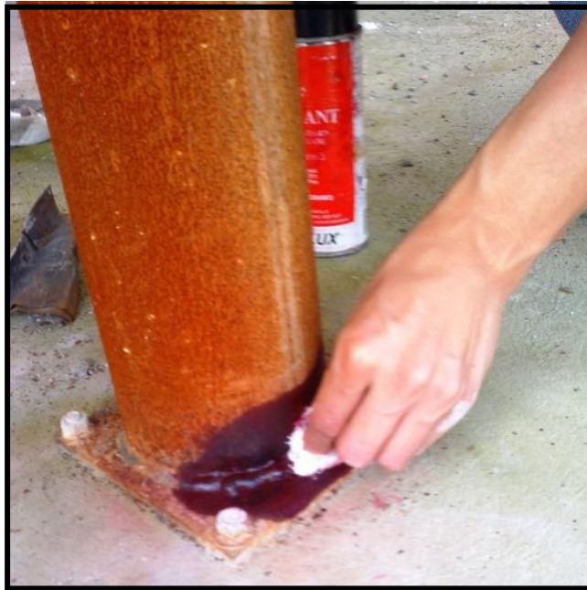
Foto 6.10.- Remoción del exceso de penetrante antes de la aplicación del Revelador.
