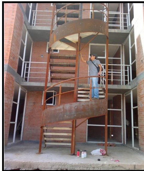
Foto 6.6.- Estructura elegida para realizar la prueba de Líquidos Penetrantes.
