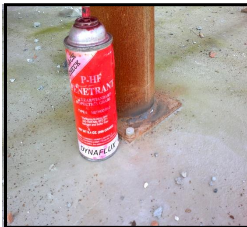
Foto 6.8.- Zona limpiada para aplicar el Penetrante.
