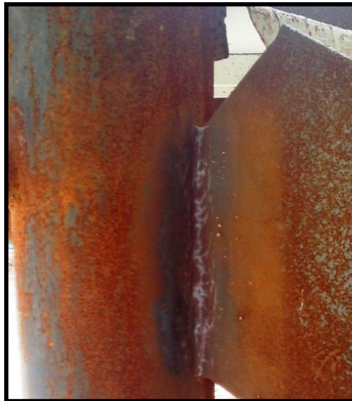
Foto 6.12.- Área de inspección previamente lijada para remover el óxido y limpiada con el Cleaner (Limpiador, primer paso de la prueba).
