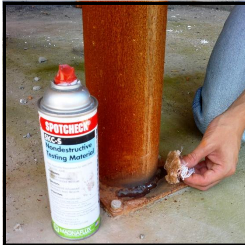
Foto 6.8.- Limpieza de la zona a la que se realizará el ensayo.
