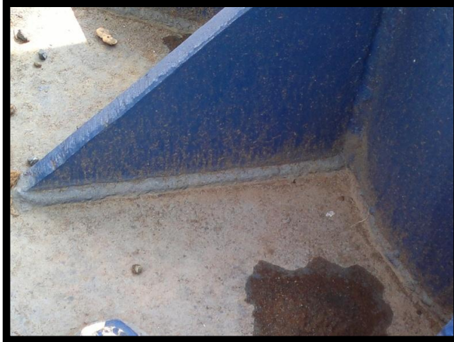
Foto 4.2.- Unión de placa base a cartabones y columna mediante soldadura de filete.
