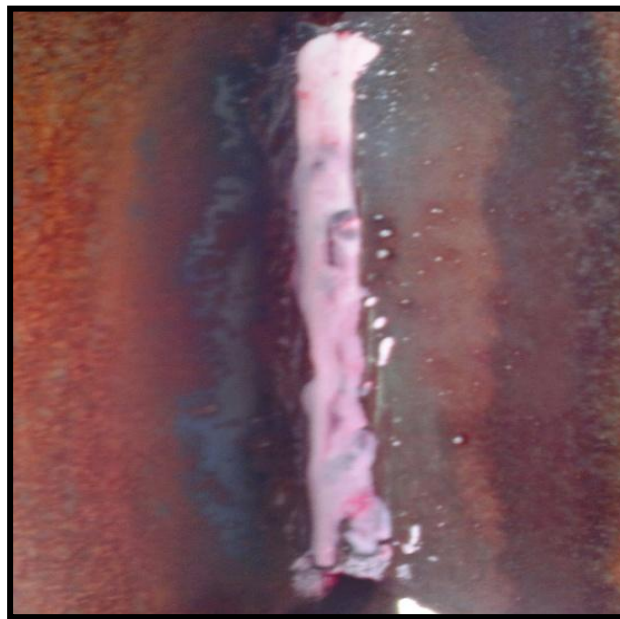
Foto 6.14.- Revelador actuando en el cordón de soldadura.
