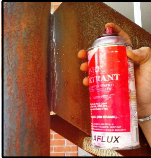
Foto 6.12.- Ya que se transcurrió el tiempo marcado después de la aplicación del Limpiador se rociará el área con el Penetrante (segundo paso de la prueba).
