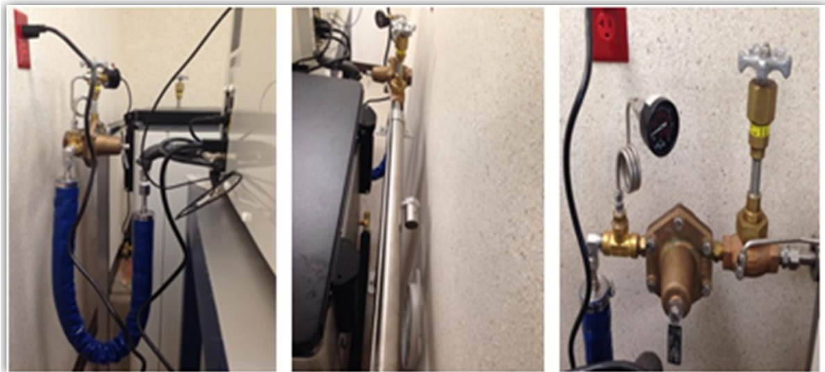
Fig. 12. Instalación para distribución de N_2L
