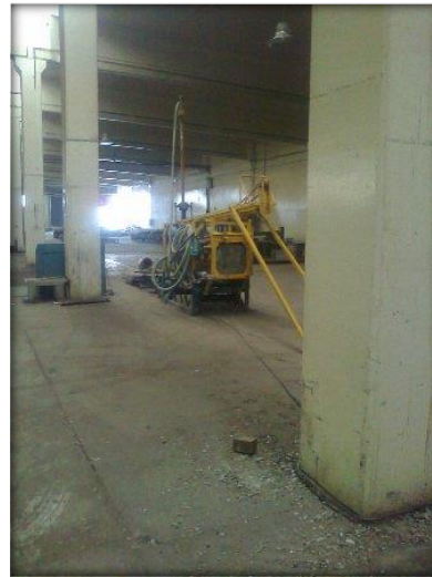
SONDEO DE PENETRACIÓN ESTANDAR SPT-7.
