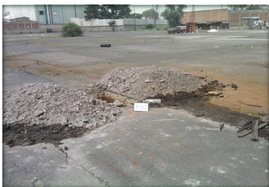
VISTA DE LA EXCAVACION REALIZADA PCA No.2
