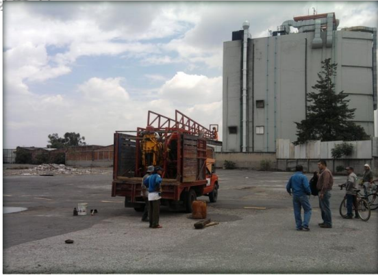
LLEGADA Y POSICIONAMIENTO DE LA MAQUINA LONG YEAR 34 PREVIO A LOS TRABAJOS DE PERFORACIÓN DENOMINADO SONDEO MIXTO SM-2.
