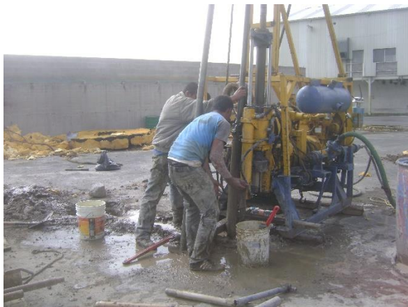
EJECUCION DE SONDEO PROFUNDO Y OBTENCION DE MUESTRAS.
