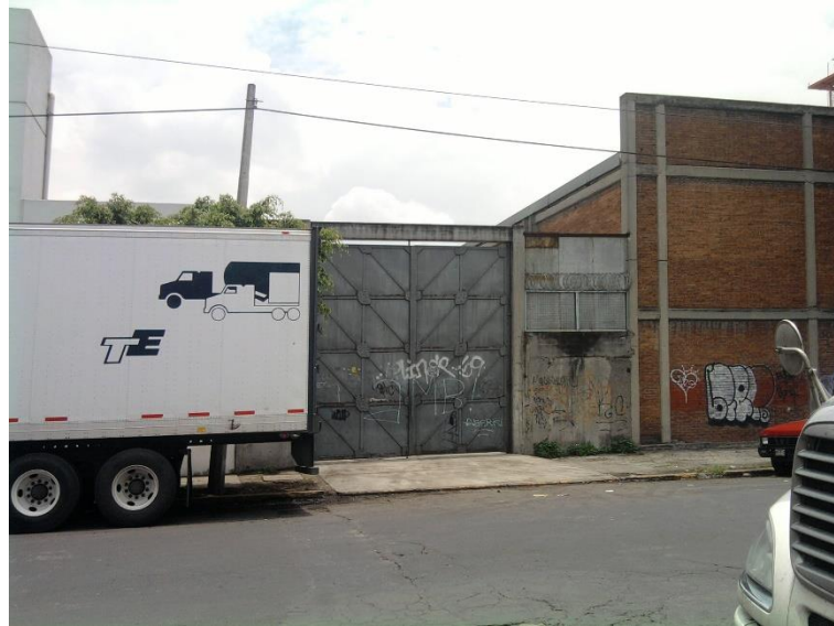
FOTOGRAFIA COLINDANCIA PONIENTE (AVENIDA NORTE 35)
