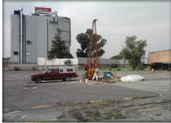
LLEGADA Y POSICIONAMIENTO DE LA MAQUINA LONG YEAR 34 PREVIO A LOS TRABAJOS DE PERFORACIÓN DENOMINADO SONDEO MIXTO SM-2.
