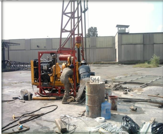
EJECUCIÓN DEL SONDEO MIXTO SM-4.
