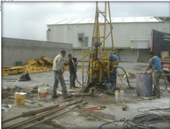
EJECUCIÓN DEL SONDEO MIXTO SM-1.
