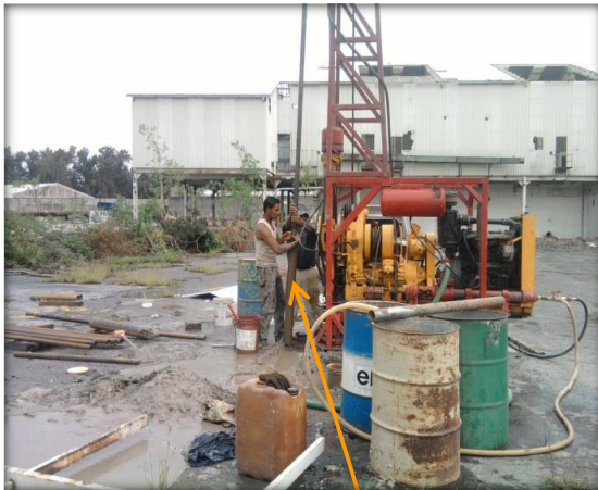
MUESTREADOR DE PARED DELGADA (TUBO SHELBY).
