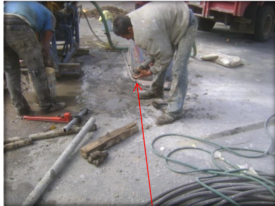
BROCA TRICONICA EMPLEADA PARA EL AVANCE DE PERFORACIÓN
