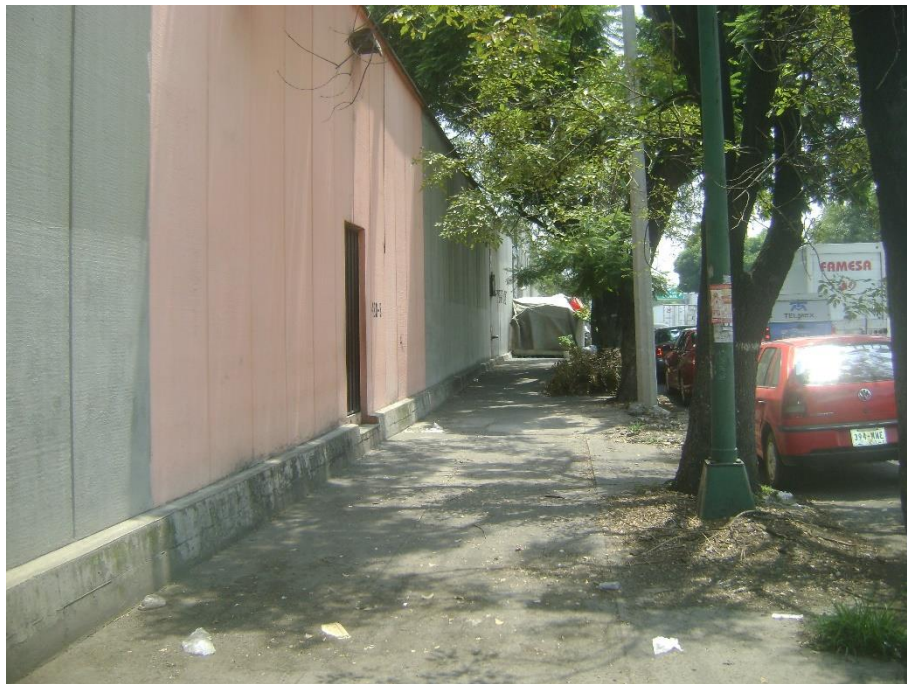
FOTOGRAFIA 2.- ACCESO AL PREDIO DE INTERES POR CALLE PONIENTE 122
