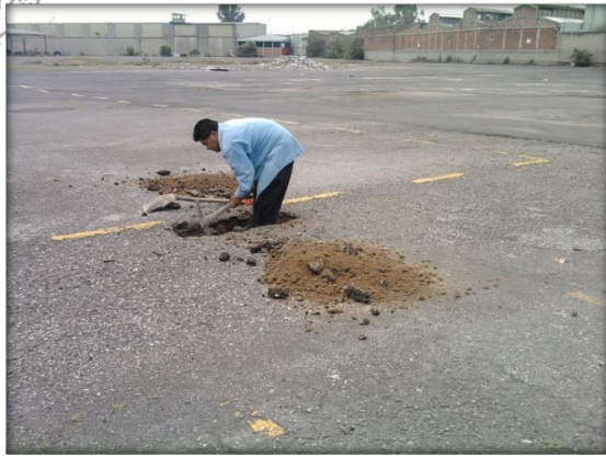
INICIO DE LA EXCAVACIÓN DEL POZO A CIELO ABIERTO No.1
