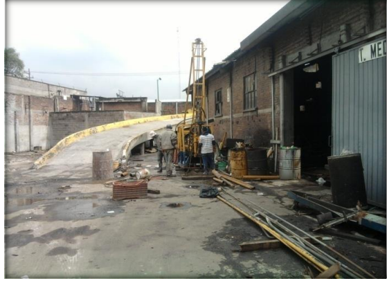
EJECUCIÓN DEL SONDEO MIXTO SM-3.
