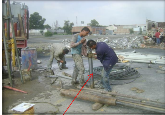
MUESTREADOR DE PARED DELGADA (TUBO SHELBY). SONDEO MIXTO SM-1.
