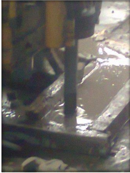
BROCA TRICONICA EMPLEADA PARA EL AVANCE DE PERFORACIÓN PREVIO AL HINCADO DEL TUBO PARTIDO.
