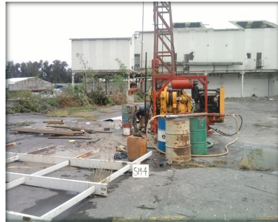
EJECUCIÓN DEL SONDEO MIXTO SM-4.
