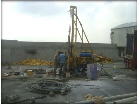
EJECUCIÓN DEL SONDEO MIXTO SM-1.
