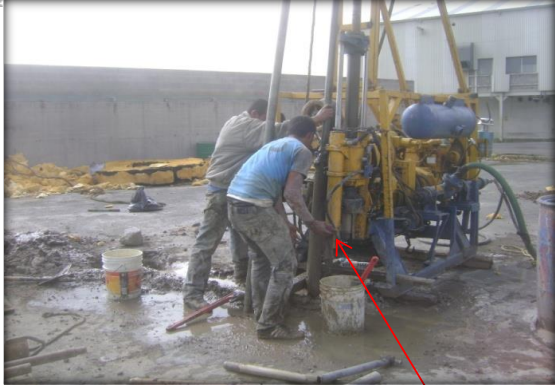
MUESTREADOR DE PARED DELGADA (TUBO SHELBY). SONDEO MIXTO SM-1.
