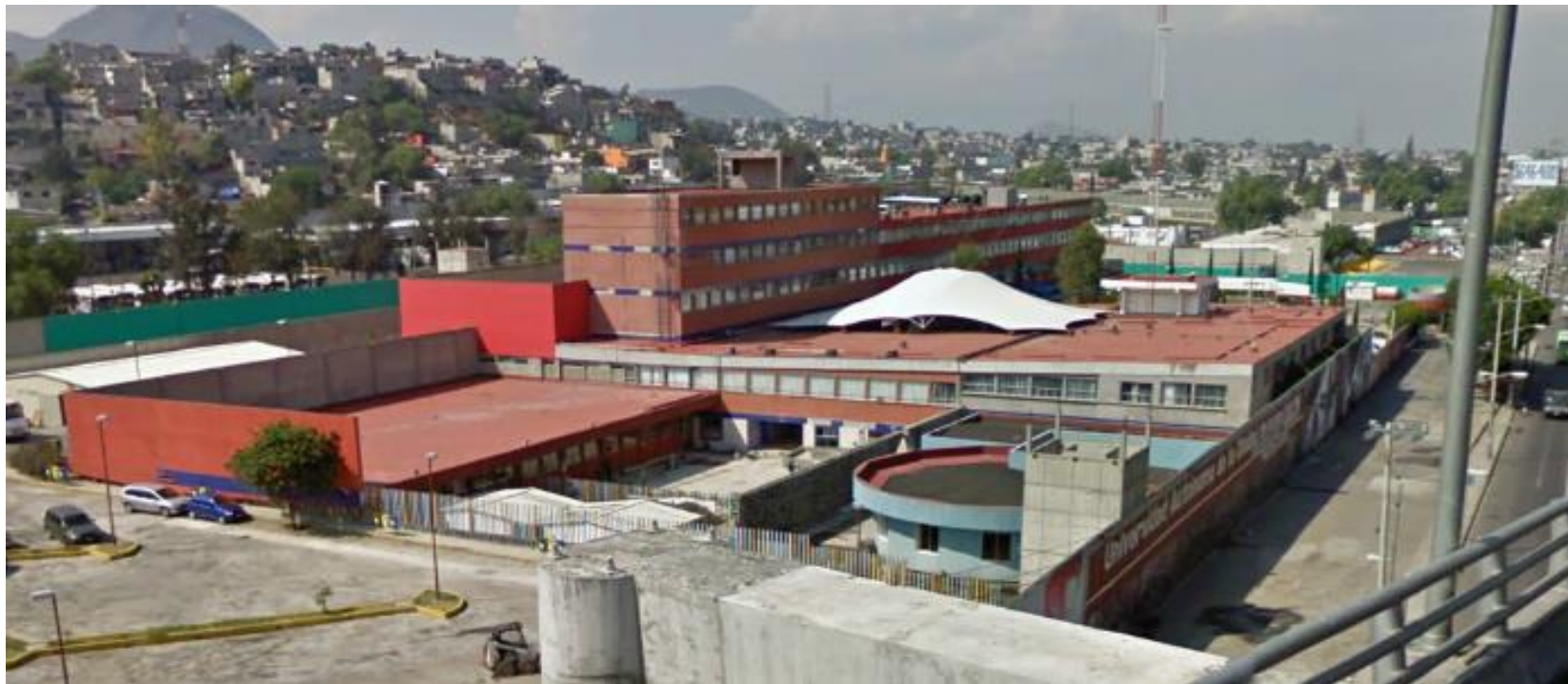
INSTALACIONES UACM PLANTEL CASA LIBERTAD
