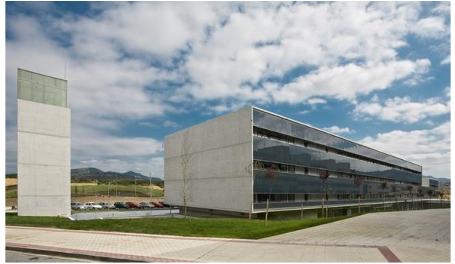
Vista exterior, Edificio de oficinas en Tracasa
