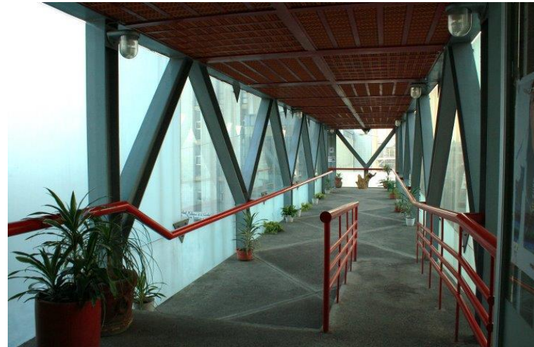
Vista del interior del puente
