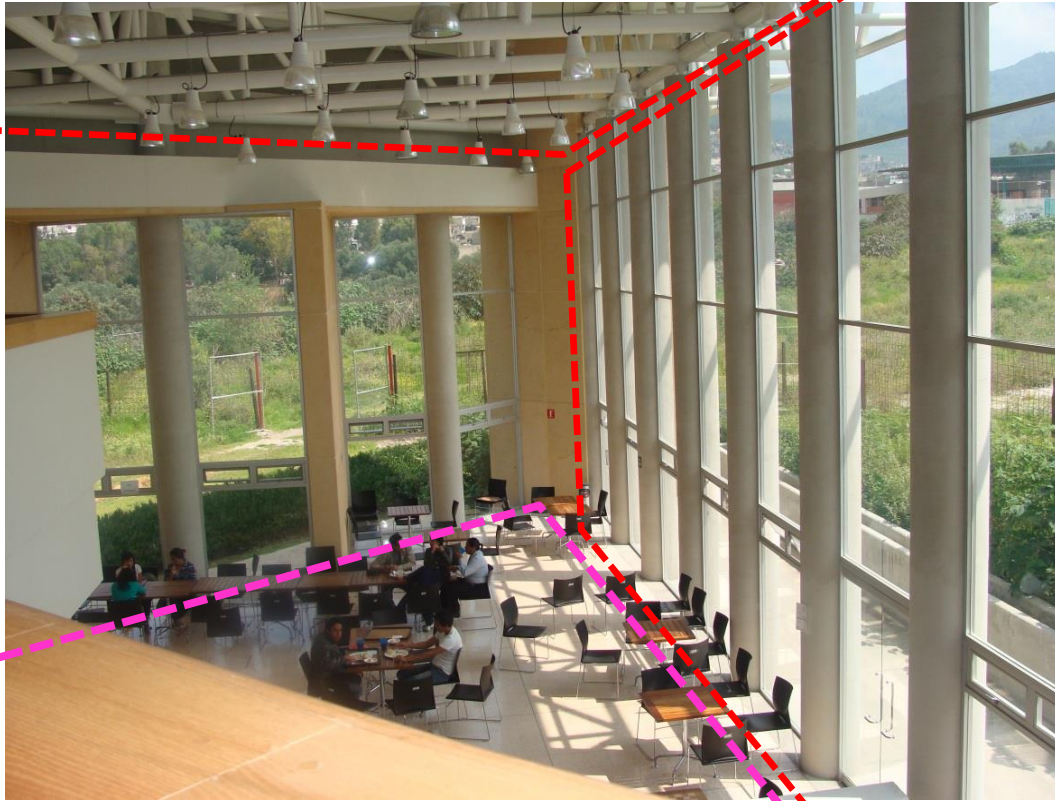
Columnas circulares y cancelería de aluminio natural con cristal transparente de 6 milímetros.
