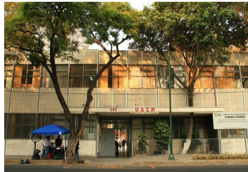
Fachada UACM PLANTEL DEL VALLE
