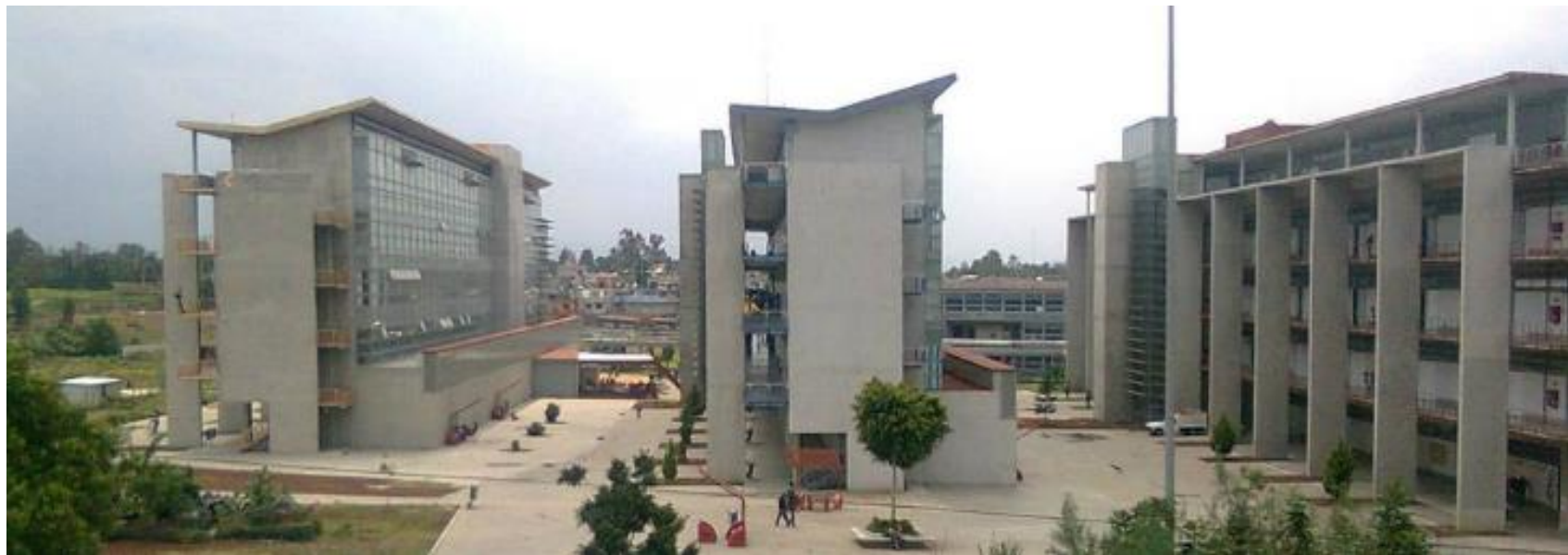
INSTALACIONES UACM PLANTEL SAN LORENZO TEZONCO
