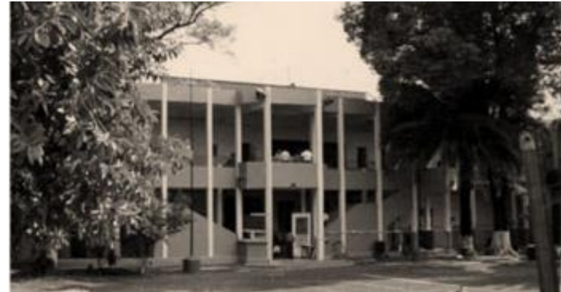
Instalaciones UACM PLANTEL DEL VALLE
