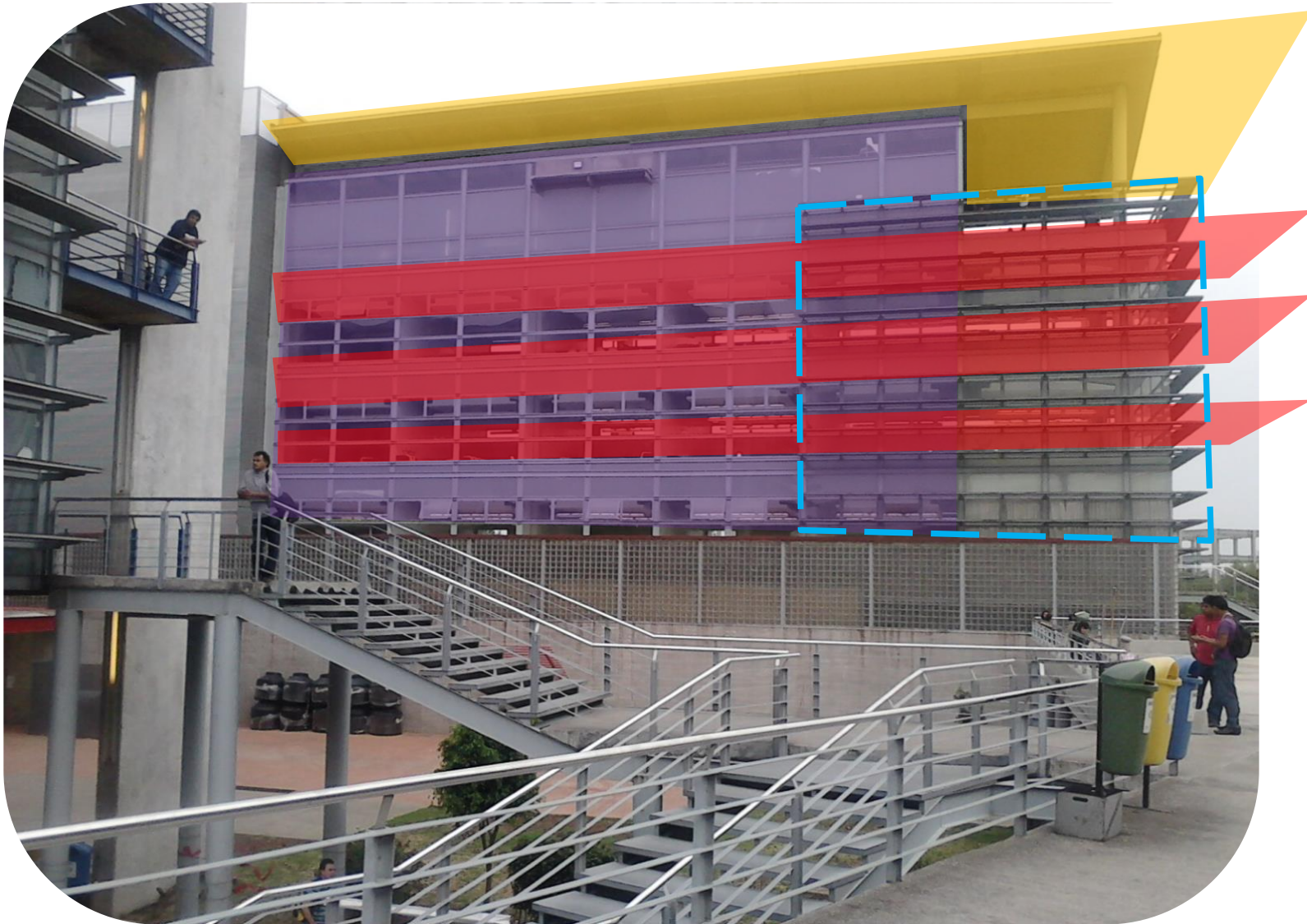
Entrepiso de losacero Muro cortina Cubierta de losa maciza Parasoles de aluminio
