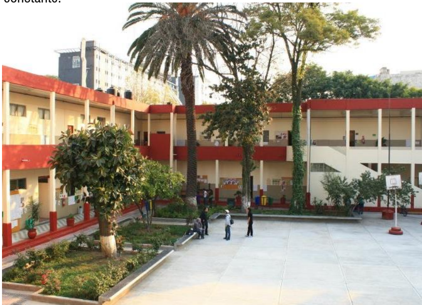
Instalaciones UACM PLANTEL DEL VALLE
