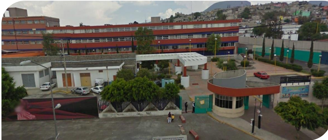
Vista general, UACM PLANTEL CASA LIBERTAD.
