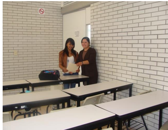
Muros divisorios de ladrillo vidriado cara blanca
