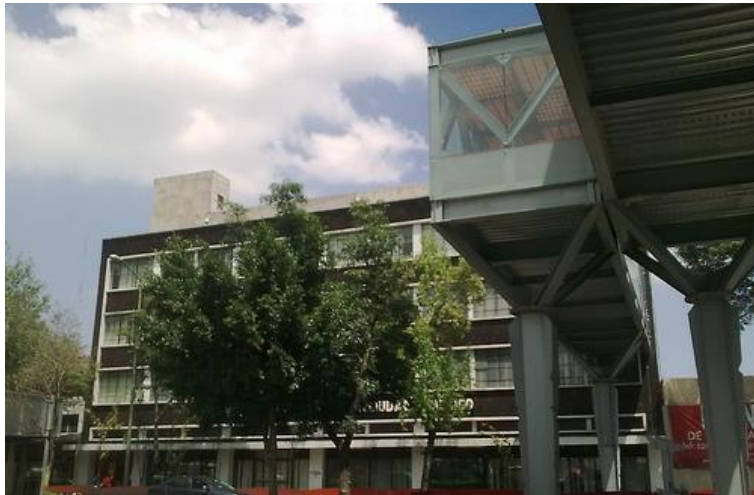
Vista del exterior del puente
