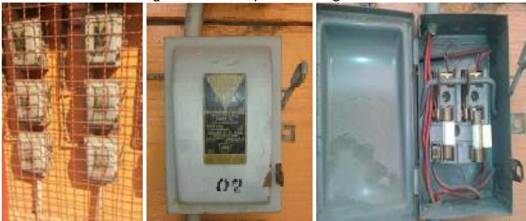
En el caso de este edificio todos los departamentos tienen centros de carga los cuales son generalmente empleados para conectar circuitos independientes de alumbrado y/o contactos y para la protección y desconexión de pequeñas cargas eléctricas y alumbrado. Estos centros de carga son generalmente usados en uso residencial.
