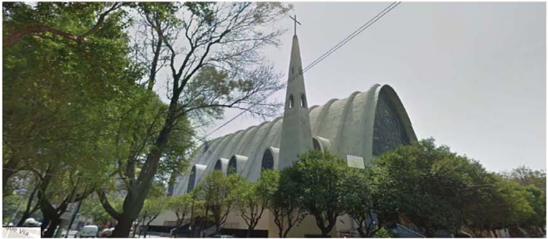
2. VISTA DE IGLESIA SOBRE RIO GRIJALVA
