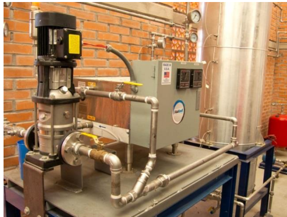
Figura 2.12 Componentes del Calentador auxiliar
