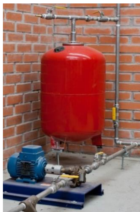
Figura 2.7. Instalación del Tanque de expansión
