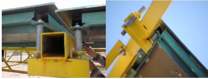
Figura 3.18: Sujeción y orientación de la faceta respecto el marco estructural.
