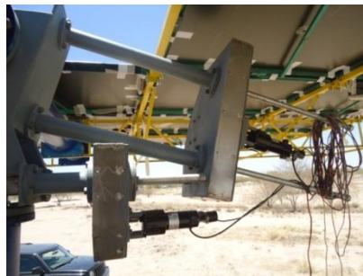
Figura 6.6: Vista lateral del cabezal instalado.
