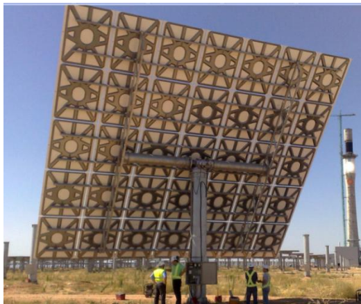
Figura 2.3: Prototipo de helióstato instalado en Gemasolar (Lata, 2010).
