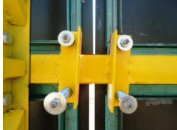
Figura 6.1: Descuadre de elementos.
