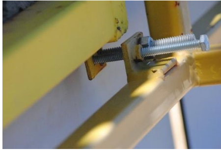
Figura 2.26: Elementos de sujeción y de canteo de facetas del heliostato UNAM-36-A.
