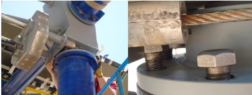
Figura 6.7: Instalación del cabezal sobre el pedestal (izquierda) y acoplamiento de bridas (derecha).
