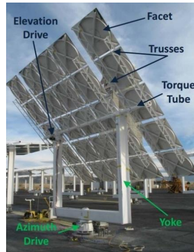
Figura 2.4: Helióstato instalado en NSTTF .
