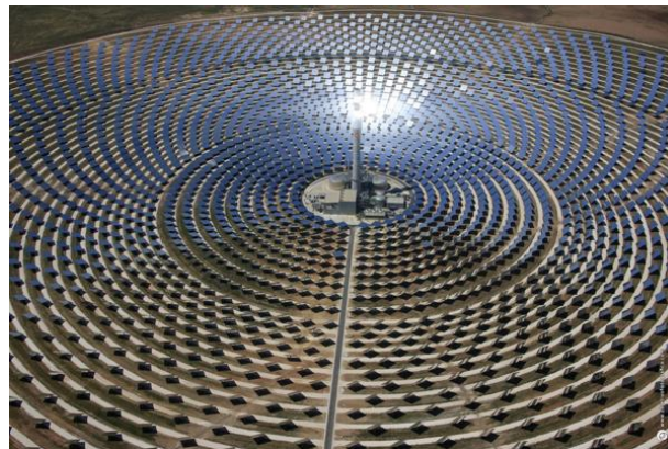
Figura 1.17: Planta Gemasolar de la empresa Torresol Energy, Sevilla.
