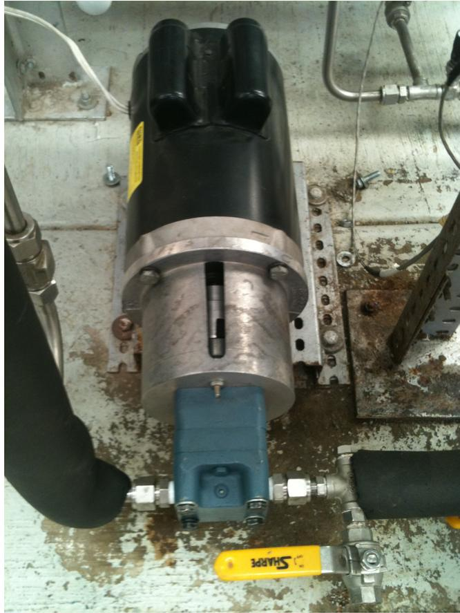
Figura 3.3: Motor y bomba acoplados.
