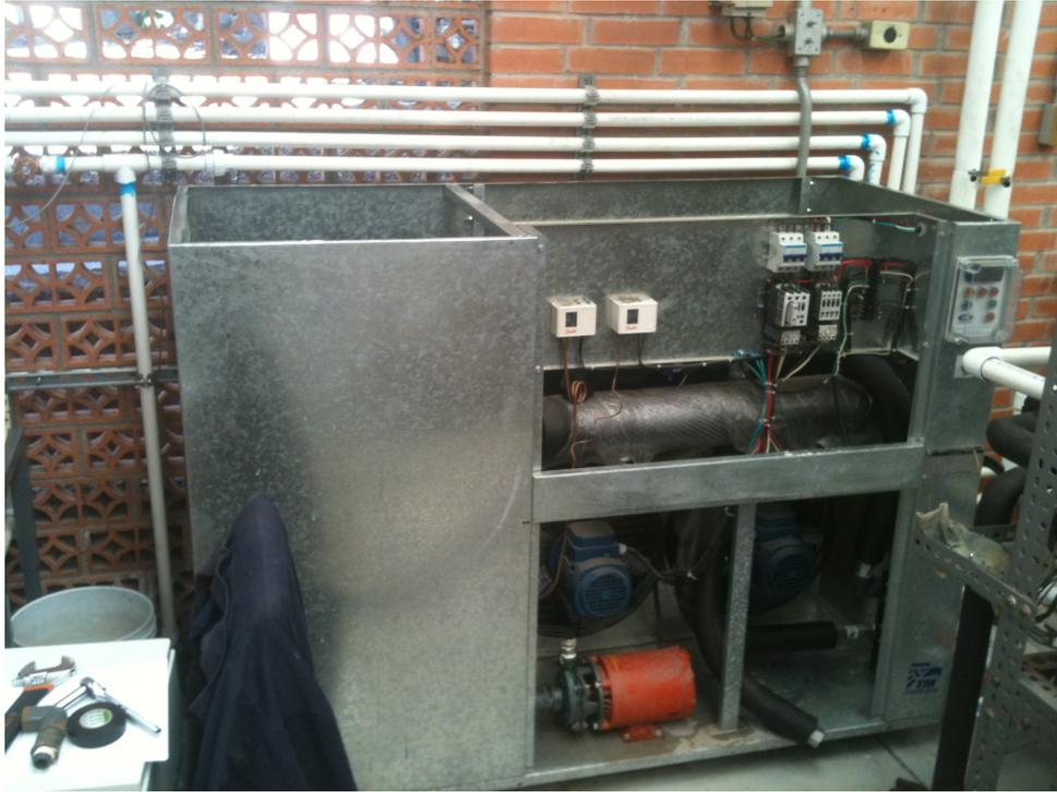
Figura 3.9: Chiller en proceso de modificación.
