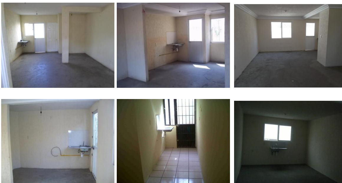
FIGURA 14. Espacios interiores de viviendas en Villas del Pedregal
