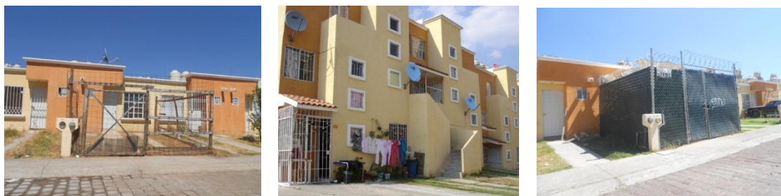
FIGURA 25. Protecciones en viviendas
