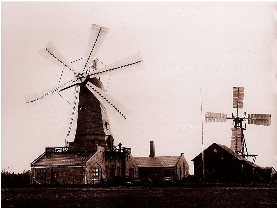
Figura 3.6 Dos de los aerogeneradores de prueba construidos por Lacour en 1897, Instituto de Askov Folk en Askov, Dinamarca.
