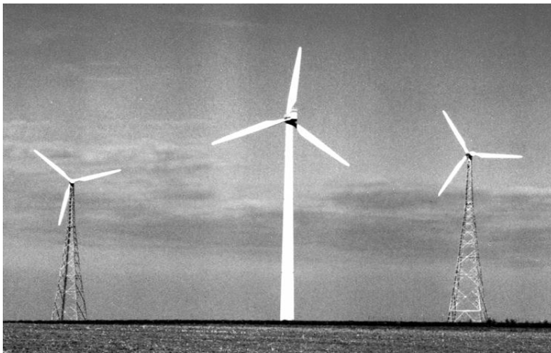
Figura 3.21 Aerogeneradores con torres de celosía (a los extremos) y con torre de acero tubular (al centro).
