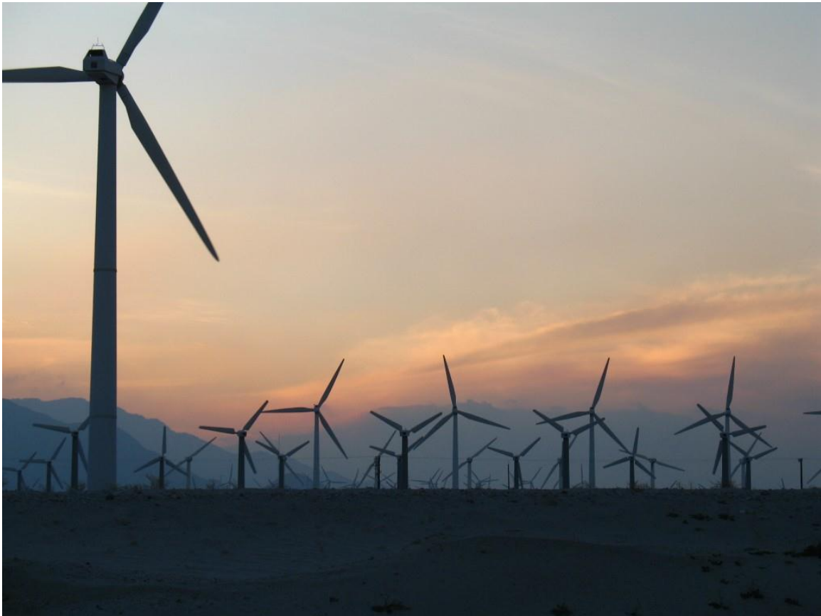
Figura 1.19 El uso del viento como un recurso para la generación de electricidad. En la imagen, el parque eólico Eurus, con ciento sesenta y siete aerogeneradores para una capacidad instalada de 250 MW, ubicado en Juchitán, Oaxaca, en el Istmo de Tehuantepec, México.
