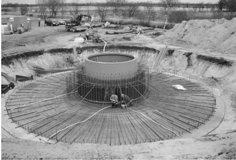
Figura 3.20 Cimentación para una torre tubular de acero.
