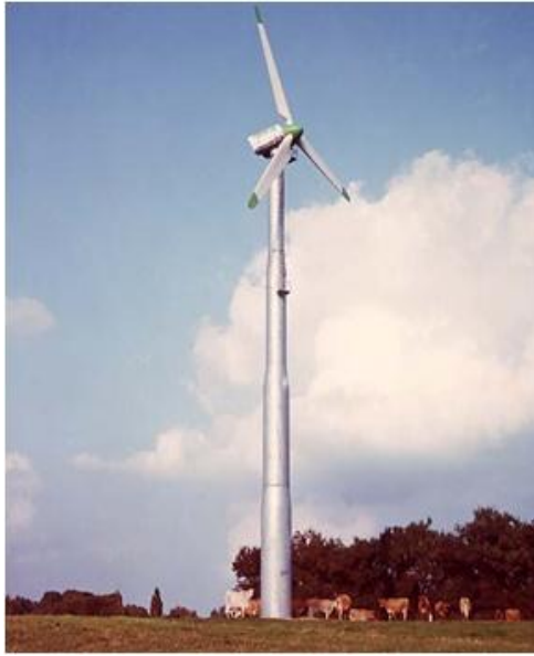
Figura 3.10 Aerogenerador Bonus 30 KW.
