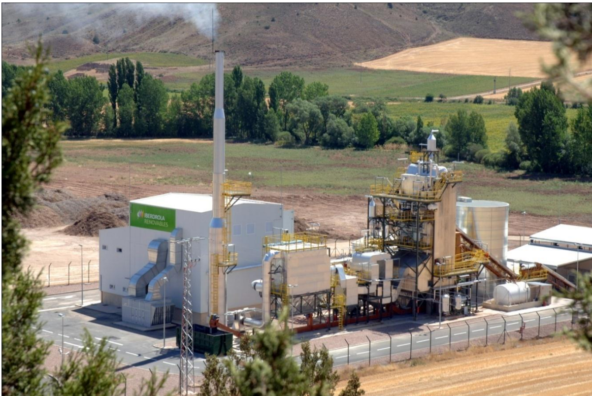
Figura 1.16 Central de biomasa forestal Lakeview, ubicada en Oregón, Estados Unidos de América, construida por Iberdrola Renovables. Posee una potencia de 26.8 MW (Mega watts).
