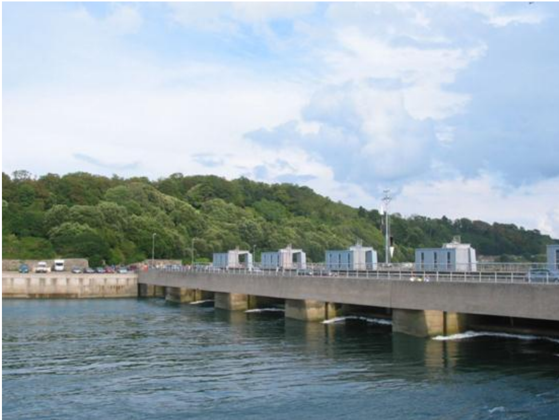
Figura 1.12 Central eléctrica mareomotriz en el estuario del río Rance, Dinan, al noroeste de Francia. Funciona con un ciclo de doble efecto con acumulación por bombeo, posee veinticuatro turbinas de 10MW. Su producción anual de energía es de 550 GW/h (giga watts por hora).
