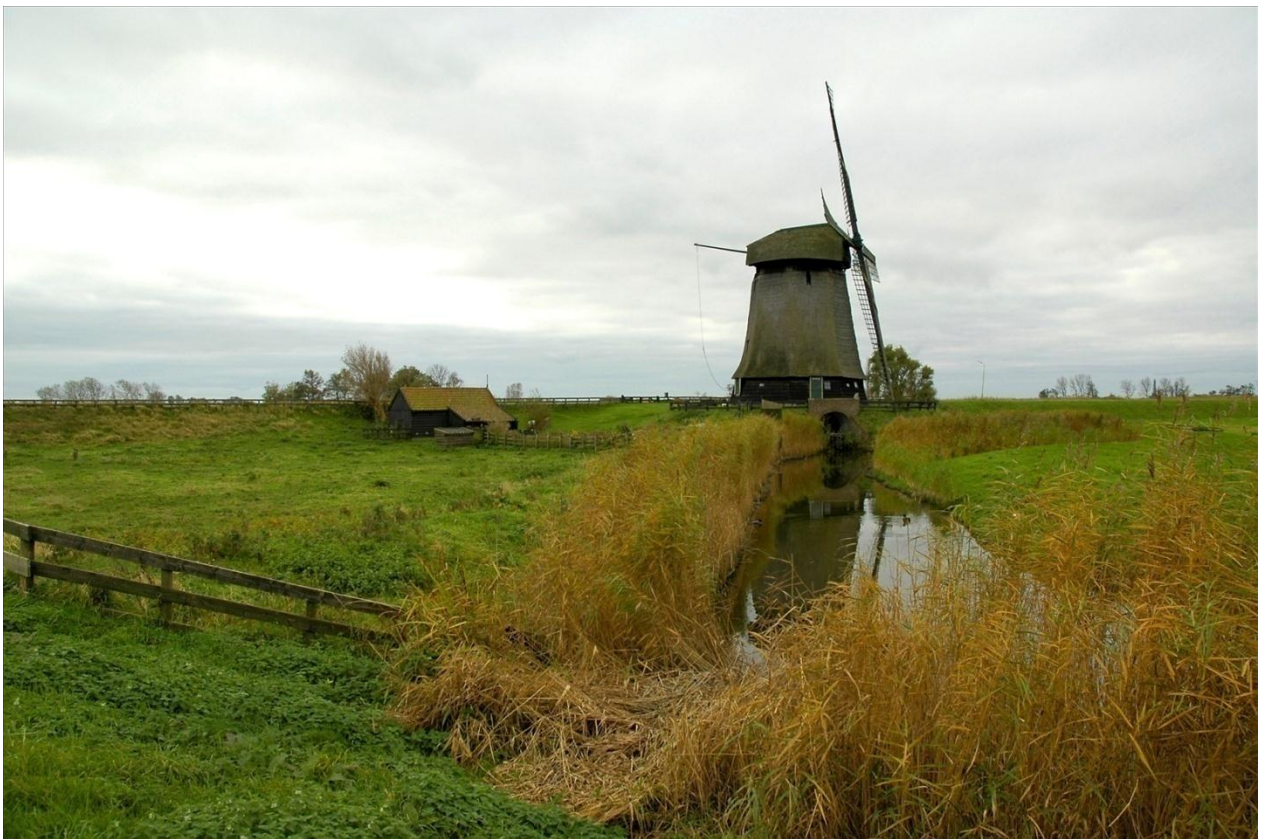
Figura 3.3 La zona del polder de Beemster, se encontraba a 3 m por debajo del nivel del mar, sin embargo fue drenado en el periodo comprendido entre 1608 y 1612, mediante veintiséis molinos, cada uno con una potencia aproximada de 50 HP (caballos de fuerza).
