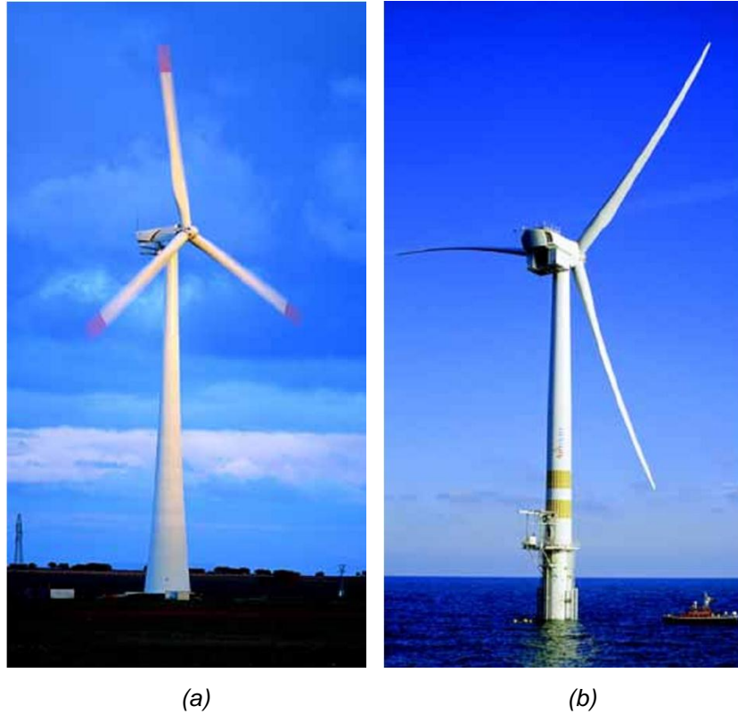
Figura 3.11 El aerogenerador General Electric posee una capacidad de 3.6 MW y un rotor de 106 m de diámetro. (a) Instalación en tierra. (b) instalación en mar.
