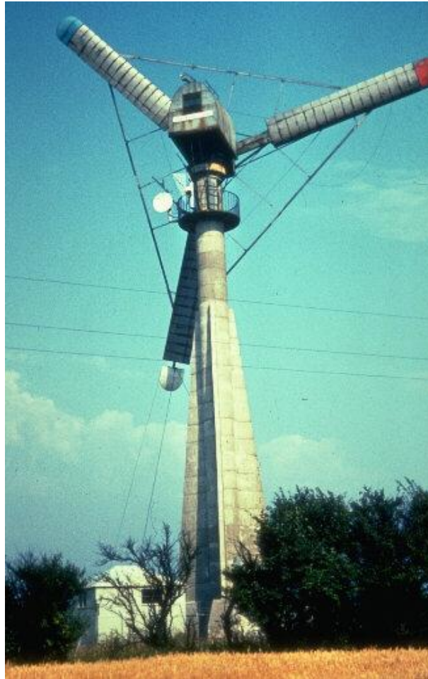
Figura 3.8 Aerogenerador diseñado por Johanes Juul, instalado en Gedser.
