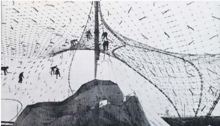
Construcción de membranas por cables tensados. Frei Otto. detail-online.com
