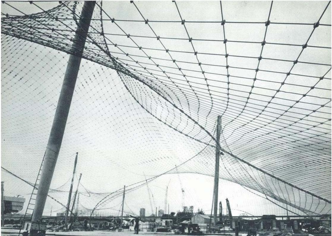
Construcción de membranas por cables tensados Pabellón alemán para la Expo de Montreal (1967). Frei Otto. detail-online.com
