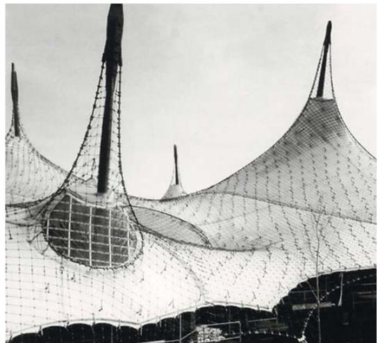
Construcción de membranas por cables tensados. Frei Otto. detail-online.com
