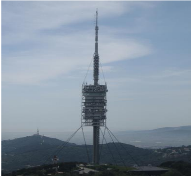
Figura 2.3e Torre de comunicaciones de Collserola, Barcelona
