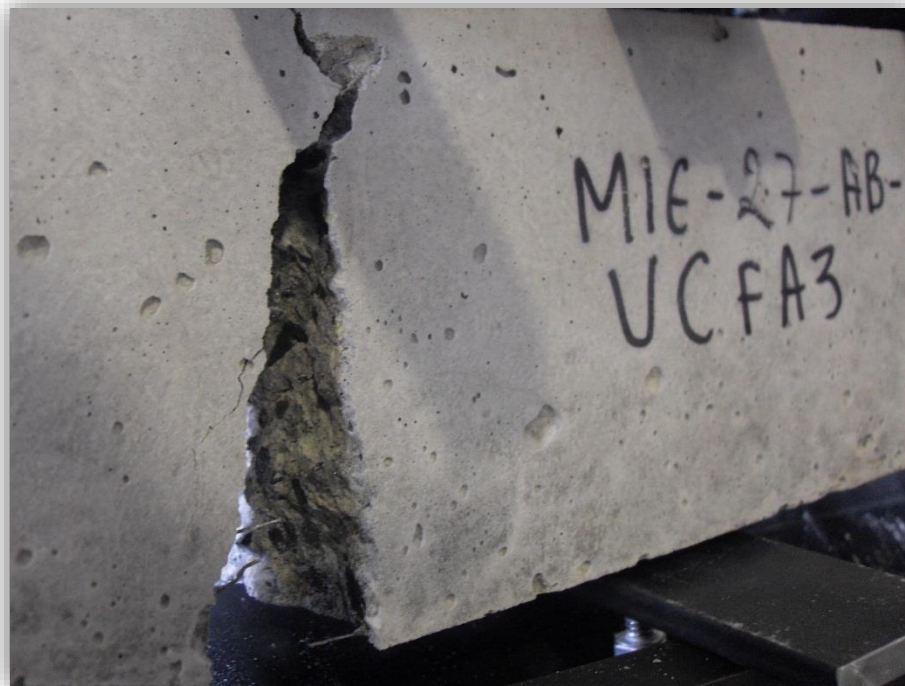
Figura 6.3.3.3b Falla del elemento después de la aplicación de la carga máxima de la viga VFA3
