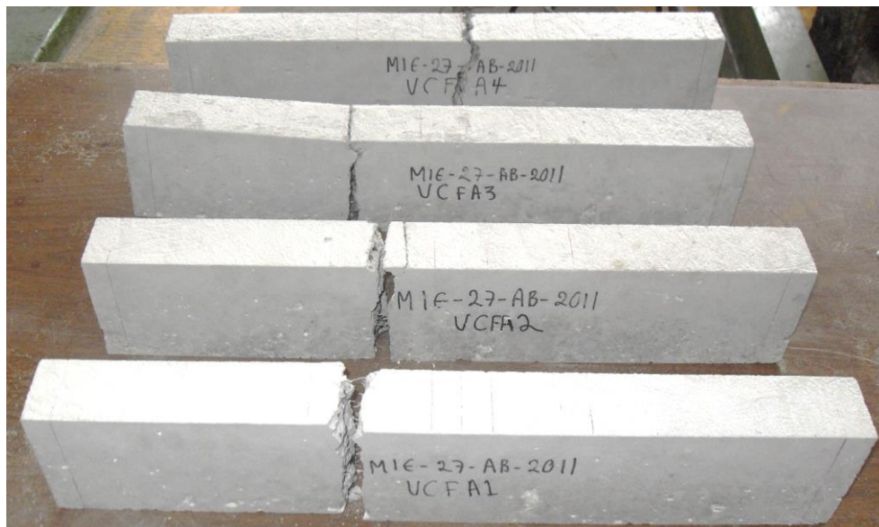
Figura 6.2.5 Localización de las fallas de las vigas de concreto reforzado con fibras de acero
