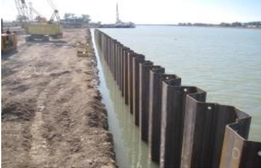
**Figura 5.3 Tablestacas de acero para muelle**
