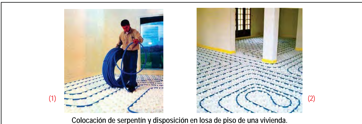
Figura C.81 – LOSAS DE SOPORTE CON SERPENTINES REVERSIBLES INCORPORADOS - Fuente: (1) Les cahiers techniques du bâtiment No. 253, 2005, p. 38 y (2) catálogo de productos, empresa ACOME (THERMACOME), portada
