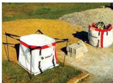
Su llenado puede hacerse a mano o con máquinas y durante éste se requiere mantenerlo abierto con la ayuda de 4 piquetas que tengan sus tirantes. Una vez llenadas se unen y amarran los tirantes entre sí para su cierre.
