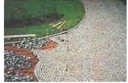
Figura B.691 – PAVIMENTOS A BASE DE ADOQUINES CÚBICOS DE PIEDRA NATURAL formando aparejos en forma circular - Fuente: Richtig Pflastern, Heidi Howcraft, Callwey, 2001; p. 82
