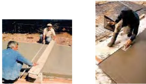
Figura B.610 – FORMADO EN FRESCO DE UNA JUNTA MOLDEADA Y REBORDEO DE ARISTAS
