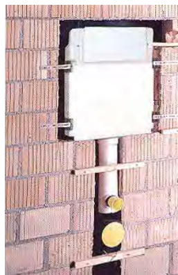
Empotrado de tanque de WC en muro
