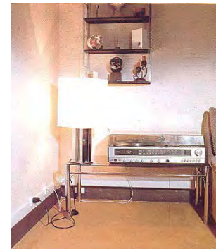
Figura B.305e – ASPECTO DEL USO DE CANALETAS para la alimentación a equipo de sonido.
