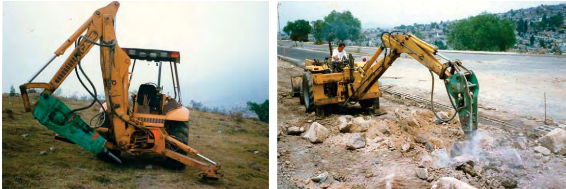
Figura 5.11b – EMPLEO DE DOS MARTILLOS ROMPEROCA (Marca MONTABERT BRH-125 y BRH-250) MONTADOS SOBRE 2 CARGADORAS-RETROEXCAVADORAS que permitieron un trabajo rápido y económico de excavación en tepetate duro y roca.
