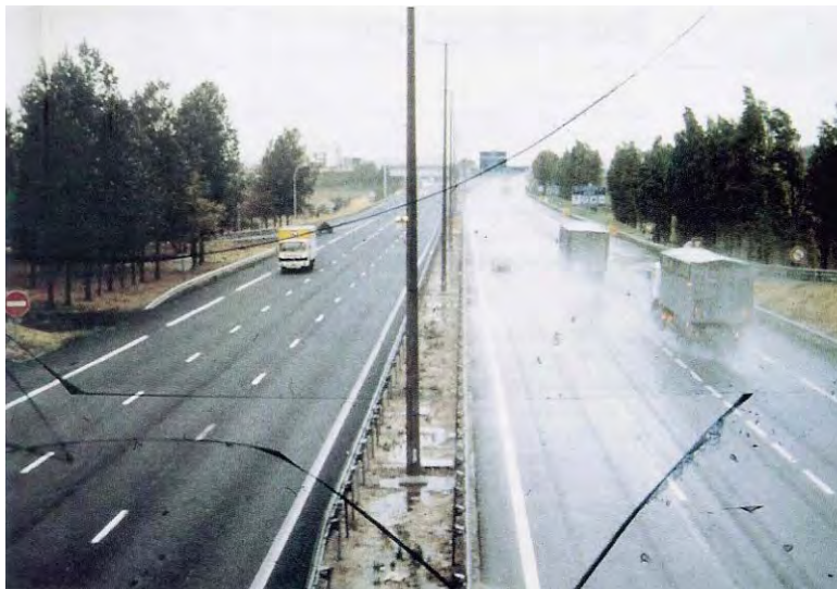
Figura B.760b – PAVIMENTO BBSG = Concreto Asfáltico Convencional CON Proyecciones de Agua (Béton Bitumineux Semi Grenu - Traditionnel)
