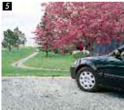
5 Compactar la grava utilizando un rodillo vibratorio o una compactadora de placa vibratoria plana.
