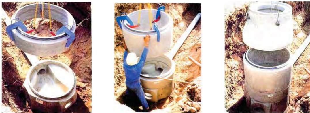
Figura B.534 – MONTAJE DE POZOS DE VISITA DE CONCRETO PREFABRICADO
