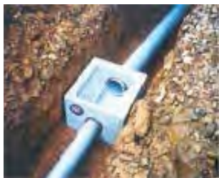
Figura B.525a – La CAMA DE ARENA a utilizar tendrá las características idénticas a las de las tuberías – Fuente: Exécution des travaux d'assainissement; FIB, CERIB, CIMBÉTON; p. 11
