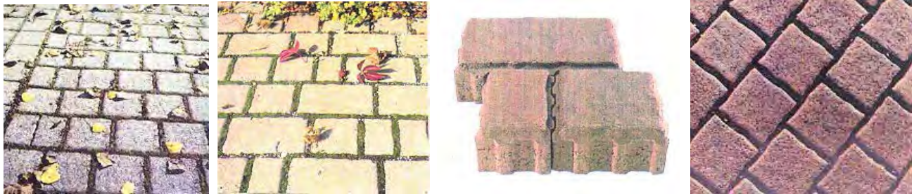
Figura B.748 – ADOCRETO CON JUNTA RELLENA CON PASTO
