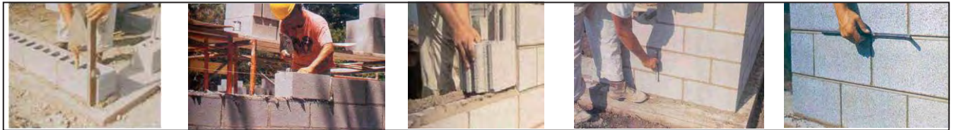
B.- Obras de Mampostería
