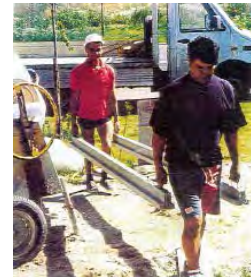
Figura B.151a – VIGUETAS PRESFORZADAS DE CONCRETO DE ALTO DESEMPEÑO MANUPORTABLES para losas de entrepiso y cubiertas con capa de compresión colada en el sitio cuya alta resistencia permite mayores claros sin sobrepeso para la estructura.
