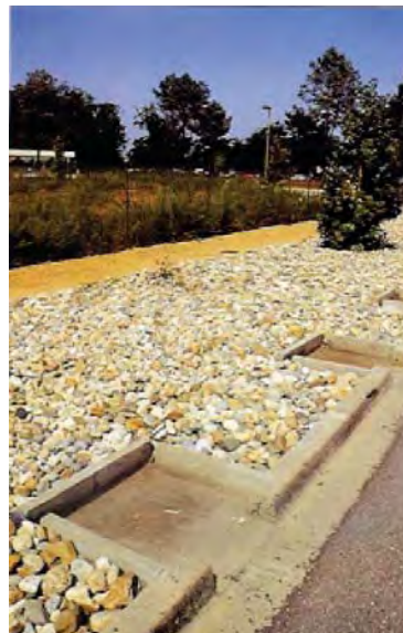
Figura C.21 – CASO DE TRINCHERA APARENTE
