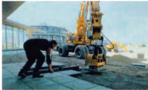
Figura B.705 – COLOCACIÓN MECANIZADA DE LOSETAS SOBRE CAMA DE ARENA
