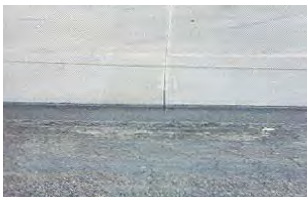
Figura B.776 – CAPA DE CONCRETO (Whitetopping) sobre pavimento de asfalto donde se aprecia la mejora en durabilidad potencial y acabado de superficie así como un color claro que reduce la captación de calor radiante.
