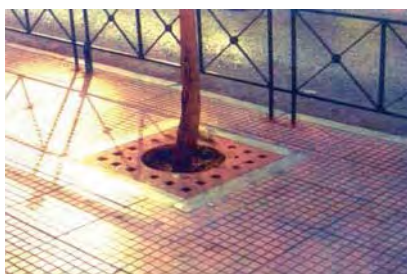
REJA CON PIEZAS DE CONCRETO CON COLOR
