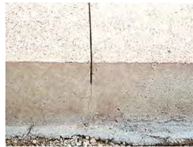
Figura B.636b - JUNTA DE CONTRACCIÓN cortada con disco sobre concreto endurecido después de 4 a 12 hrs de su colado.
