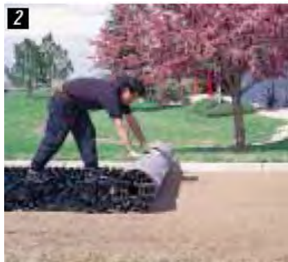
2 Desenrollar el adopasto de plástico alineando el lado de los orificios de sujeción con el lado de las clavijas
