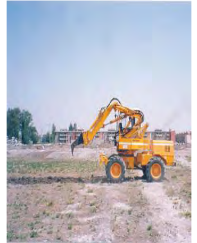
Diente Ripper aflojando el suelo antes de excavar
