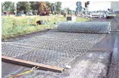
Figura B.628c – PROCESO DE ENCARPETADO CON MALLA DE ARMADO
