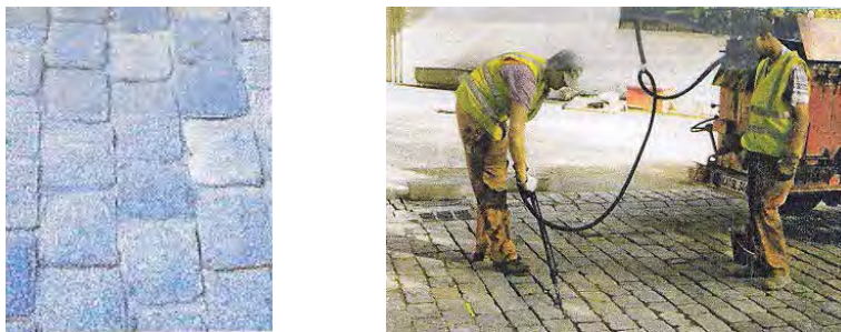
Figura B.696 – JUNTEO DE ADOQUINADO DE PIEDRA Fuente: Catálogo publicitario SHELL, U.S.A.
