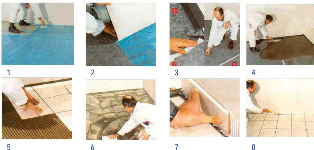
Figura B.214 – DESCRIPCIÓN FOTOGRÁFICA DEL PROCESO DE EJECUCIÓN
