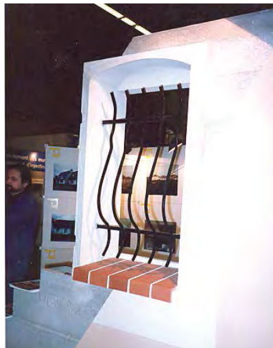
Figura B.454 – REJAS EN VENTANAS para la protección contra los actos vandálicos Fotografía en exposición BATIMAT
