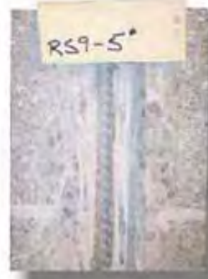
2) CORTE DE MURO POR CASTILLO AHOGADO MOSTRANDO LA TOTAL CONSOLIDACIÓN DEL CONCRETO DE RELLENO CON UN VIBRADOR DE VARILLA
