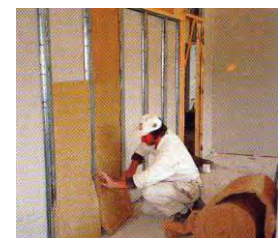
Colocación de paneles semi-rígidos de lana de lino sobre bastidor Doc TEXTINAP; p. 75
