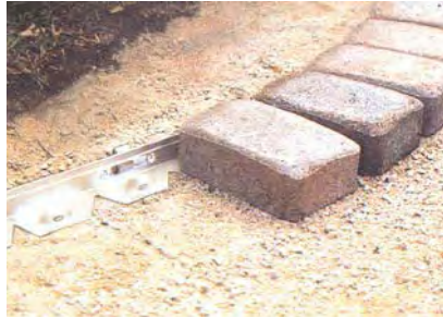
Figura B.679 – CONFINAMIENTO DE BORDES DE PAVIMENTOS CON TIRAS CLAVADAS BAJO LAS PIEZAS PERIMETRALES Catálogo de producto, empresa PREMALLOC CORPORATION
