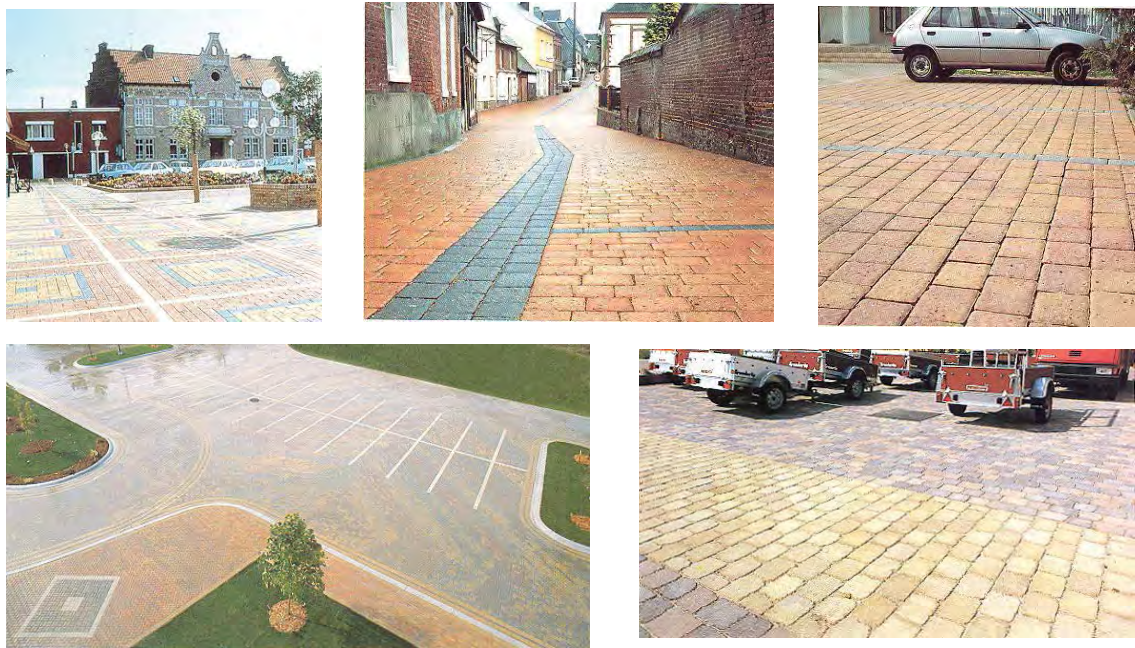
Figura B.605 – SEÑALIZACIÓN INTEGRADA AL DISEÑO DEL PAVIMENTO por medio de variaciones de colores y geometrías de las piezas de adoquín
