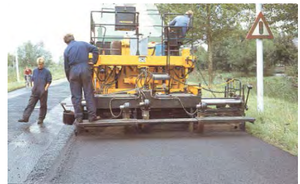
Figura B.628c – PROCESO DE ENCARPETADO CON MALLA DE ARMADO
