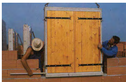
Figura B.140d – Alineación, nivelación y ajuste durante el montaje.
