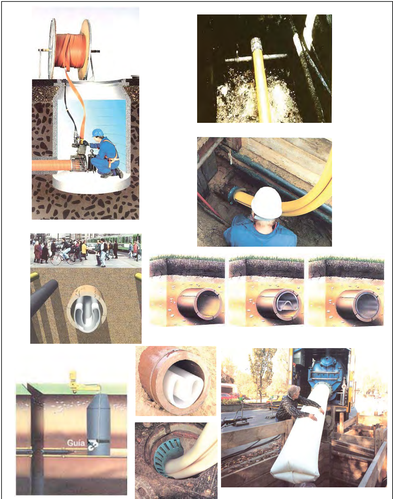
Figura B.598-B – REHABILITACIÓN DE TUBERÍA por forrado de paredes interiores con fundas flexibles - Fuente: Catálogos de empresa PHOENIX SERVICES
