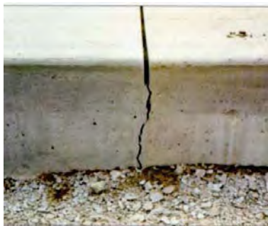
Figura B.636a - JUNTA DE CONTRACCIÓN moderada en concreto fresco con herramienta manual.
