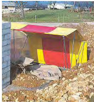
Figura A.88 – CUBIERTA PARA UNA ZONA DE LA OBRA
