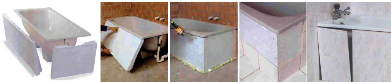
Figura B.268 – TINAS SUSTENTADAS en reducidos apoyos resilientes para mitigar la transmisión del ruido con un registro invisible en los faldones perimetrales de la tina.
