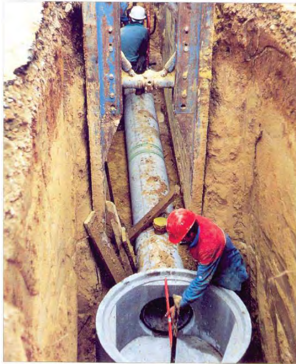
FIGURA A.286 – EJECUCIÓN DE RED SANITARIA con tubería, pozos de visita y piezas de conexión completas (sin cortes) gracias a un análisis computarizado de despiece.
