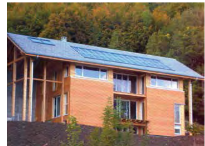
Sobre azoteas inclinadas
