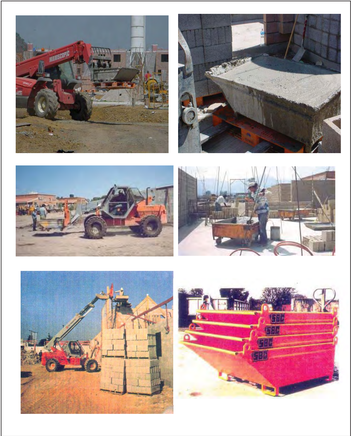
Figura A.103 – ACCESORIOS – TRANSPORTE Y UTILIZACIÓN DE ARTESAS PARA MORTERO - Las máquinas pueden entregar mortero en artesas y, en casos de gran demanda, entregan las artesas y los albañiles las mueven en su área de trabajo gracias a que tienen ruedas de eje-loco.
