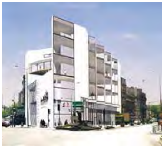
Figura B.456 - EMPLEO DE MUROS DE CONCRETO BLANCO AUTOLIMPIABLE EN EXTERIORES
