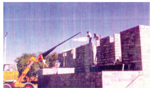
Aguilón – colocación de piñón precolado
