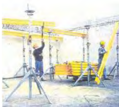
Figura A.158c – COLOCACIÓN DE LARGUEROS SOBRE CABEZAS DE PUNTAL
