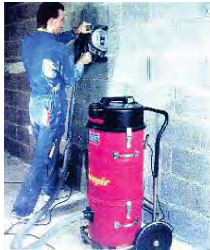
Figura A.199 – RANURADORA O ROZADORA DE MUROS para el ahogado de canalizaciones. Para la perforación de muros para hacer pasos de instalaciones es también preferible utilizar taladros con sacabocados en vez de cincelos y marros para no debilitar tampoco a los muros por esta causa.
