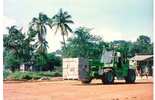
3.- ELEVADORTELESCÓPICA – Marca MERLO (Italia) con autoestabilizadores frontales transportando un palet de block de concreto con el brazo retraído. Puede notarse la buena visibilidad para el operador por el brazo telescópico bajo logrado en su diseño.
