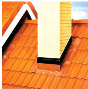
Figura B.225 – EMPLEO DE BANDAS FLEXIBLES con color integral empleadas en la unión de la cubierta con tiros de chimenea, con muros laterales o con cualquier otro elemento emergente o de remate.
