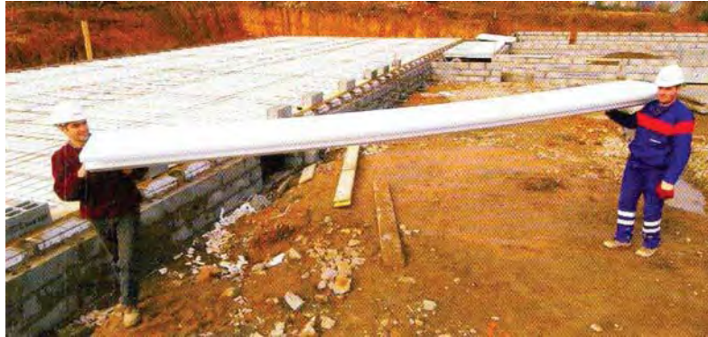
Figura B.170a – BOVEDILLAS CON LONGITUD DE TODO EL CLARO A LIBRAR
