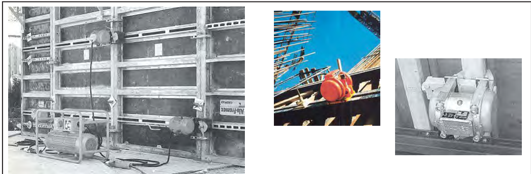
Figura A.187a – UTILIZACIÓN EN CIMBRAS INDUSTRIALIZADAS
