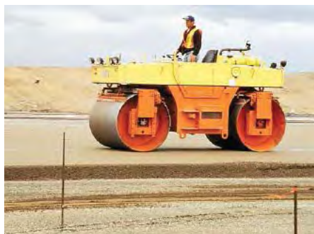
Figura B.645 – PROCESO DE COMPACTACIÓN DE CONCRETO CON RODILLO
