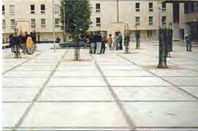
Figura B.646 – EMPLEO DE LOSAS DE GRAN FORMATO RIBETEADAS con ángulo de acero como pavimento de una plaza exterior
