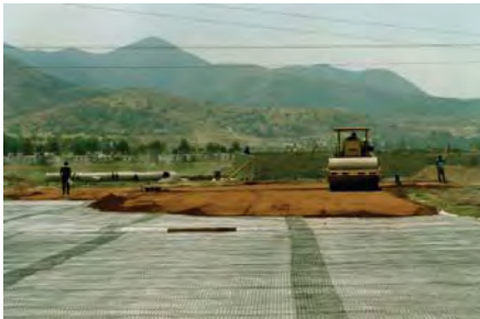
Compactación de suelo en capas de 20 cm
