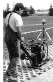
Figura A.194 – APISONADORA CON MOTOR TÉRMICO
