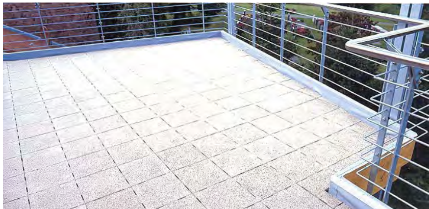
Figura B.750 – ADOCRETOS Y LOSETAS CON JUNTAS ABIERTAS para permitir la percolación del agua de lluvia - Fuente: Catálogo de productos, empresa ZOONT JENS
