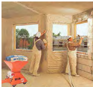
Figura 4.460d - APLICADORA DE PASTAS con diferentes posibles texturas Fuente: Catálogo de Productos, Empresa PFT PUTZ UND FORDERTECHNIK
