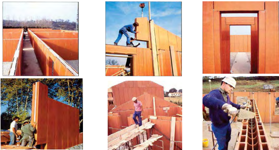
Figura B.99 – MUROS MONOLÍTICOS A BASE DE PANELES Fuente: Catálogo de Productos, Empresa GUIRAUD FRÈRES
