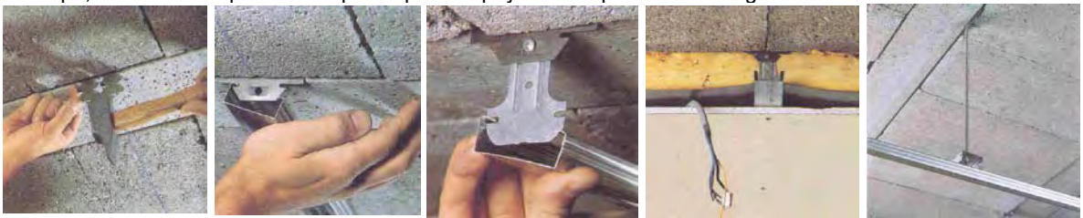
Figura B.179e – COLGADORES – Por diversos modelos de suspensión (de los que se dan algunos ejemplos).
