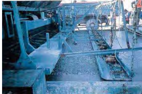
Figura B.641 – MÁQUINA EXTENDEDORA para el clavado de grava en pavimentos en estado fresco - Fuente: Voiries et Aménagements Urbains en Béton Tome-2, Mise en Oeuvre, T-51 CIMBÉTON; p. 71.
