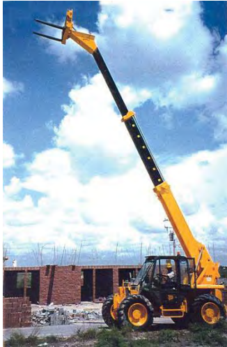
1.- ELEVADORTELESCÓPICA – Marca JCB (Reino Unido) autoestable (sin necesidad de estabilizadores) portando horquillas porta-palets.
