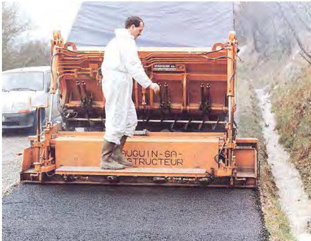
Figura B.621 – PARA ENCARPETADOS DE POCO VOLUMEN (caso de proyectos de vivienda) como vialidades y áreas de estacionamiento, el uso de finishers montadas sobre camiones de material bituminoso, son una opción eficiente y rentable en obras pequeñas y medianas, por su rapidez de ejecución.
