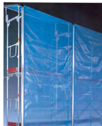
Figura A.90d – PROTECCIÓN DE ANDAMIAJE A TODA LA ALTURA
