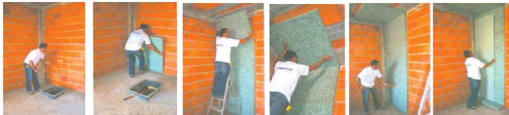
Figura B.208 – ABSORCIÓN ACÚSTICA POR MEDIO DE DOBLAJE CON TABLAROCA Y PIEZAS DE ESPUMA FLEXIBLE DE POLIURETANO - Fuente: Catálogo de productos, empresa AGLOMEX ACOUSTIQUE
