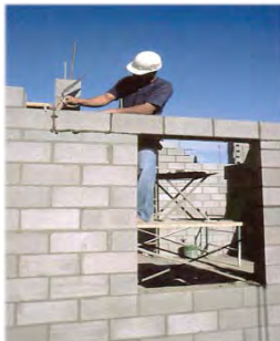
Figura B.133 – SECUENCIA DE COLOCACIÓN DE DINTELES METÁLICOS
