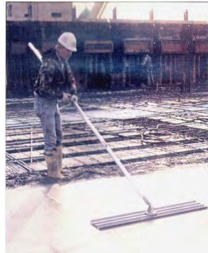
Figura A.163 - ALISADOR PARA ACABADOS DE LOSAS Y FIRMES DE CONCRETO
