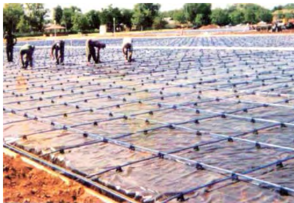
Figura B.62a – CIMBRADO DE COSTADOS E INSTALACIÓN DE TENDONES PARA UNA LOSA DE CIMENTACIÓN POSTENSADA
