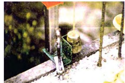
Figura A.154 – PLOMEO DE REGLA Fuente: Información técnica, Empresa MACC
