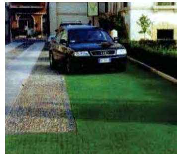
Figura B.722d – Para protección en las orillas, con fines estéticos y de mantenimiento, podrá diseñarse un material durable para realizar bordes que separen los recubrimientos permeables de áreas adyacentes de césped o simplemente que delineen un camino para camiones de bomberos. En el caso del adograva de plástico , estos bordes podrán evitar que la vegetación atraviese los límites mezclándose con el sistema de grava y además, podrán evitar que el relleno de grava de las orillas migre. El acero, el aluminio, la madera, el ladrillo y el concreto son todos materiales aceptables para realizar dichos bordes. Se debe mantener el nivel de los bordes ligeramente más alto que el nivel del adopasto permeable.
