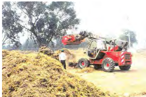
Figura B.38a – PROCESO DE RETIRO DE TIERRA POR CRIBADO Y ROTACIÓN DE CUCHARÓN para posterior triturado de la capa vegetal producto de despalme.
