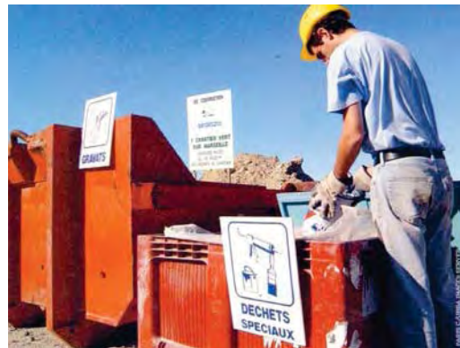
Figura C.141 – CAJAS DE ACERO TRANSPORTABLES CON CAMIÓN PARA DEPÓSITO DE DESECHOS SEPARADOS Fuentes: Revista : Les Cahiers Techniques du Bâtiment – Abril 2005 No. 251 ; p. 12 y Le Moniteur hors-série, Construire Durable, Marzo 2008 ; p. 118
