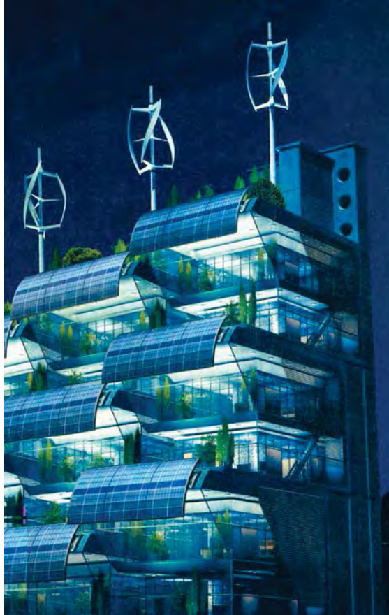
Figura C.41 – EDIFICIO CON MEDIOS DE APROVECHAMIENTO DE ENERGÍA SOLAR Y EÓLICA INTEGRADOS A SU DISEÑO
