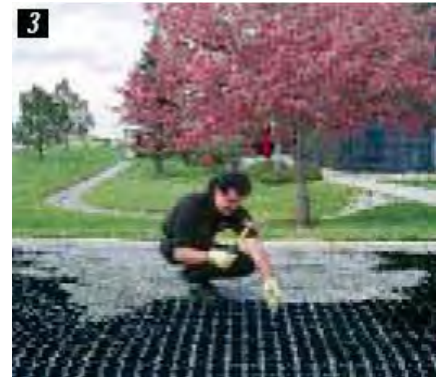
3 Fijar las esteras con las sujeciones proporcionadas (podrán variar el tipo y el tamaño).
