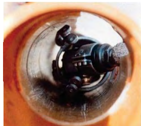
Figura A.277b – Tubo enfundado internamente con abertura de un ramal
