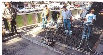
Figura B.797b– OPCIÓN REGLA VIBRATORIA - EJECUCIÓN MANUAL CON EQUIPO MENOR; p. 23
