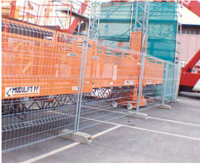
Figura A.100a – BARDA DE OBRA CON MALLA ABIERTA a la que generalmente se cubre con malla plástica cerrada color verde o blanco.
