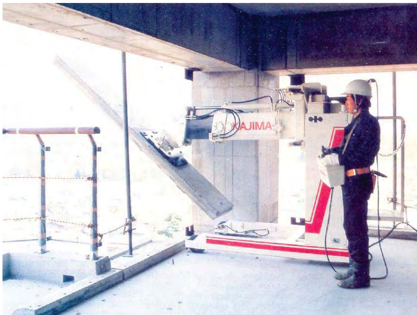
Figura A.274 – ROBOT MIGHTY RAND PARA LA COLOCACIÓN Y FIJACIÓN DE PANELES DE FACHADA
