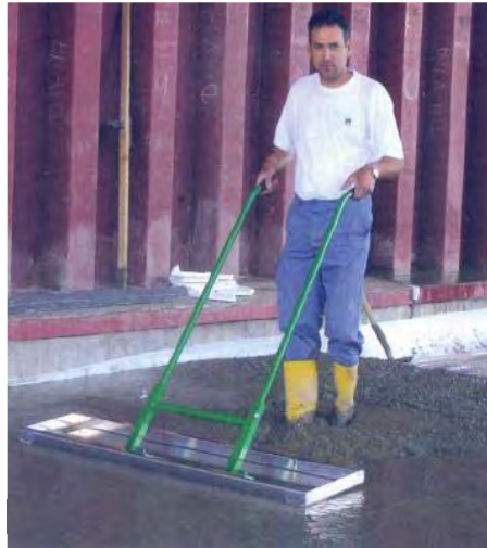
Figura A.163 - ALISADOR PARA ACABADOS DE LOSAS Y FIRMES DE CONCRETO
