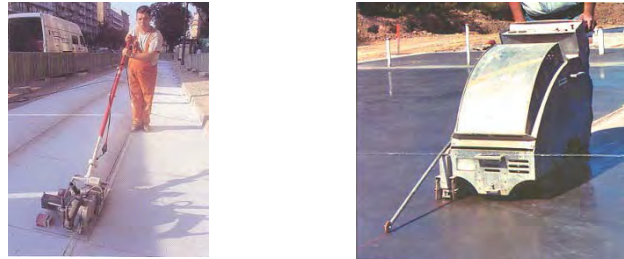
Figura B.794 – CORTADORAS marca SOFF-CUT INTERNACIONAL para cortes a efectuarse el mismo día del colado a terminarse hasta en dos horas después del acabado de superficie del concreto sin provocar daños al acabado Fuente: Le Béton de Ciment Mince Collé « BCMC » –T60 CIMBÉTON, Francia, p. 25
