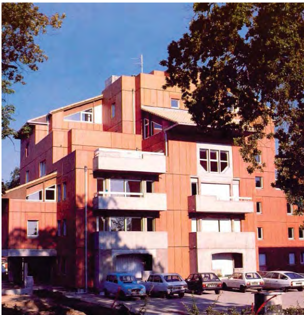
Figura B.104d – COMBINACIÓN DE PANELES DE CERÁMICA CON ELEMENTOS DE CONCRETO
