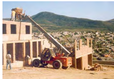
PROCESO DE COLADO CON VOLQUETE Y ELEVADORA MULTIFUNCIÓN CON TOLVA PARA CONCRETO
