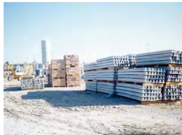
Palets para viguetas presforzadas - Estibado de materiales en almacén y a pie de obra
