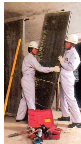
Figura B.119 – PANELES MODULARES DE CONCRETO ARMADO CON HUECOS DE ALIGERADO: Se puede apreciar el incremento de rendimiento en la colocación el cual puede llegar a ser de 6 veces el de los muros de ladrillo y del doble con respecto a los muros de block normal - Fuente: ACOTEC
