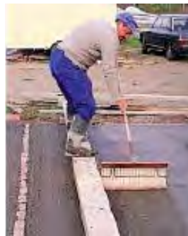
Figura B.638 – CEPILLADO DEL CONCRETO
