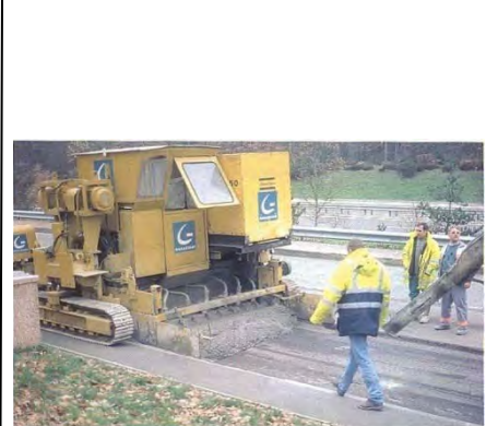
Figura B.798 – EJECUCIÓN MECANIZADA CON CIMBRA DESLIZANTE; p. 23
