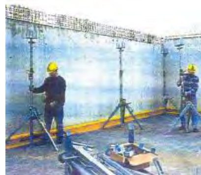
Figura A.158b – POSICIONAMIENTO DE LARGUEROS DE MADERA
