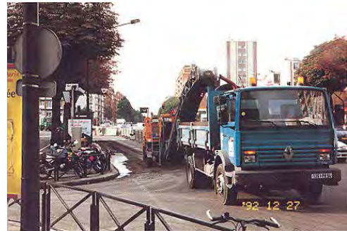
Figura B.627 – ESCARIFICADO DE CARPETA ASFÁLTICA
