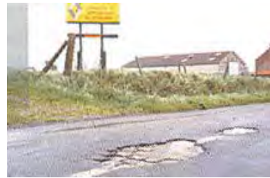
Figura B.628a – DEGRADACIÓN TÍPICA DE LAS CARPETAS DE ASFALTO TRADICIONALES
