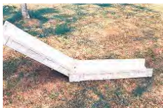
Figura B.579– LAVADEROS SOBRE TALUDES DE CONCRETO REFORZADO CON FIBRA DE VIDRIO –
