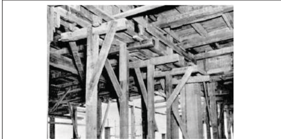
Figura A.141 – CIMBRA TRADICIONAL PARA UNA LOSA
