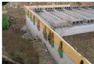
Cimbrado de bordes de losa con atiesadores
