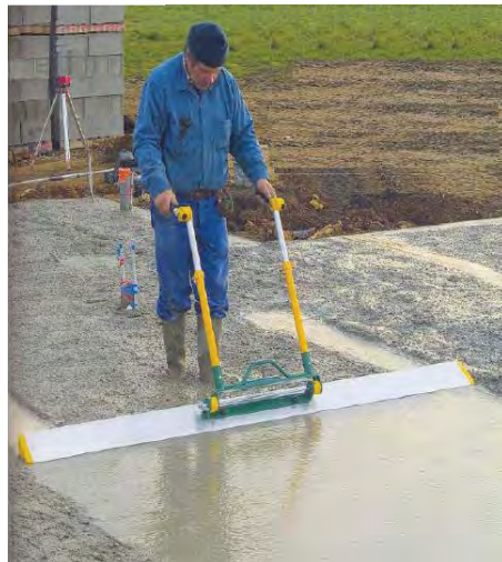
Figura A.164 – REGLA – Apoyada en guías húmedas formadas con el mismo concreto, reglea al concreto en losas y firmes después de haber sido distribuido. Se le pueden intercambiar largos de regla a los brazos.
