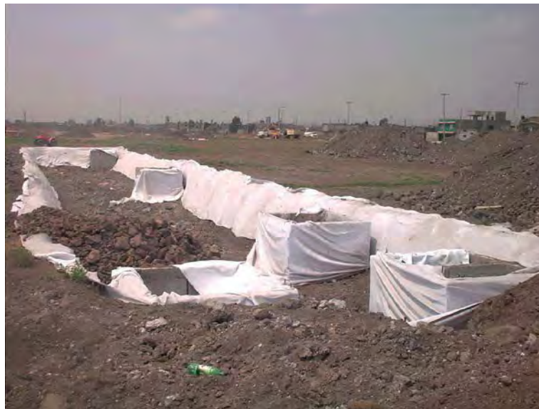
Figura C.22e –INICIO DE EJECUCIÓN DE OBRA DE UNA PARCELA DE REGULACIÓN donde se aprecian los registros terminados, el tendido del geotextil y el inicio del relleno con material granular poroso (Tezontle)
