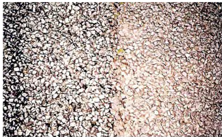
Antes | Después Figura B.765e – DESAZOLVADO DE PAVIMENTOS POROSOS
