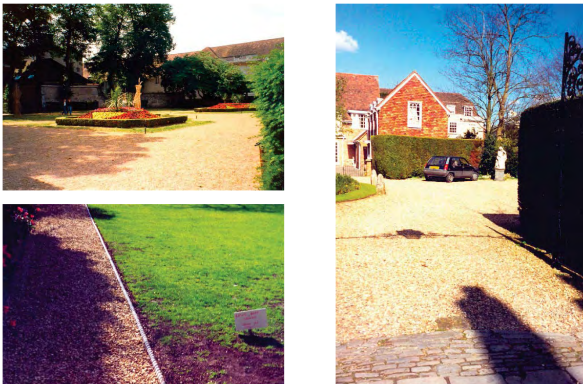
Figura B.808 - EJEMPLOS DE PAVIMENTOS FORMADOS CON SUELO ESTABILIZADO EN SU CAPA DE SUPERFICIE
