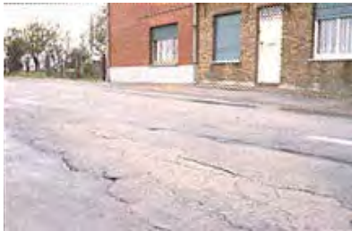
Figura B.628a – DEGRADACIÓN TÍPICA DE LAS CARPETAS DE ASFALTO TRADICIONALES
