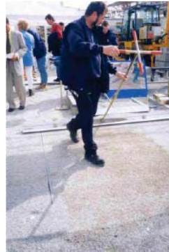
Figura A.177b– REGLA DE EXTENDIDO Y NIVELADO DE CAMA DE ARENA SOBRE GUÍAS
