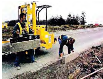
Figura B.738 – DETALLE DE COLOCACIÓN DE TRAMOS DE GUARNICIONES PREFABRICADAS DE CONCRETO
