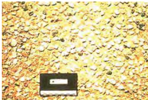
Figura B.801 – ESTRIADO CON CEPILLO para evitar el deslizamiento de los autos al frenar y los resbalones y caídas de los peatones en época de lluvia
