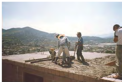
Obra Lomas del Parque III, Infonavit
