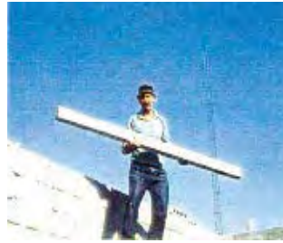
Figura B.151a – VIGUETAS PRESFORZADAS DE CONCRETO DE ALTO DESEMPEÑO MANUPORTABLES para losas de entrepiso y cubiertas con capa de compresión colada en el sitio cuya alta resistencia permite mayores claros sin sobrepeso para la estructura.
