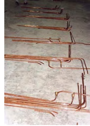
Figura B.248 – ARMADO Y AGRUPAMIENTO DE RAMALEOS HABILITADOS PARA SU COLOCACIÓN EN OBRA Fotografías tomadas en taller de plomería, Empresa PREINSA y Empresa THOMPSON
