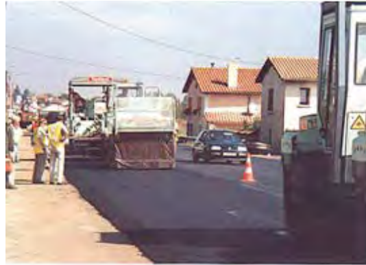
Figura B.619 – TENDIDO DE CARPETA
