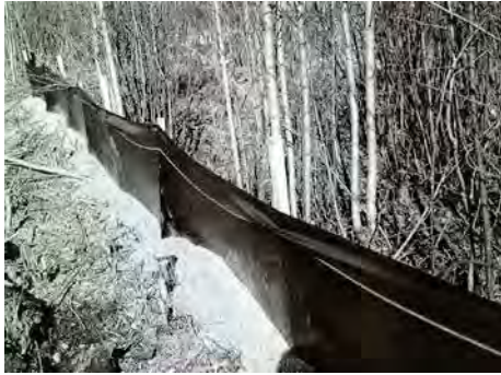
Figura C.145a – BARRERA DE RETENCIÓN DE AZOLVE de 40 cm de altura al borde de la construcción de una vialidad
