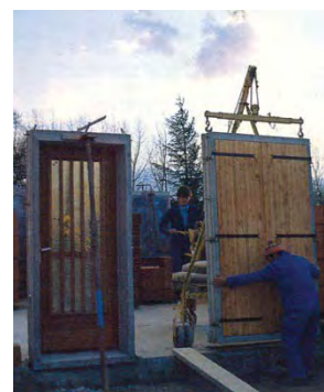
Figura B.140c – Entrega programada y directa descargando sobre las losas para su colocación inmediata en el nivel requerido.
