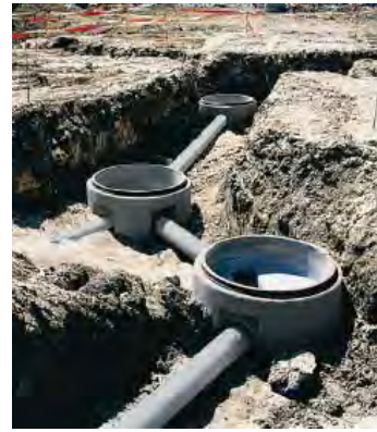
Figura B.505a - COLOCACIÓN DE RED SANITARIA CON LOS COMPONENTES DESPIEZADOS donde se denota su compatibilidad sin necesidad de recortes, ajustes y hechuras en sitio. Ref. Ouvrages d'assainissement en béton, conception et réalisation T94 - CERIB, FIB, CIMBÉTON ; p. 128 y 146.
