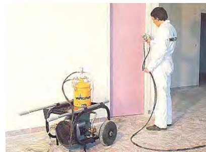
Figura B.460c - LANZADORA DE APLANADOS DE YESO sin desperdicio de material Fuente: Catálogo de Productos, Empresa WAGNER
