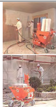
Figura B.460b - LANZADORA DE MORTERO para interiores y exteriores de uso versátil - Fuente: Catálogo de Productos, Empresa PFT PUTZ UND FORDERTECHNIK
