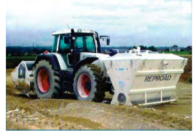
Fig. B.40c – Distribución de cal y agua
