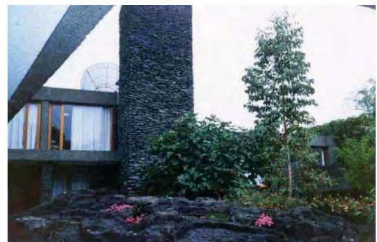
Ejemplo de casa construida con muros y pavimentos de piedra braza obtenida del mismo terreno del Pedregal de San Ángel
