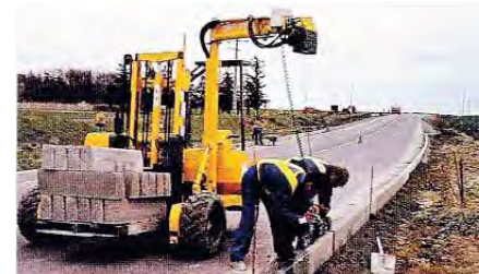
Figura B.738 – DETALLE DE COLOCACIÓN DE TRAMOS DE GUARNICIONES PREFABRICADAS DE CONCRETO
