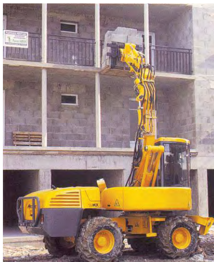
Entrega de material en un segundo piso (tomada del folleto de la empresa MECALAC)
