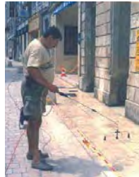
Figura B.452 – APLICACIÓN CON ASPERSOR DE HIDROFUGANTE Y OLEOFUGANTE.
