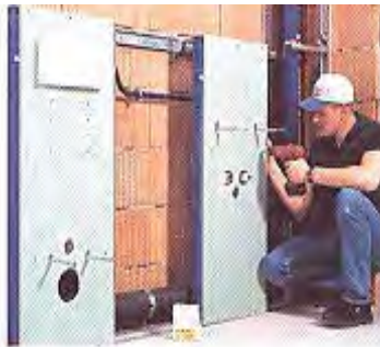
Figura B.255 – INSTALACIÓN DE LA PLOMERÍA EN MÓDULOS (un módulo por cada mueble) conectados y complementados entre sí y con las tuberías de alimentación y descarga general. Con el empleo de ductos técnicos, muretes técnicos y banquetas técnicas se reduce el trabajo a pocas operaciones de montaje.
