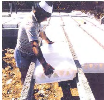
Figura B.170b - BOVEDILLAS DE POLIESTIRENO EXPANDIDO MOLDEADO DE GRAN FORMATO de 2.2 kg/pieza y 1.20 m de largo, destinadas al aislamiento térmico de las losas de concreto armado con viguetas prefabricadas de alma llena (armadas o presforzadas).
