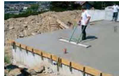
Colado de losa con cimbra y atiesadores
