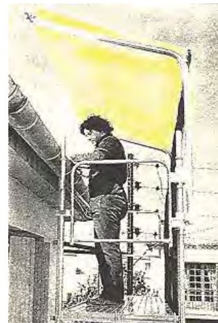
Figura A.90b – CUBIERTA DE LONA SOBRE ANDAMIAJE que permite trabajar en la construcción de muros aún bajo lluvia o sol intenso. Se coloca adosada a la protección posterior de los caballetes.
