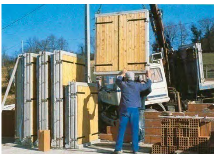
Figura B.140b – Para el montaje puede utilizarse una grúa, una máquina multifunciones o incluso un malacate plegable de dimensiones pequeñas.
