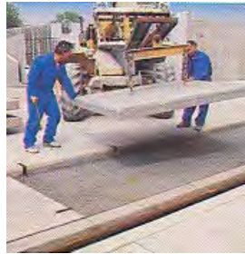
Figura 3.650 – PROCESO DE COLOCACIÓN DE LOSAS PREFABRICADAS DE CONCRETO ARMADO PARA PAVIMENTOS VEHICULARES O PEATONALES
