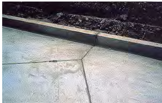
Figura B.793 – El poner especial atención a los detalle en el junteo ayudará considerablemente en el control de grietas y asegurará un excelente desempeño de la sobrecapa de concreto. Hay que asegurarse que las intersecciones en los bordes del pavimento formen ángulos de 90° y que se mantengan rectas hacia adentro un mínimo de 45 cm con respecto al borde del pavimento.
