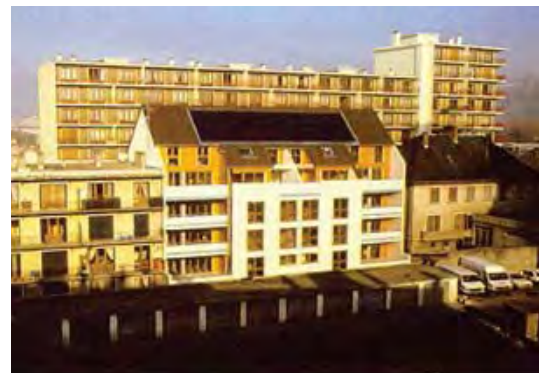
ENERGÍA SOLAR TÉRMICA (para calentamiento de agua)
