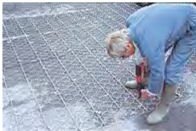
Figura B.628c – PROCESO DE ENCARPETADO CON MALLA DE ARMADO
