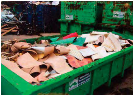
Figura C.141 – CAJAS DE ACERO TRANSPORTABLES CON CAMIÓN PARA DEPÓSITO DE DESECHOS SEPARADOS Fuentes: Revista : Les Cahiers Techniques du Bâtiment – Abril 2005 No. 251 ; p. 12 y Le Moniteur hors-série, Construire Durable, Marzo 2008 ; p. 118
