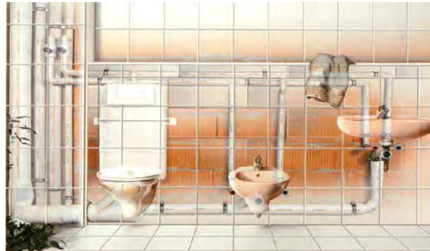
Figura B.218 – FORRADO DE TUBERIA CON MATERIAL AISLANTE
