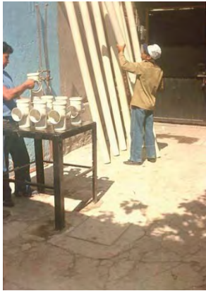
Figura B.249 – PREPARACIÓN DE TUBERÍA DE PVC para corte y formación de ramales de líneas sanitarias
