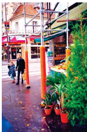
Figura A.90c – FUNDAS CILÍNDRICAS COLOR ROJO DE PROTECCIÓN Y ADVERTENCIA para los transeúntes, utilizadas en andamios apoyados sobre la vía pública.
