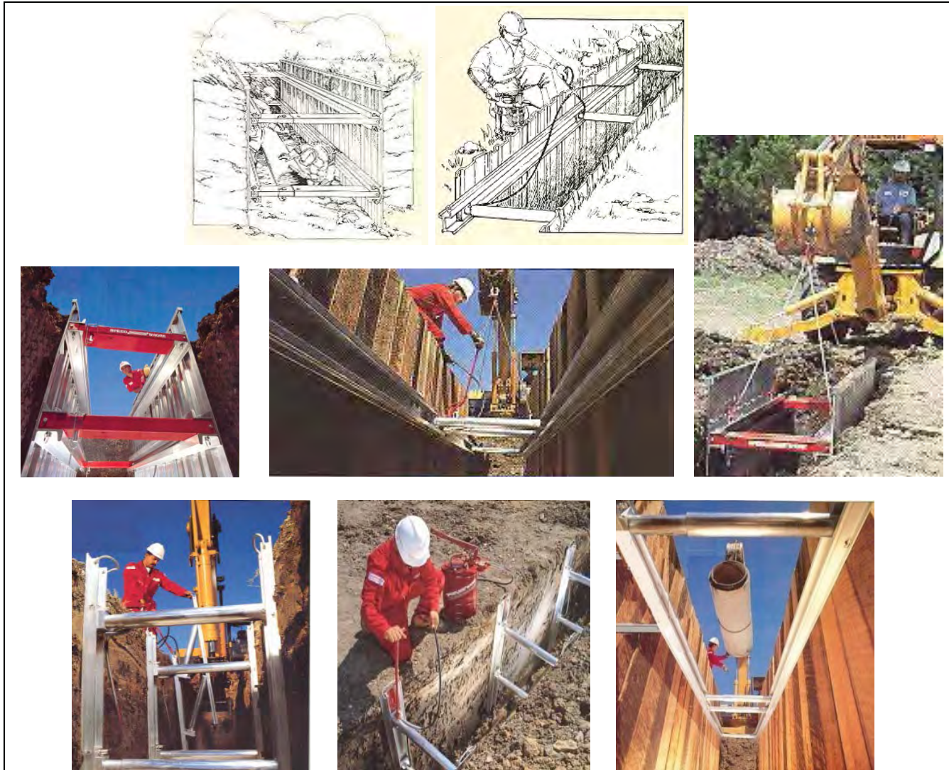
Figura B.485a.- ENTIBACIÓN DE ZANJAS PARA TUBERÍA DE PEQUEÑO DIÁMETRO Fuente: Catálogo de producto, empresa SPEED SHORE
