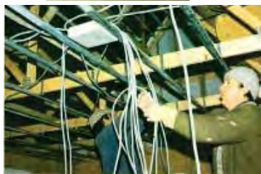
Figura B.300 – PROCESO COMPLETO DE PREFABRICACIÓN Y DE COLOCACIÓN EN OBRA DE INSTALACIONES ELECTRICAS empleando cables multiconductores formados en base a un diseño específico.
