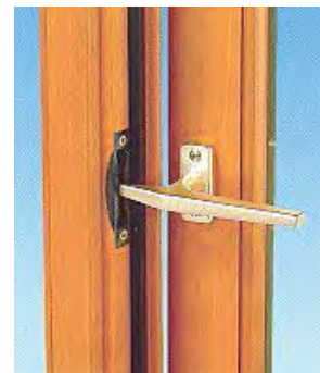
Figura B.404b - ABERTURA BATIENTE mínima por fijación prevista de un extremo de la manija de la cremona insertado en su contra para la entrada regulada de aire fresco. Fuente: Empresa CROISÉES INTER
