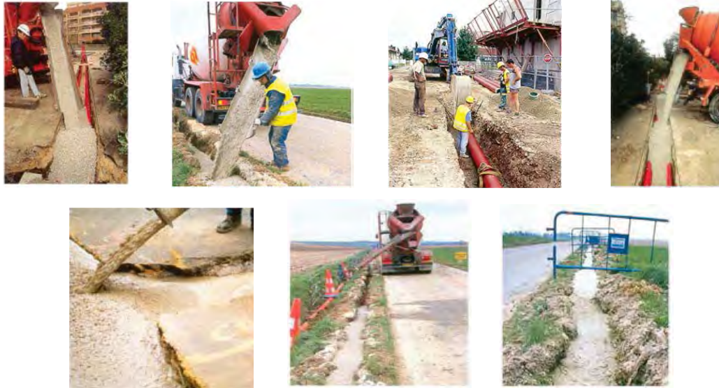
Figura B.508 - TOMAS DEL PROCESO DE VACIADO DEL RELLENO FLUIDO AUTOCOMPACTANTE
