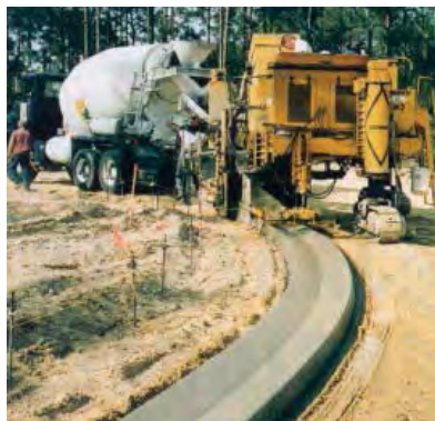
Figura B.733 – GUARNICIONES EXTRUIDAS DE CONCRETO con máquina tipo cimbra deslizante Fuente: Catálogo de producto, empresa POWER CURVERS Inc.
