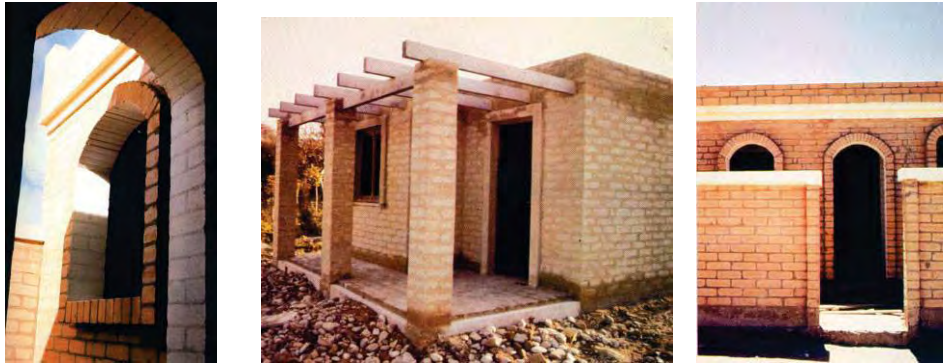
Figura 3.47b – CONSTRUCCIONES HECHAS CON MUROS DE BLOQUES HIPERCOMPRESOS DE SUELO ESTABILIZADO CON CEMENTO donde el material del terreno fue aprovechado. Fuente: Manual de producto – Bloques de Tierra Hipercomprimida Estabilizada – TERO, 1987 – páginas centrales
