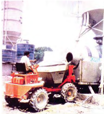
PROCESO DE COLADO CON VOLQUETE Y ELEVADORA MULTIFUNCIÓN CON TOLVA PARA CONCRETO
