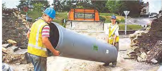
Figura B.584 – EXISTEN GRANDES DIÁMETROS DE TUBERÍAS DE P.V.C. SANITARIO con paredes alveolares cuya ligereza permite su manuportabilidad pudiéndose prescindir de equipo mayor y mejorando con ello las condiciones de seguridad en las obras.
