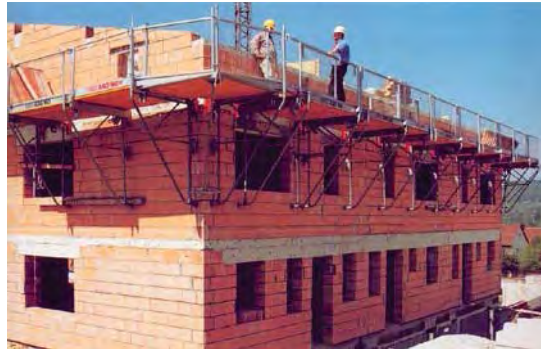
Figura B.97 – BLOQUES DE CERÁMICA DE IGUALES DIMENSIONES A LAS DE LOS BLOQUES DE CONCRETO
