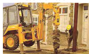
Barrenadora (se pueden utilizar barrenos de varios diámetros)
