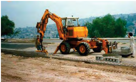
Montaje de piezas de block mecanizado
