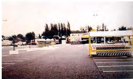
Figura B.761 – ESTRUCTURA CONTENEDORA Y ESTACIONAMIENTO DE UN SUPERMERCADO CON RECUBRIMIENTO DE BBDr (Concreto Asfáltico Drenante)
