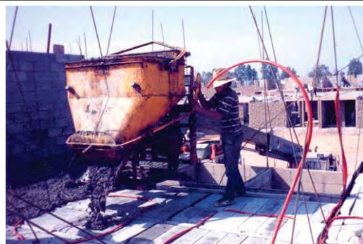
EMPLEO DE TOLVA DE CONCRETO CON DOS OPCIONES DE VACIADO: FRONTAL Y LATERAL
