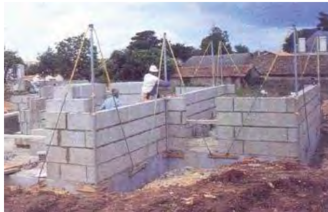
Figura A.149c – COLOCACIÓN DE REGLAS DE ESQUINA SOBRE LOSAS DE PLANTA BAJA
