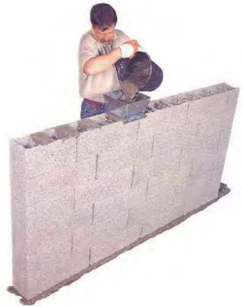
Figura A.173 - EMBUDO de llenado con mortero de huecos en muros de mampostería
