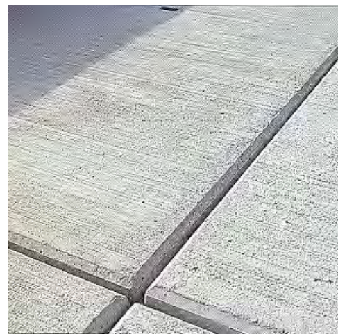
Figura B.648b – LOSAS DE GRAN FORMATO con aristas achaflanadas
