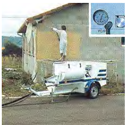
Figura B.460a - LANZADORA DE MORTERO MONOCAPA con color integral Fuente: Catálogo LANZADORA LANCY
