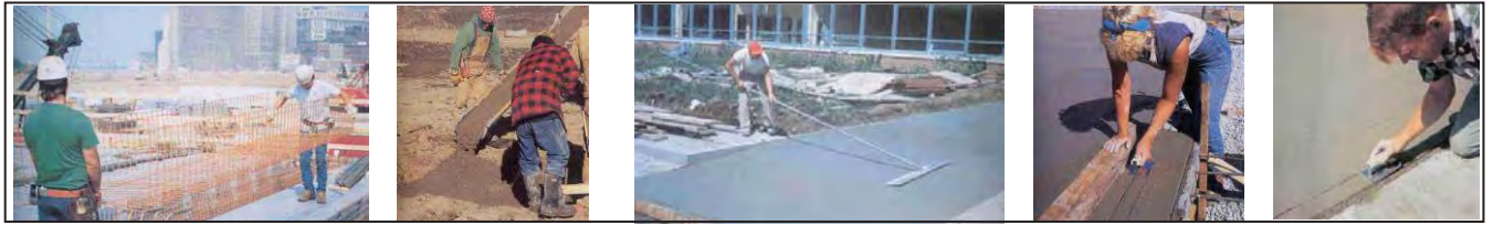
A.- Obras de Concreto
