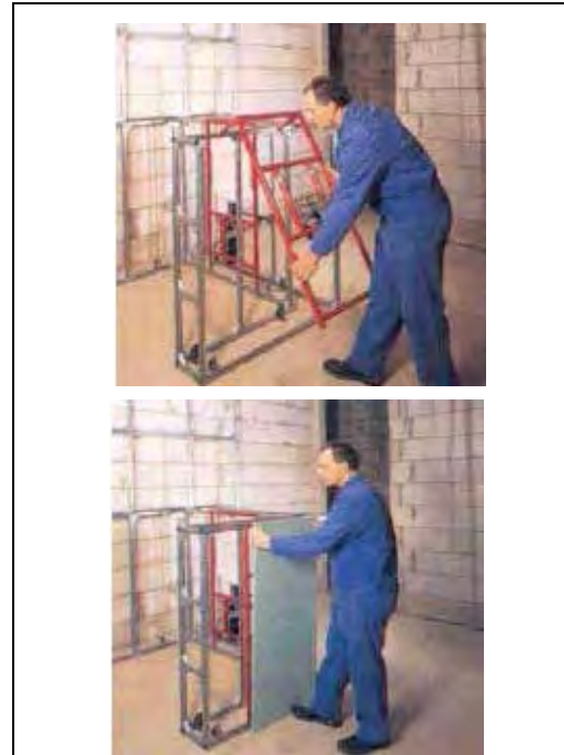
Figura B.258b – INSTALACIÓN HIDROSANITARIA totalmente independiente del proceso de obra negra.
