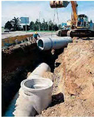
Figura B.505a - COLOCACIÓN DE RED SANITARIA CON LOS COMPONENTES DESPIEZADOS donde se denota su compatibilidad sin necesidad de recortes, ajustes y hechuras en sitio. Ref. Ouvrages d'assainissement en béton, conception et réalisation T94 - CERIB, FIB, CIMBÉTON ; p. 128 y 146.
