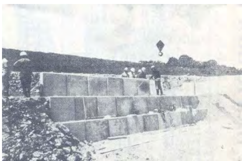
Figura B.20b – DISPOSICIÓN DE LAS PLACAS DE CHAPEO Y DE LOS NEUMÁTICOS
