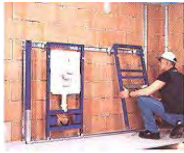
Figura B.255 – INSTALACIÓN DE LA PLOMERÍA EN MÓDULOS (un módulo por cada mueble) conectados y complementados entre sí y con las tuberías de alimentación y descarga general. Con el empleo de ductos técnicos, muretes técnicos y banquetas técnicas se reduce el trabajo a pocas operaciones de montaje.
