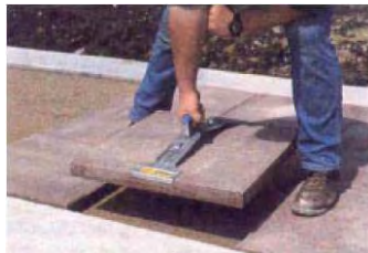
Figura A.178c – PINZAS DE COLOCACIÓN MANUAL POR UNA PERSONA
