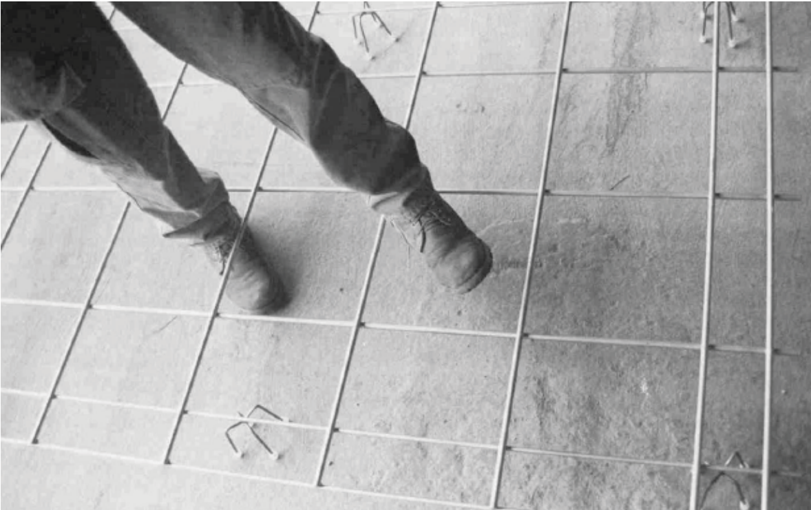
Figura B.45 - MALLA ELECTROSOLDADA de 30 cm x 30 cm de separación en losas de concreto.
