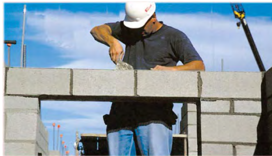
Figura B.133 – SECUENCIA DE COLOCACIÓN DE DINTELES METÁLICOS
