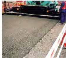
Figura B.755 - TENDIDO DE UNA ESTRUCTURA CONTENEDORA DE CONCRETOS POROSOS Fuente: T-57 CIMBÉTON; p. 26
