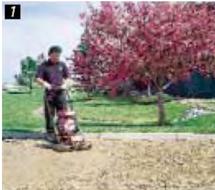
1 Colocar y compactar la arena y la capa de base
