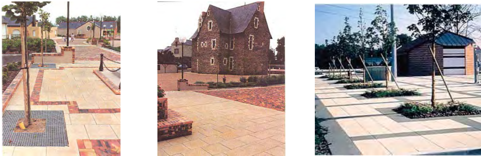
Figura B.699 – RECUBRIMIENTO MODULAR DE LOSETAS DE CONCRETO: variedad de formas, colores y texturas - Fuente: Catálogo de productos, empresa SABLA y voiries et aménagements urbains en béton, T.57; revêtements et structures réservoirs, CERIB, FIB, CIMBÉTON, IVF, 2001; p. 43
