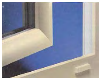
Figura B.433 – CAPUCHÓN DE PROTECCIÓN EN DRENES PARA EVITAR QUE EL VIENTO REGRESE AL INTERIOR DE LOS MANGUETES AL AGUA QUE SE ESTÉ DRENANDO
