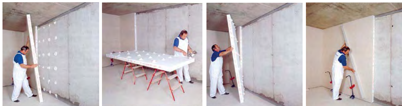
Figura B.199 – VALORES DE RESISTENCIA TÉRMICA EN MUROS DE DOBLAJE A BASE DE TABLAROCA Y POLIESTIRENO EXPANDIDO
