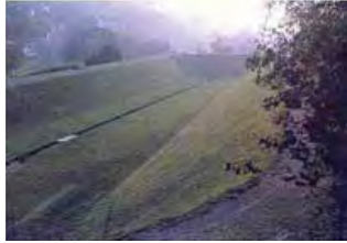
Figura C.32b – PRINCIPIOS DE FUNCIONAMIENTO Y EJEMPLOS DE REALIZACIÓN DE FOSAS, VADOS O ZANJAS DE REGULACIÓN DE AGUA PLUVIAL, FORMANDO PARTE DEL DISEÑO DE PAISAJE EN LOS PROYECTOS
