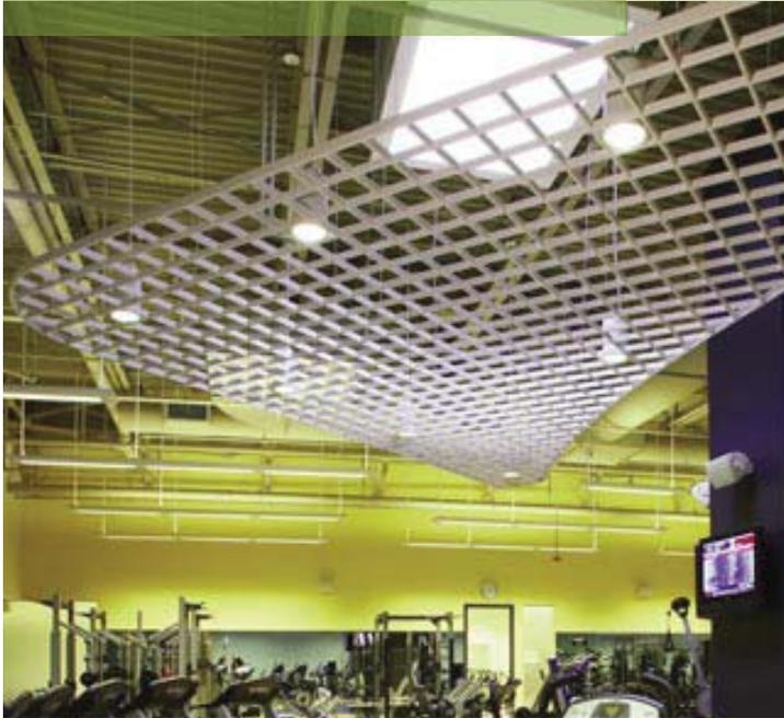
MetalWorks Open Cell (Célula Abierta) Orilla Cuadrada (célula de 6") con sistema de suspensión Suprafine 9/16" y borde perimetral Axiom
