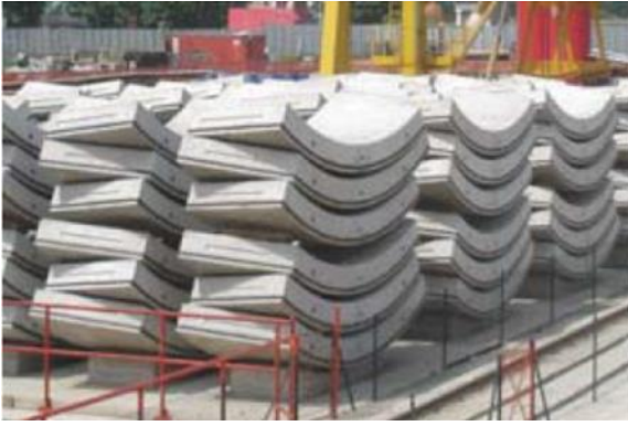
Figura 5. Anillo de dovelas: a) almacenaje de dovelas (Vittorio et al., 2007); b) anillos de dovelas habilitados
