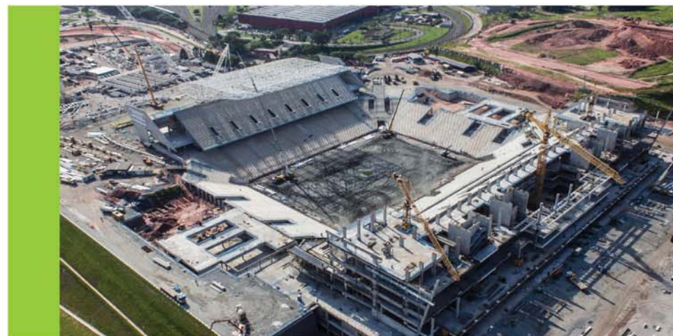
Arena de São Paulo, en proceso de construcción para el Mundial Brasil 2014.
