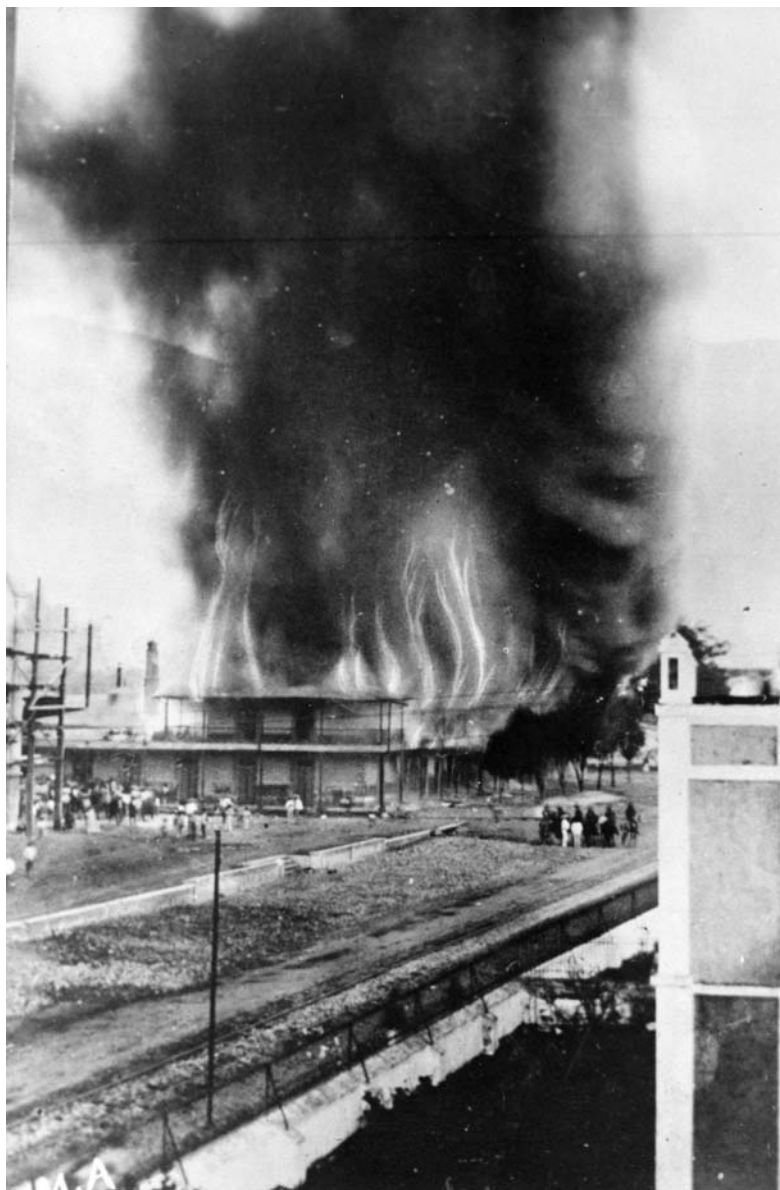
Imagen 15. Incendio en la fábrica de Río Blanco durante la huelga. 7 de enero 1907.
