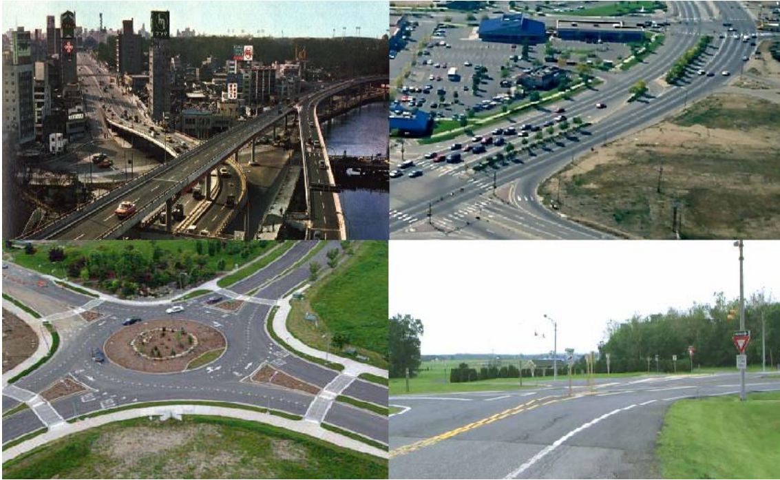
Figura 2-3 Distribuidor vial (arriba izquierda), intersección semaforizada (arriba derecha), glorieta (abajo izquierda) e intersección no semaforizada (abajo derecha)
