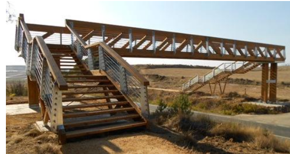
PUENTE ESTRUCTURADO CON ARMADURAS
