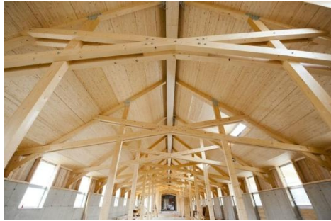
ARMADO DE PALAPA CON MADERA LAMINA
