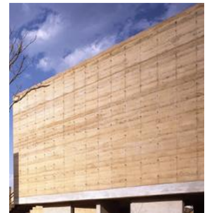
MUROS DE TIERRA COMPACTADA SOBRE MUROS DE CONCRETO
