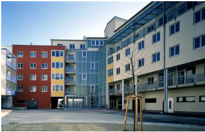
Figura 34. Edificio de viviendas Margarete Shütte-Lihotzky . Franziska Ullmann, 2009
