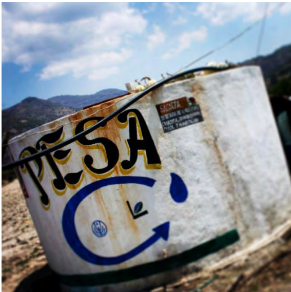
Fotografía 15: Estanque de ferrocemento PESA. Fuente: Propia 2013.
