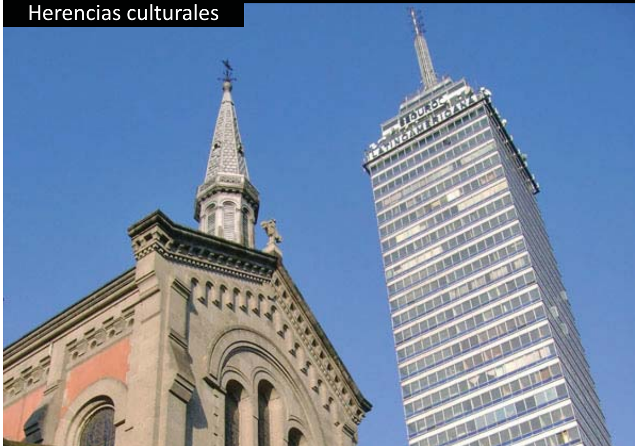
El Templo Expiatorio de San Felipe de Jesús. Al fondo la Torre Latinoamericana, fotografía tomada desde la Avenida Francisco I. Madero. México, D.F. http://photos1.hi5.com/0011/446/074/ZAtrHh446074-02.jpg .
