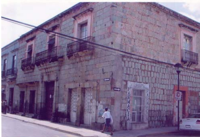
Aspecto de la casa en 1998. en donde se puede apreciar el deterioro que iba sufriendo.
