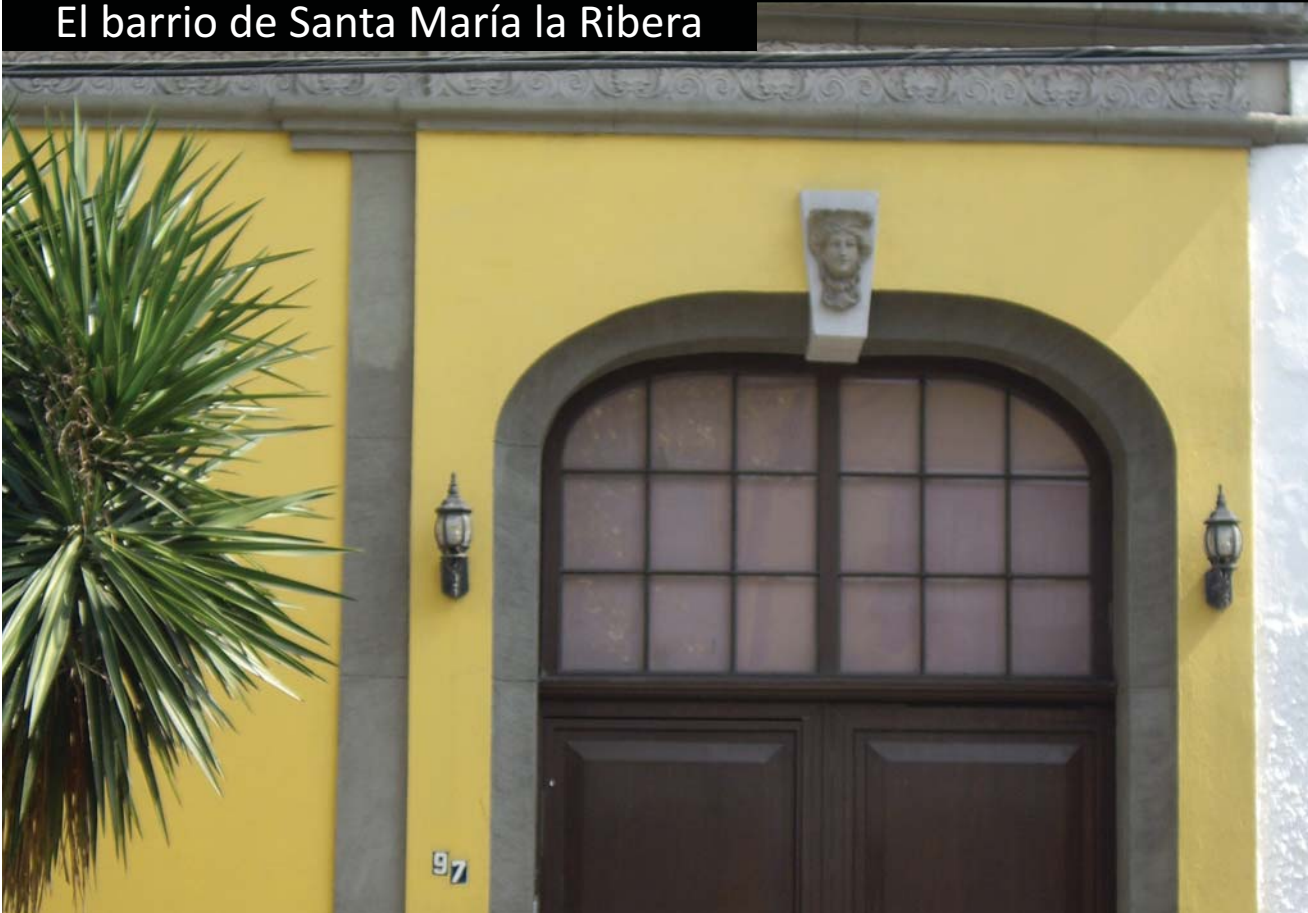
Fachada de una casa característica de la colonia Santa María la Ribera, éste en particular es un caso de conservación sólo de la fachada; pues actualmente corresponde a una vivienda plurifamiliar. Imágen de autoría propia
