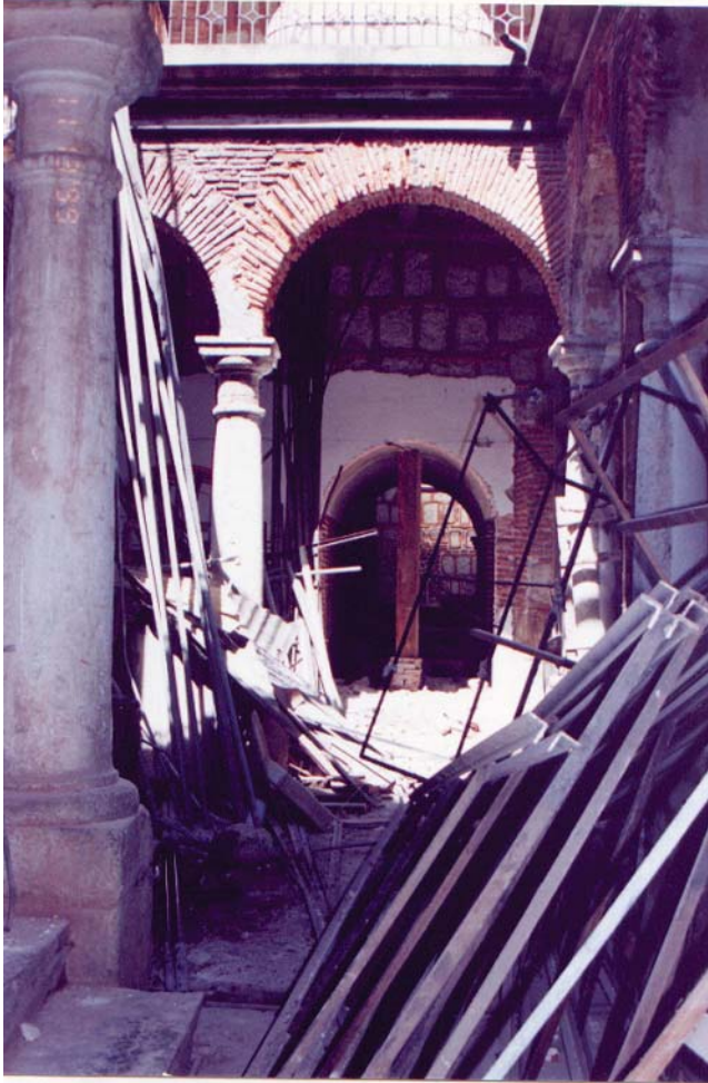
Estado de las crujías antes de la restauración.
