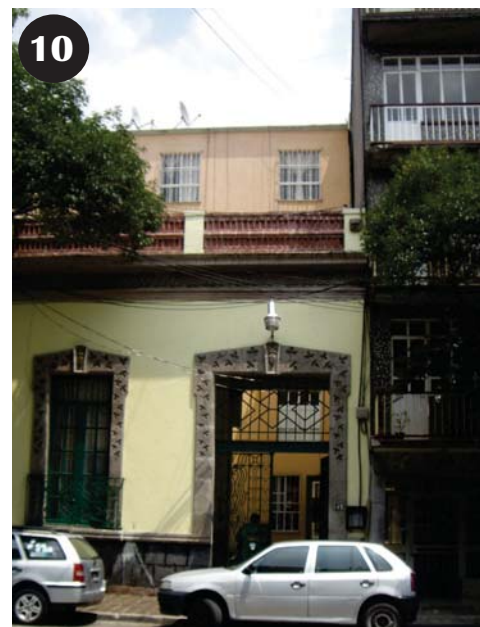
10 Otro ejemplo de rehabilitación mal logrado en la calle de Salvador Díaz Mirón.
