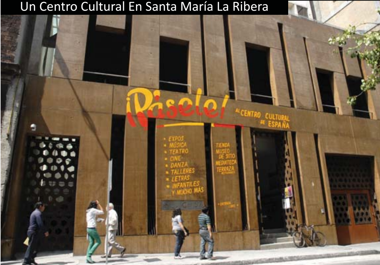
Fachada del edificio realizado en la segunda etapa de construcción del Centro Cultural de España, esta fachada reinterpreta elementos contextuales como las jambas de cantera y la proporción de vanos mediante vacíos.
