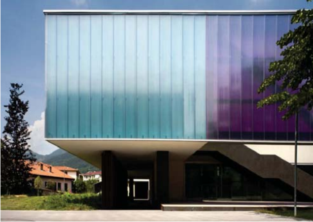
Los materiales empleados en el edificio buscan hacerlo más vistoso y que la gente sienta la atracción de acudir.
