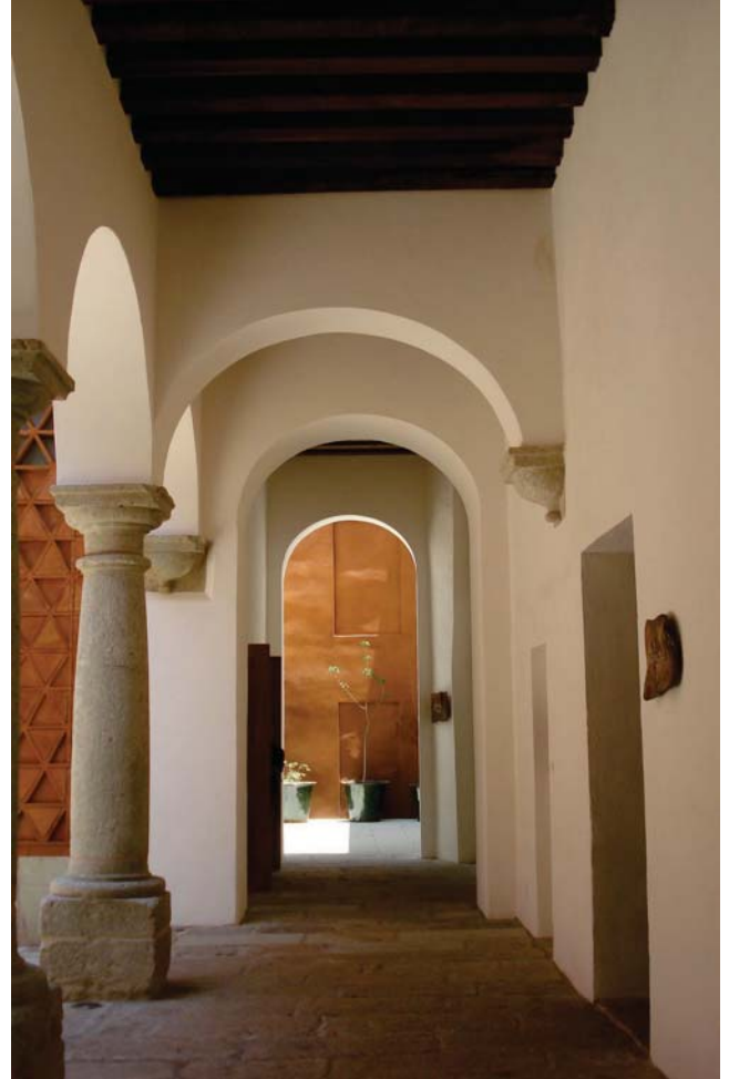
Las crujías ya después de la restauración.
