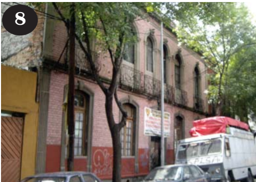
8 Vecindad en condiciones de deterioro, en la calle de Fresno
