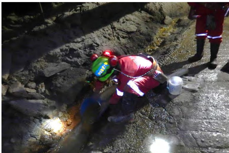
Figura 37. Unión de escurrimientos neutros a la acequia en la rampa Sur
