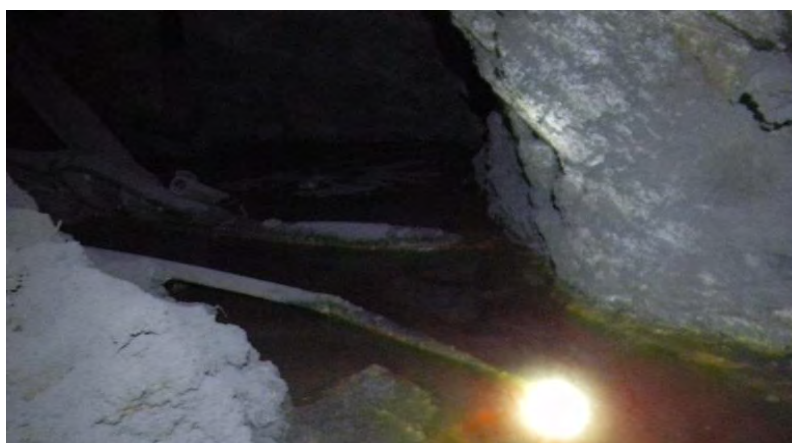
Figura 35. DA-7. Rampa Sur
