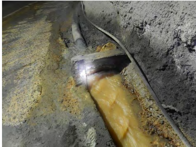
Figura 45. Instalación de una manguera para la canalización del drenaje ácido. Rampa Sur
