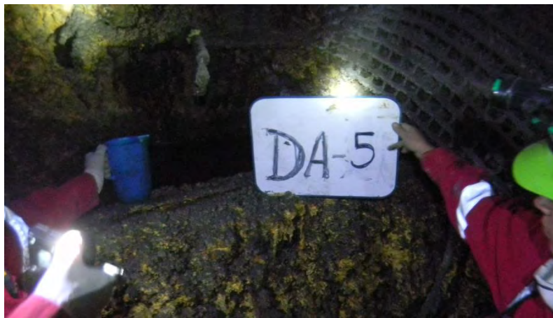
Figura 33. DA-5. Rampa Sur
