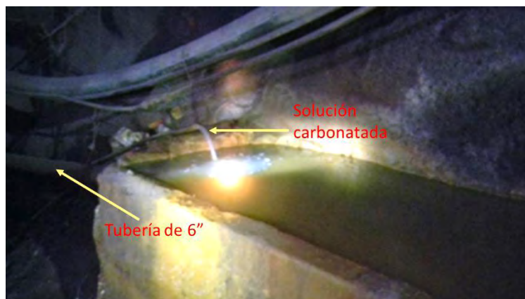
Figura 50. Bombeo de solución neutralizante a la pileta en la rampa Sur
