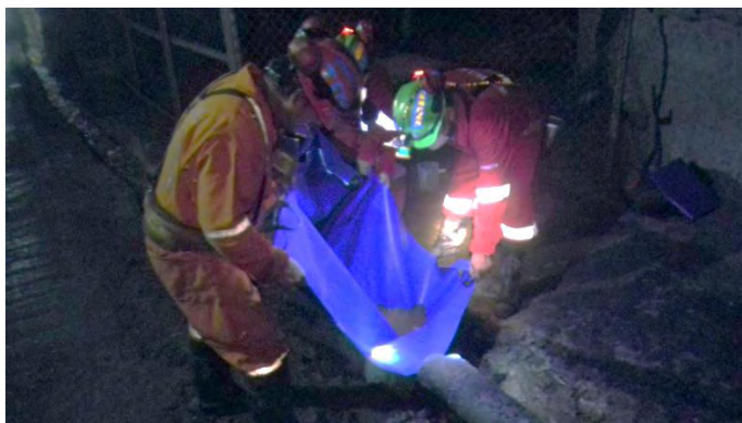
Figura 57. Medición del volumen de agua de tuberías
