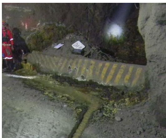
Figura 40. Uso de muro de concreto
