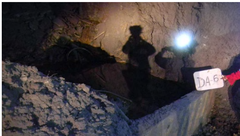
Figura 34. DA-6. Rampa Sur
