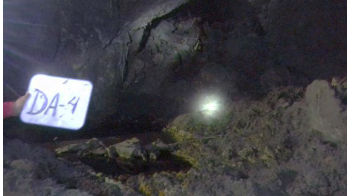
Figura 32. DA-4. Rampa Sur
