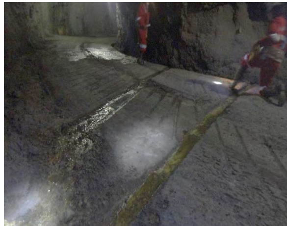
Figura 43. Canaletas sobre la rampa Sur
