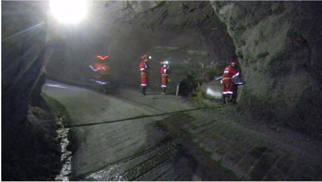
Figura 44. Vista de la ubicación de las canaletas con respecto a la acequia
