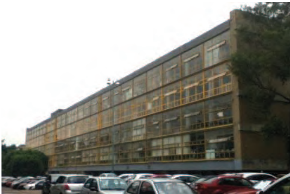
FIGURA 16. Vista actual fachada norte Facultad de Química
