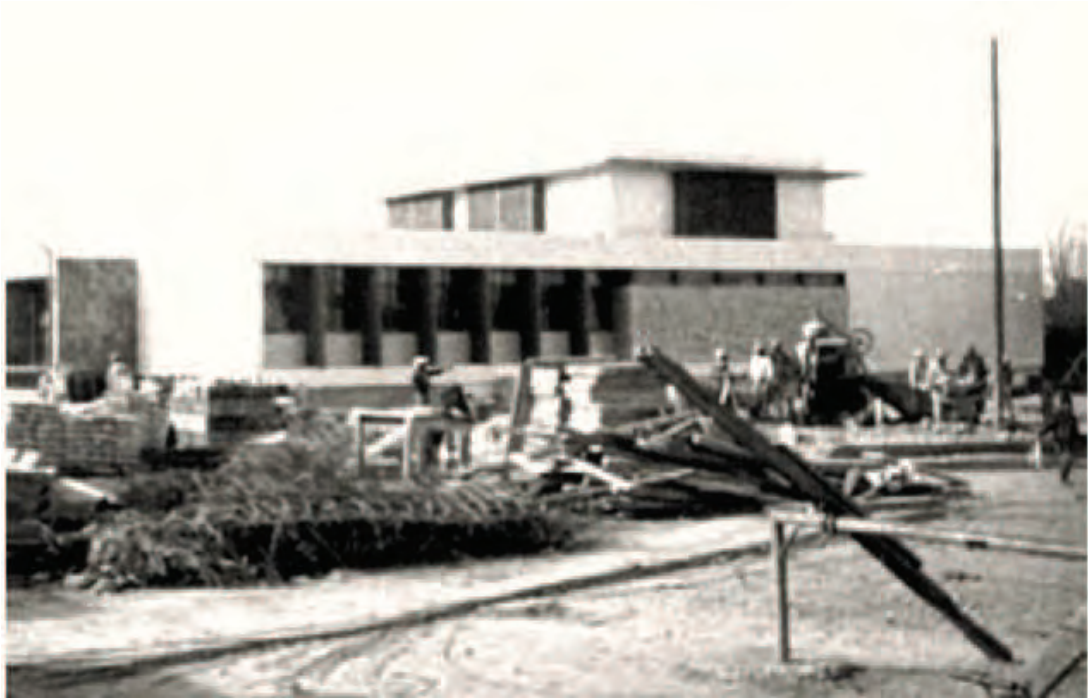
Fachada sur y oriente. (en construcción)
