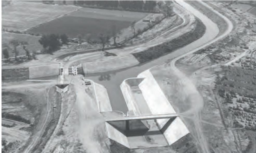
img. Estructura de derivación a Zumpango y Tajo de Nochistongo del Interceptor Poniente.
