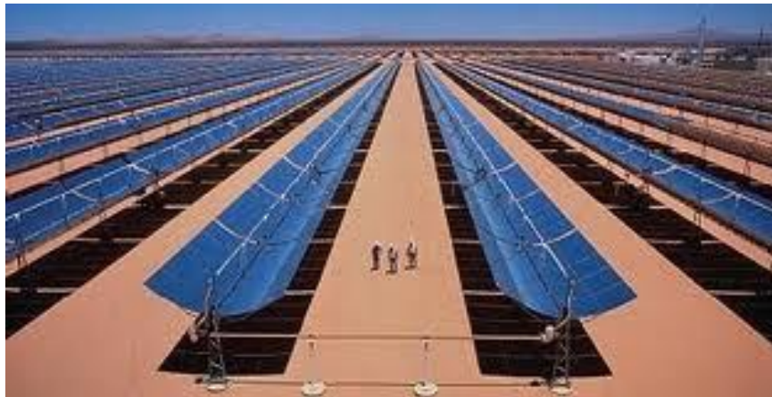
IMAGEN 8. PARQUE SOLAR AGUA PRIETA II, SONORA
