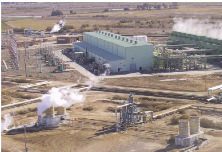
IMAGEN 9. PLANTA GEOTÉRMICA CERRO PRIETO, MEXICALI BAJA CALIFORNIA
