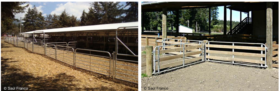
Figura 24 Corrales con paneles de acero galvanizado y con paneles de acero y madera
