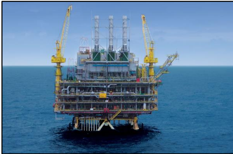
Figura 2-13 Plataforma de rebombeo. ( http://www.hotsitespetrobras.com.br )
