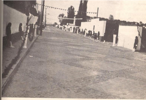
Pavimentación de la Calle Jorge Jiménez Cantú en San Pedro Atzompa.
