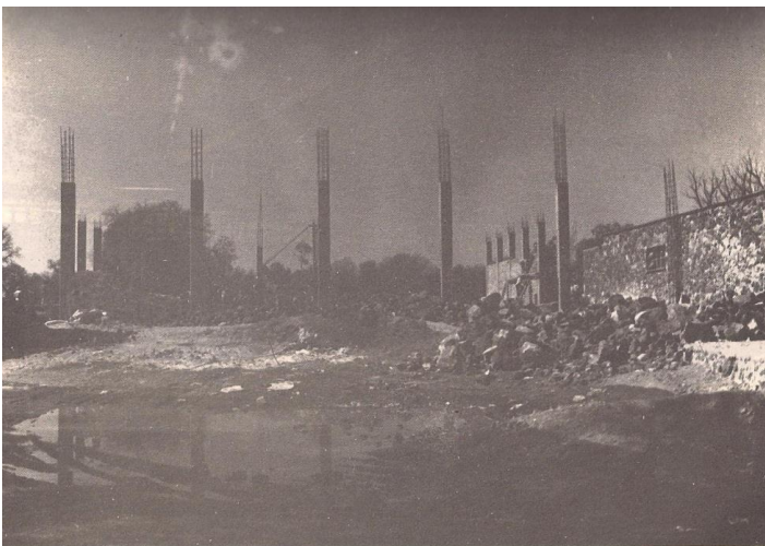
Construcción del Auditorio de la Cabecera Municipal.
