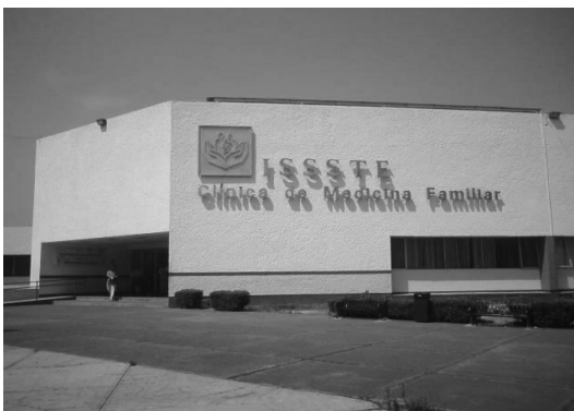
Foto 5. Fachada de la Clínica de Medicina Familiar del ISSSTE Tlalnepantla
