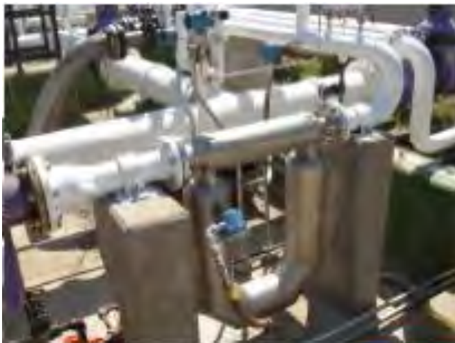
Figura 5.7 Medidor tipo Coriolis en el pozo Coapechaca II
