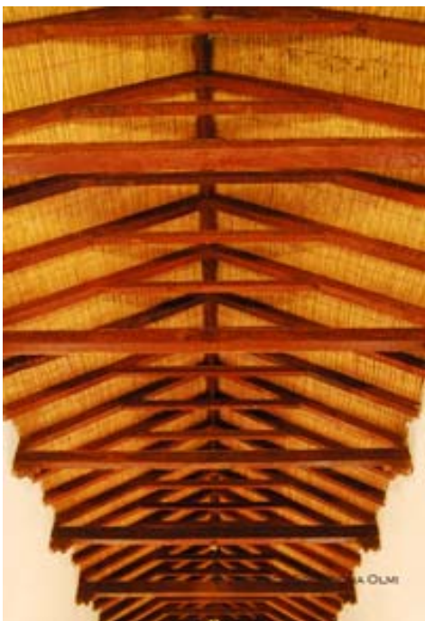
Fig. 128. Vista interior de un techo de Iglesia de San José de Campanas, provincia de La Rioja, Argentina. Techo de tijerales. Mediados del siglo XVIII. http://argentinaparamirar.com.ar/verNota.php?n=647 . Fecha de consulta: 25 de abril de 2013.
