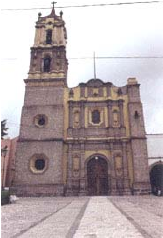
Fig. 122. Vista con la portada principal y la torre del campanario de la Catedral de San Buenaventura en Cuautitlán, Estado de México. http://sic.conaculta.gob.mx/ficha.php?table=monumento_historico_pf&table_id=2265 . Fecha de consulta: 24 de abril de 2013.
