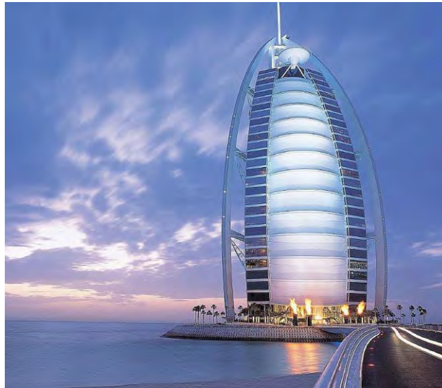
Figura 1.1. Edificio inmótico en Dubái. [25]
