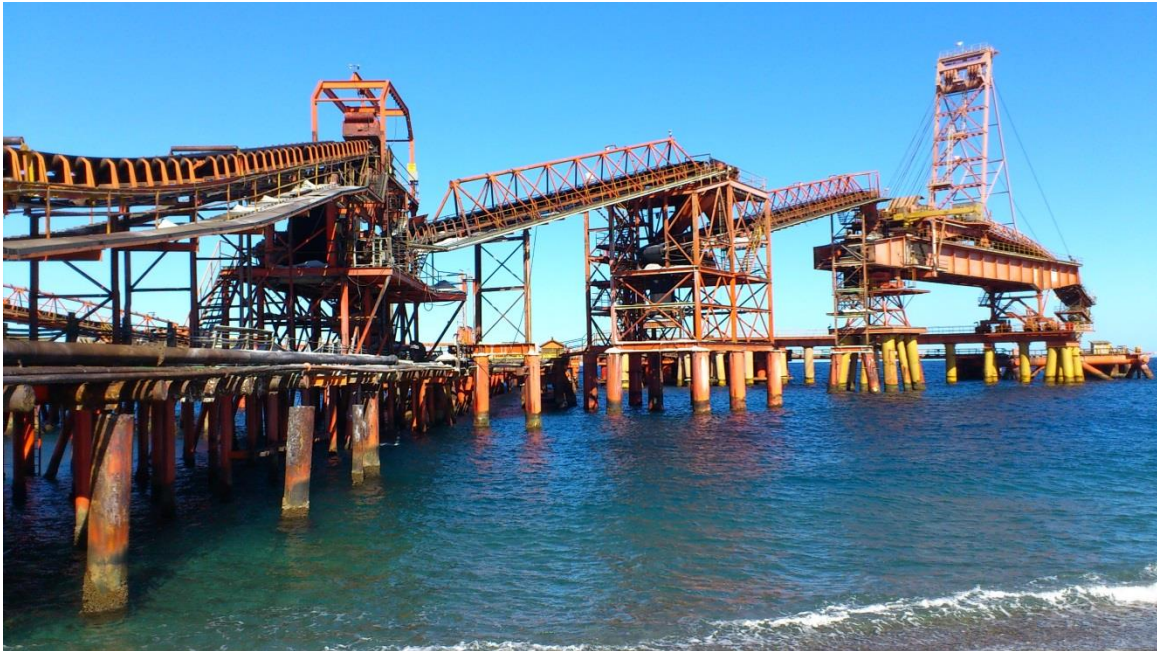
Figura V.8. Instalaciones portuarias de El Morro.
