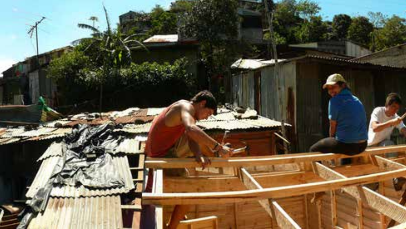
Proceso de construcción de viviendas emergentes
