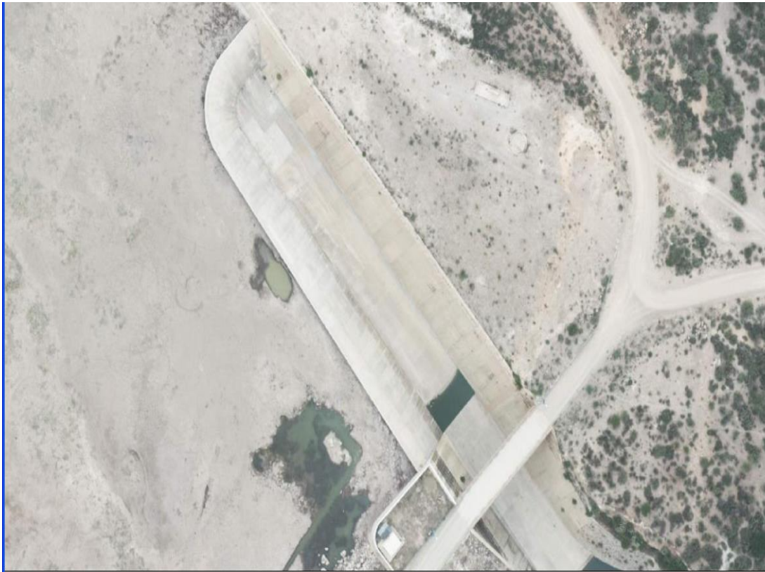
Vertedor de la Presa Cazadero
