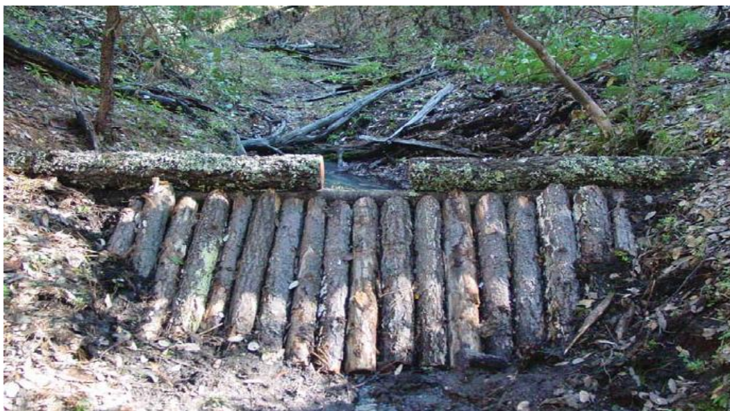
Figura D.23. Presa de morillos. (Cardoza, et al., 2007).
