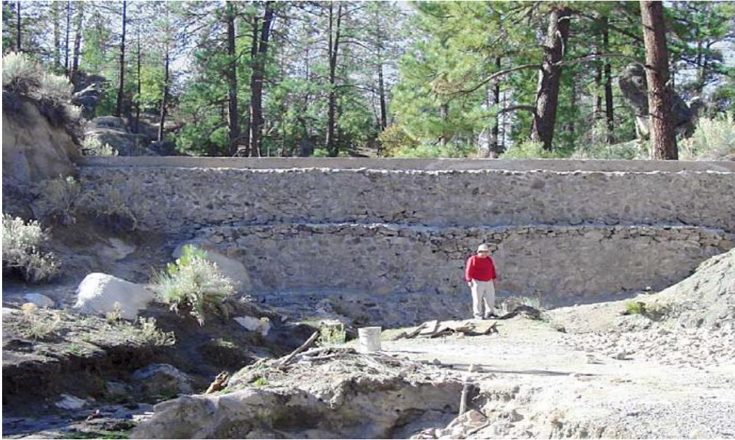
Figura D.28. Presa de mampostería. (Cardoza, et al., 2007).
