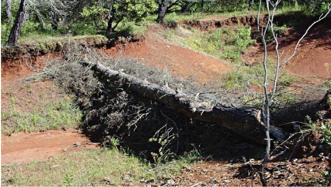
Figura D.24. Presa de ramas. (Cardoza, et al., 2007).
