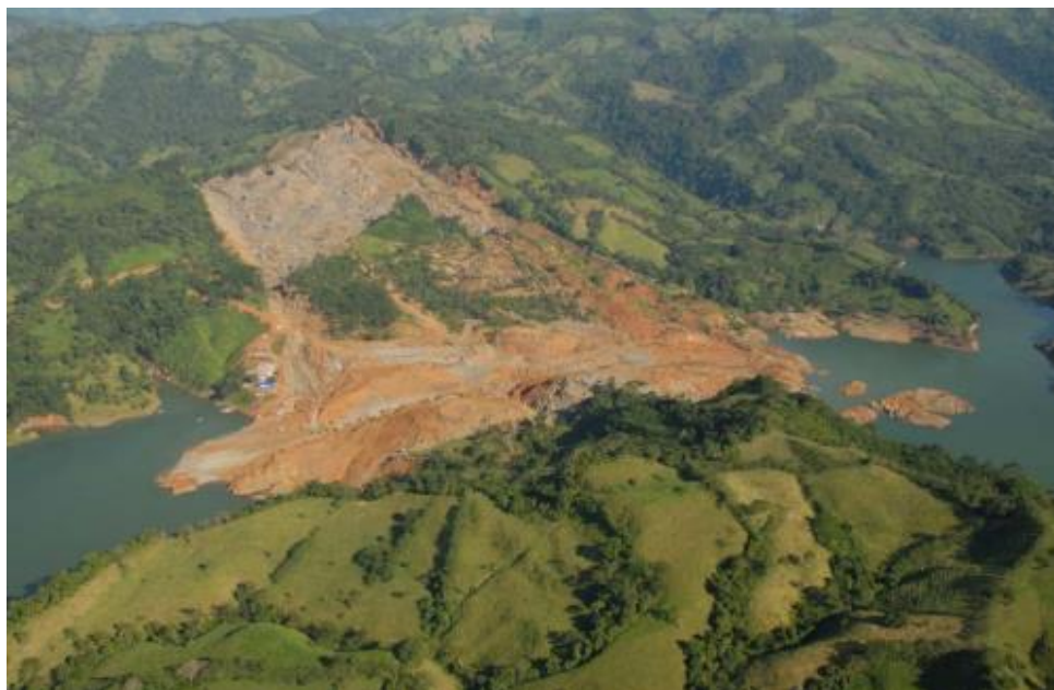
Figura I.3. Deslizamiento de la ladera derecha del río Grijalva en el estado de Chiapas a causa de las lluvias intensas asociadas al frente estacionario número 4 y la tormenta tropical Noel el 4 de noviembre de 2007. (Arvizu, 2009).
