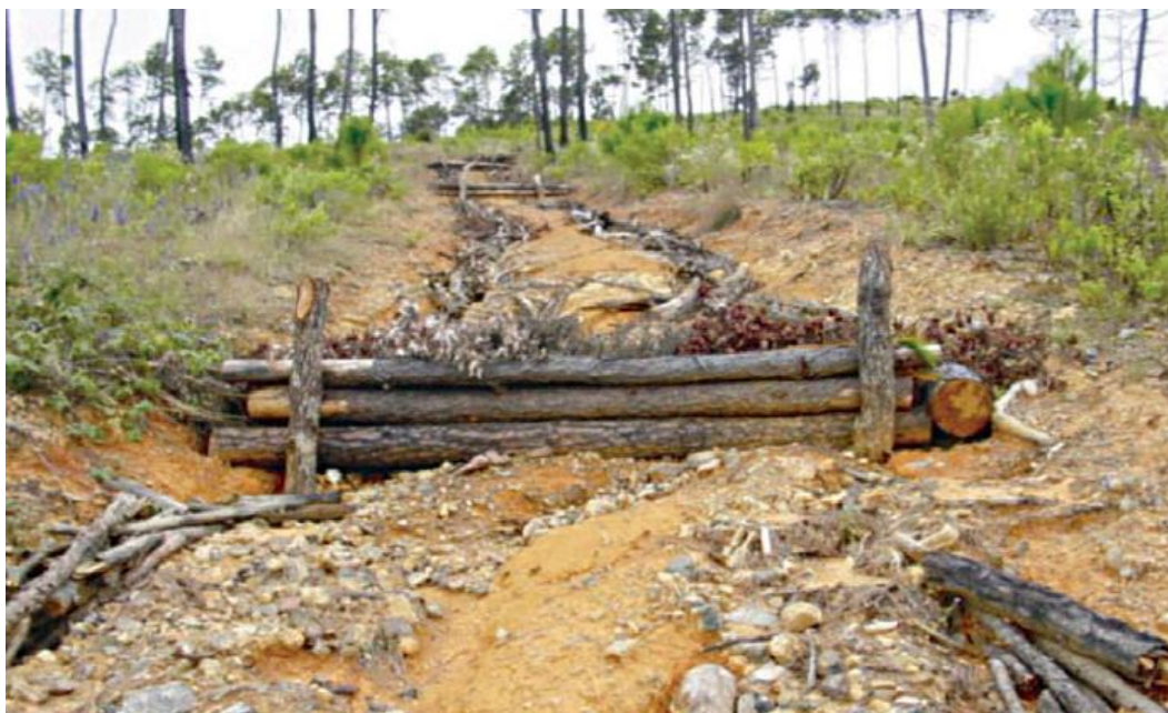
Figura D.32. Protección y conservación de caminos. (Cardoza, et al., 2007).
