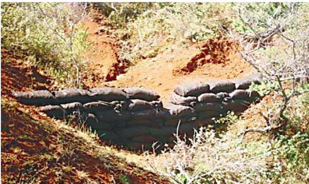
Figura D.26. Presa de geocostales. (Cardoza, et al., 2007).
