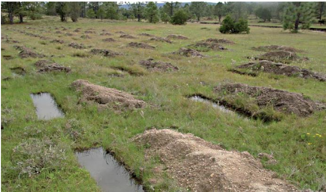
Figura D.6. Zanja trinchera. (Cardoza, et al., 2007).
