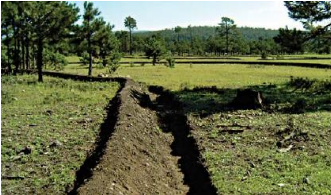
Figura D.3. Bordo para terrazas sucesivas. (Cardoza, et al., 2007).
