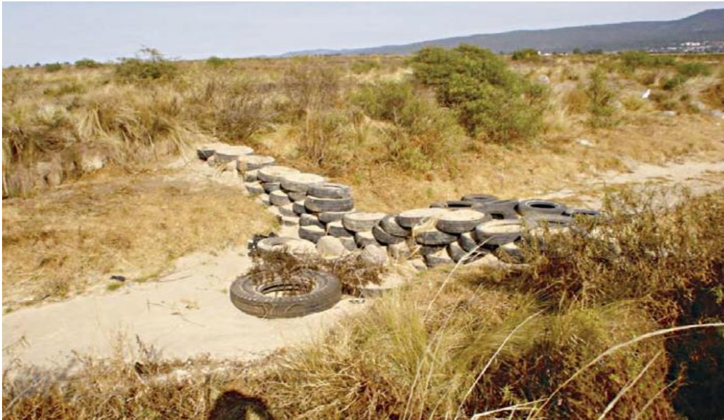
Figura D.27. Presa de llantas. (Cardoza, et al., 2007).
