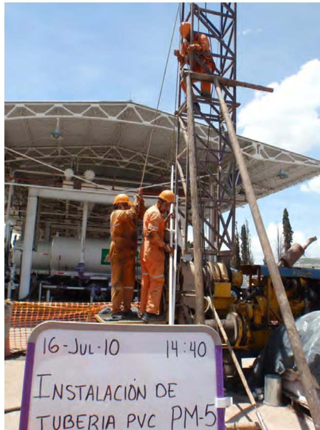
Figura 24. Perforación del pozo de monitoreo PM-05.
