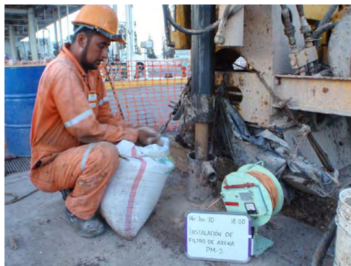
Figura 25. Instalación de pozo de monitoreo.
