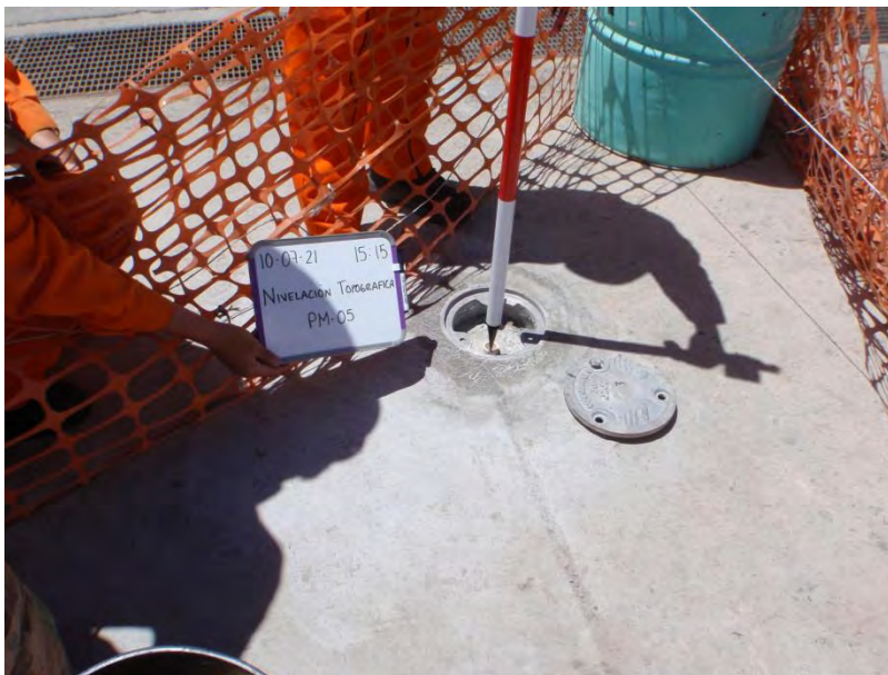
Figura 28. Medición de coordenadas y elevaciones con Estación Total.
