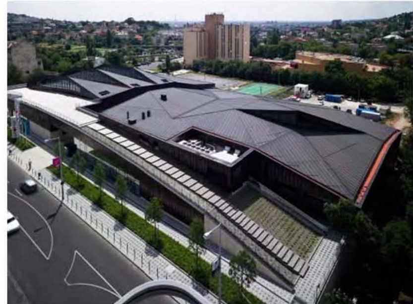
VISTA GENERAL DEL EDIFICIO
