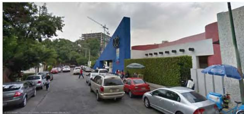
ACCESO PRINCIPAL CALLE CARRILLO PUERTO
