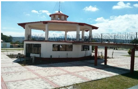
Kiosco localizado en la plaza principal. Foto tomada por los autores
