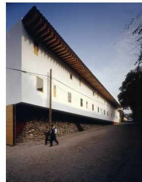
Fachada norte. Imagen tomada por Autores
